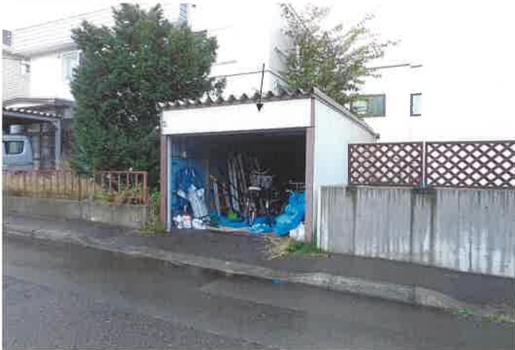
軽量鉄骨造付属車庫
