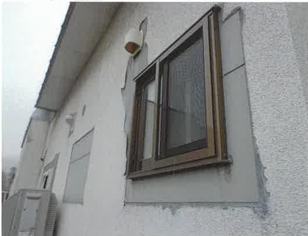
外壁の破損
