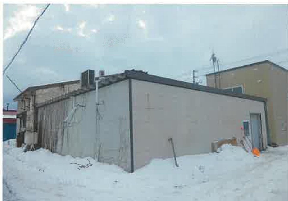
物件 4 外壁の状況（北西側より撮影）
