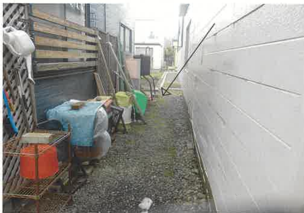
北西側隣接地の灯油タンクの状況
