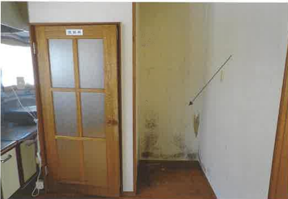
101号室 台所の床の汚損
