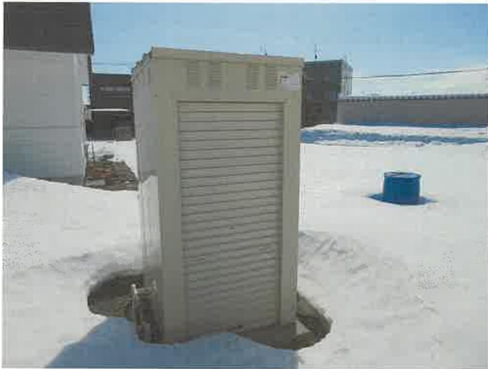
5 LPガス容器収納庫
