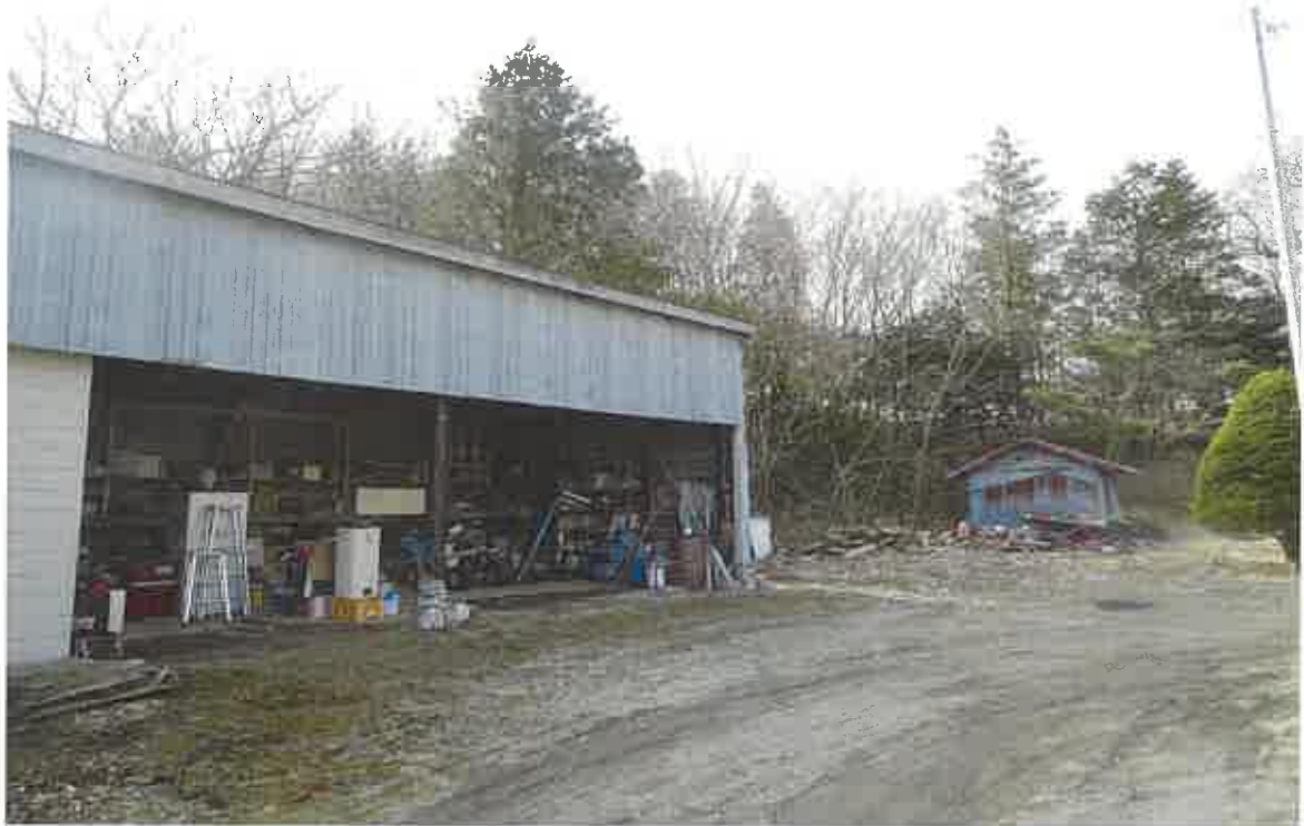
7 木製仮設倉庫及び木製仮設物置①
