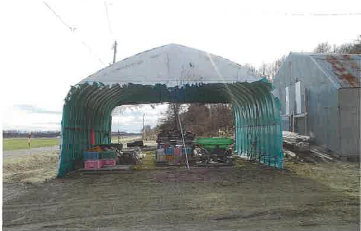
5 スチール製仮設上屋
