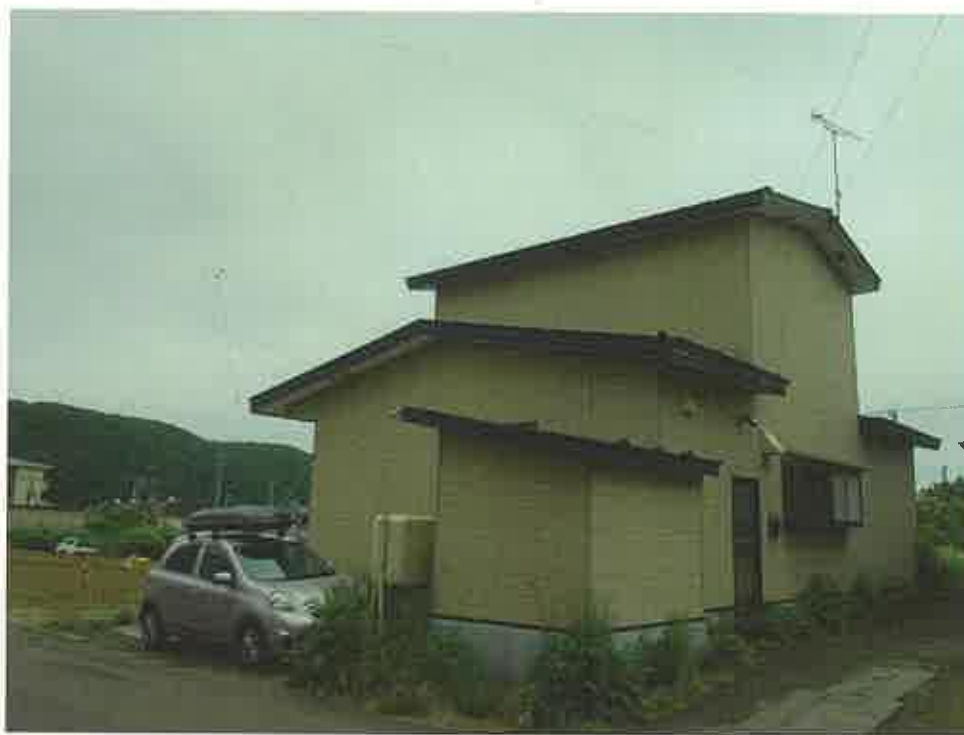
全景(北西側から撮影)
