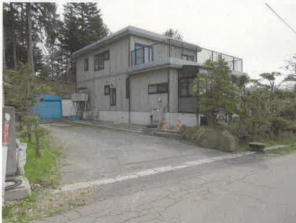
2 建物外観全景（北西側から撮影）
