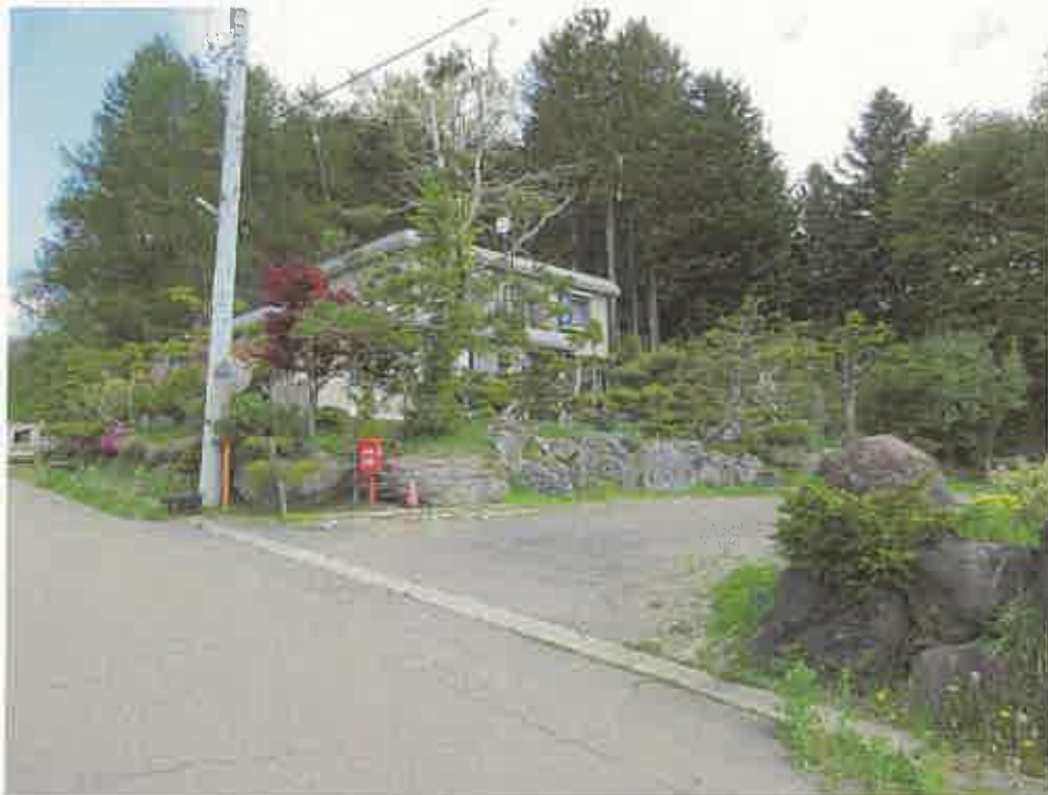
1 建物外観全景（南西側から撮影）
