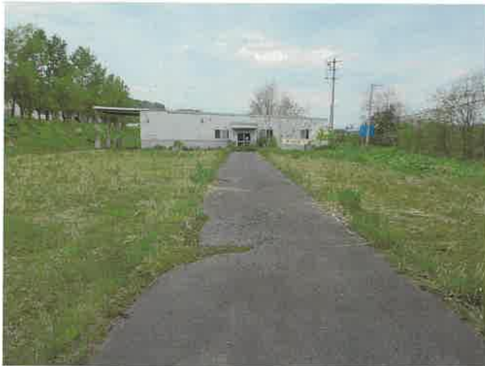
1 建物外観全景（町道側から撮影）
