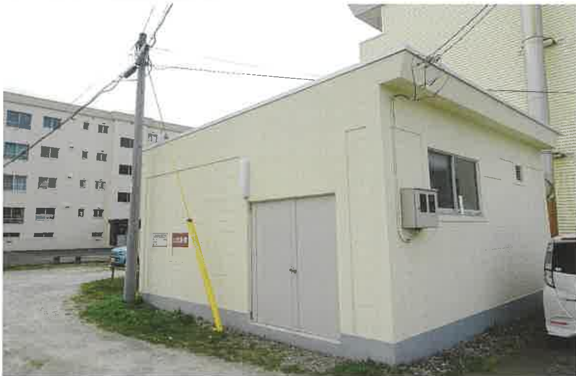
7 ボイラー室外観（物件5）
