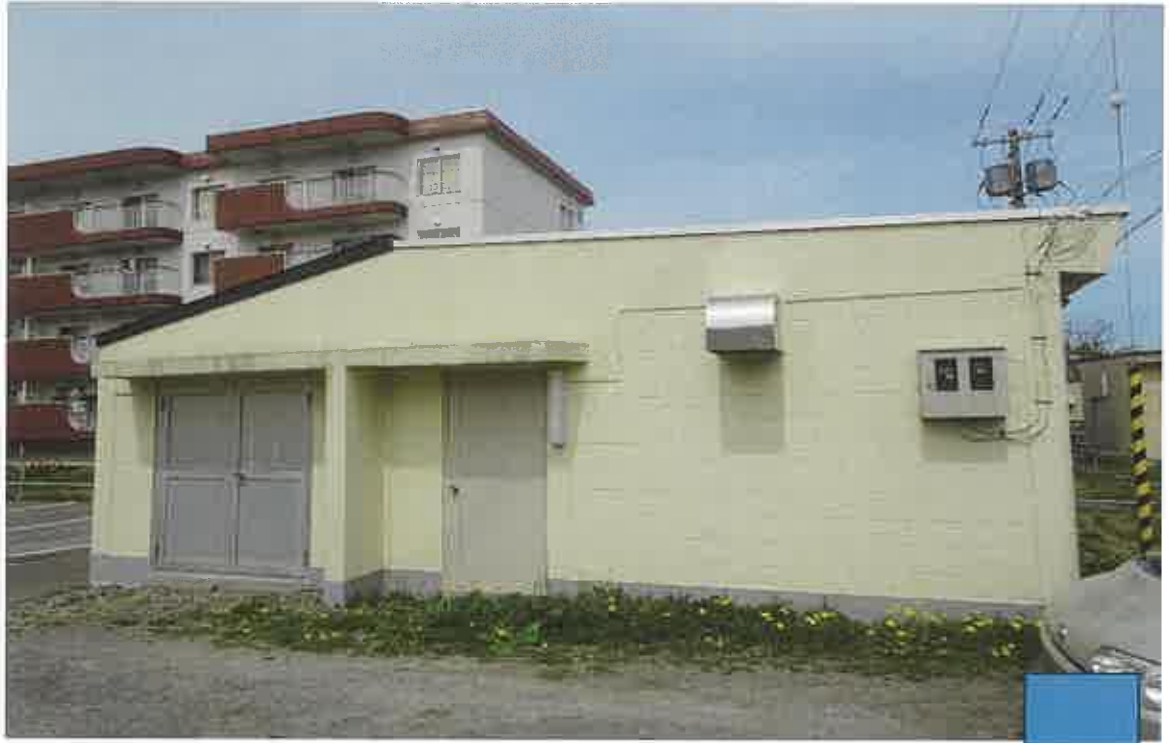
5 ポンプ室外観（物件4）
