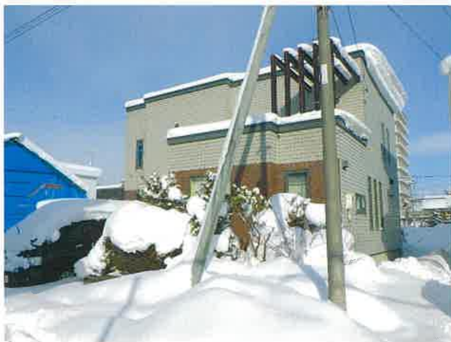
本件土地の形状、本件建物の外観
