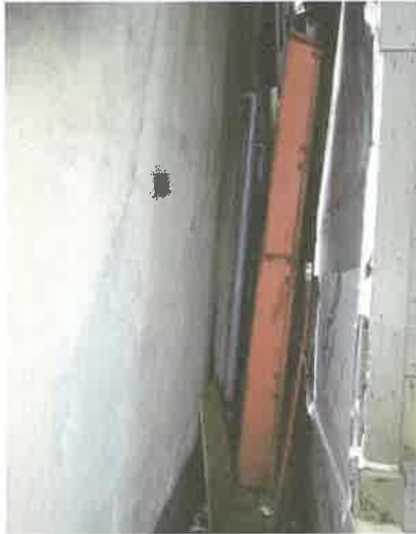
外壁の給水管を保護する鉄製の囲いの状況
