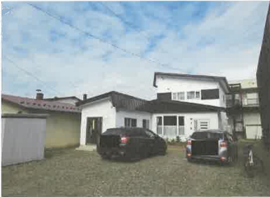
本件建物の外観、本件土地の形状、仮設物置
