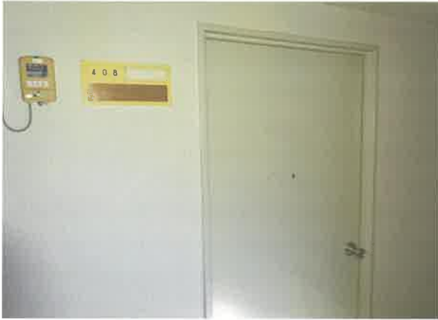
本件建物の入口付近の状況
