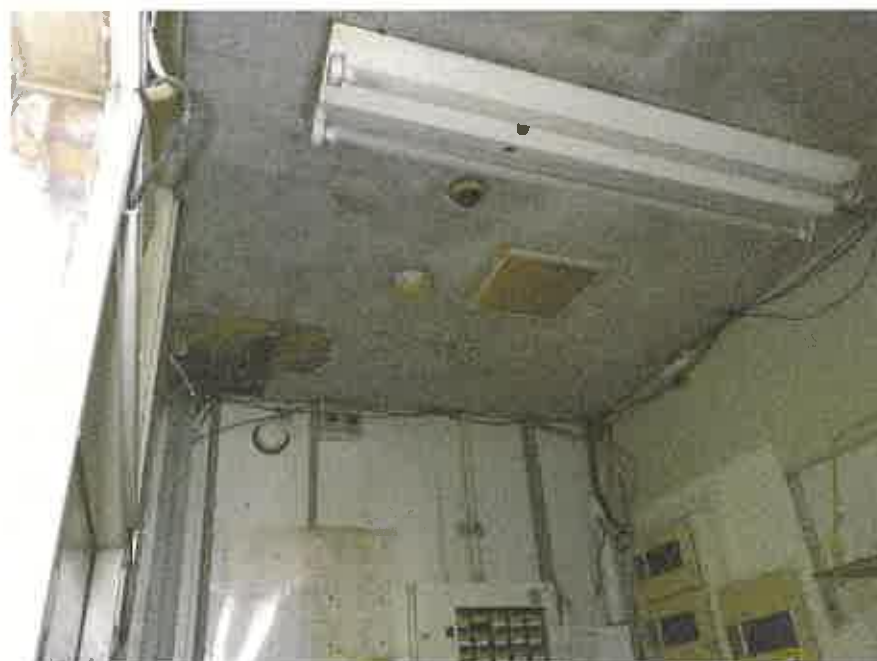
物件6の1階警備員室の天井部分
