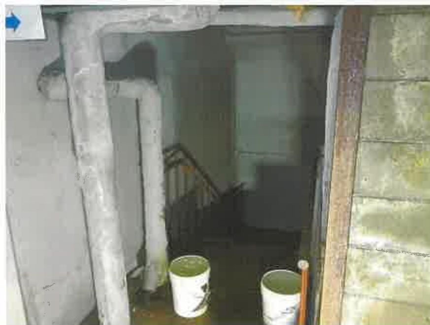
一棟の建物の7階略南側の階段部分
