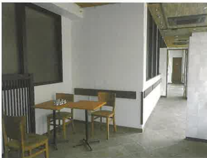
一棟の建物の1階略東側の元店舗部分
