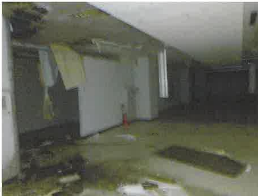
物件 3 の 3 階略南側の元店舗部分
