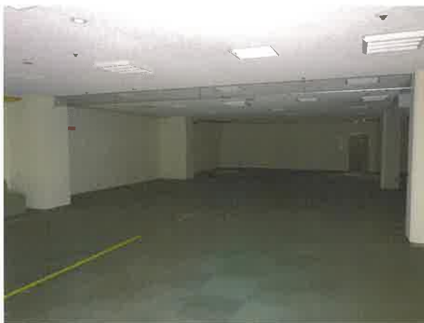
物件7の6階略南東側の元店舗部分
