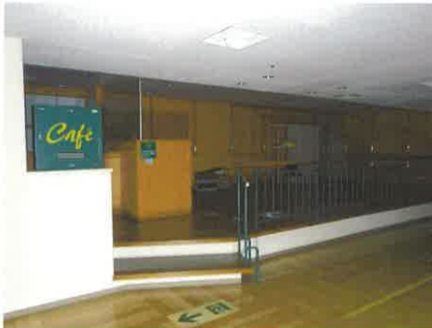
物件 7 の 6 階略北側の元店舗部分
