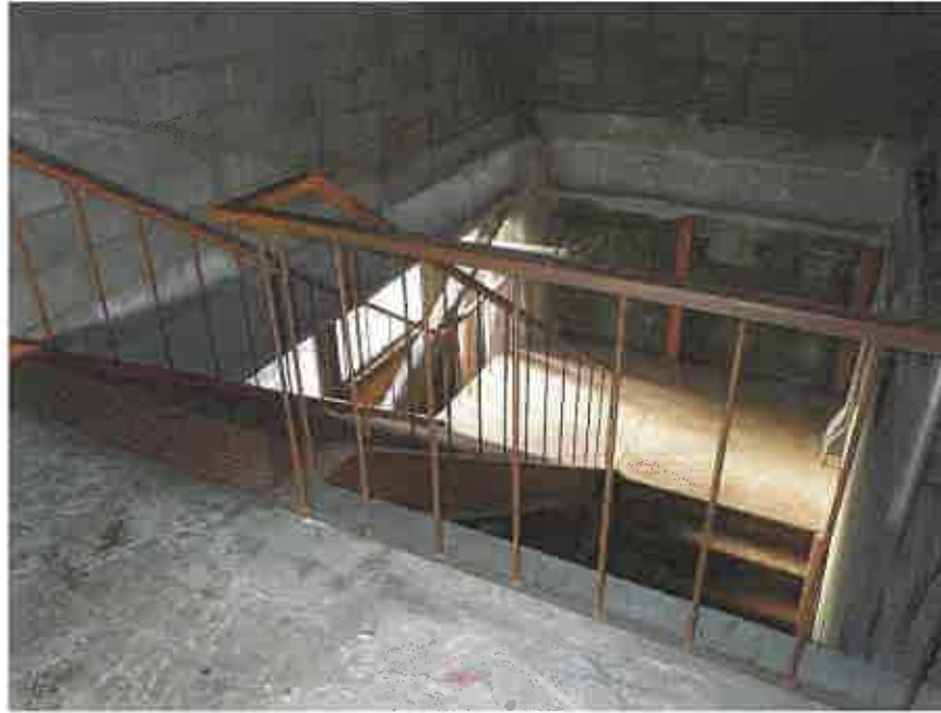
略南東側塔屋の階段部分
