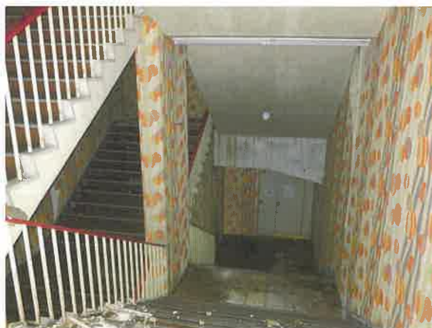
一棟の建物の1階略南側の階段部分
