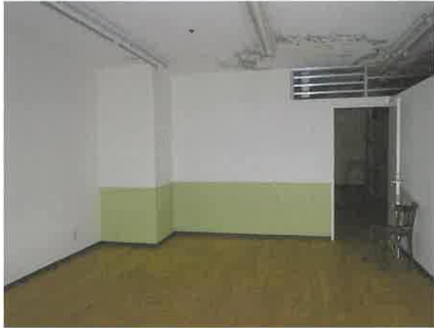
物件5の5階略南東側のバックヤード
