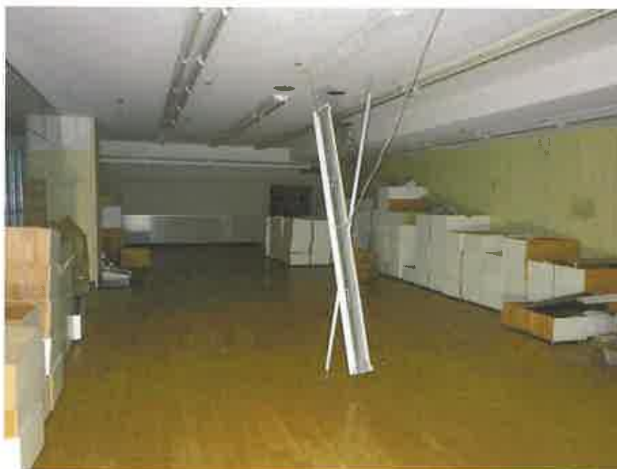
物件 5 の 5 階略北側のバックヤード
