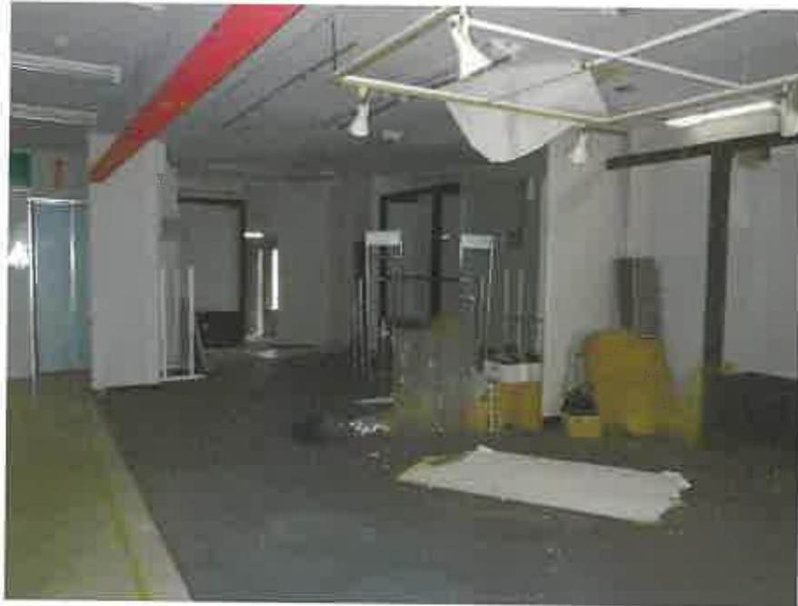
物件 5 の 4 階略北東側の元店舗部分
