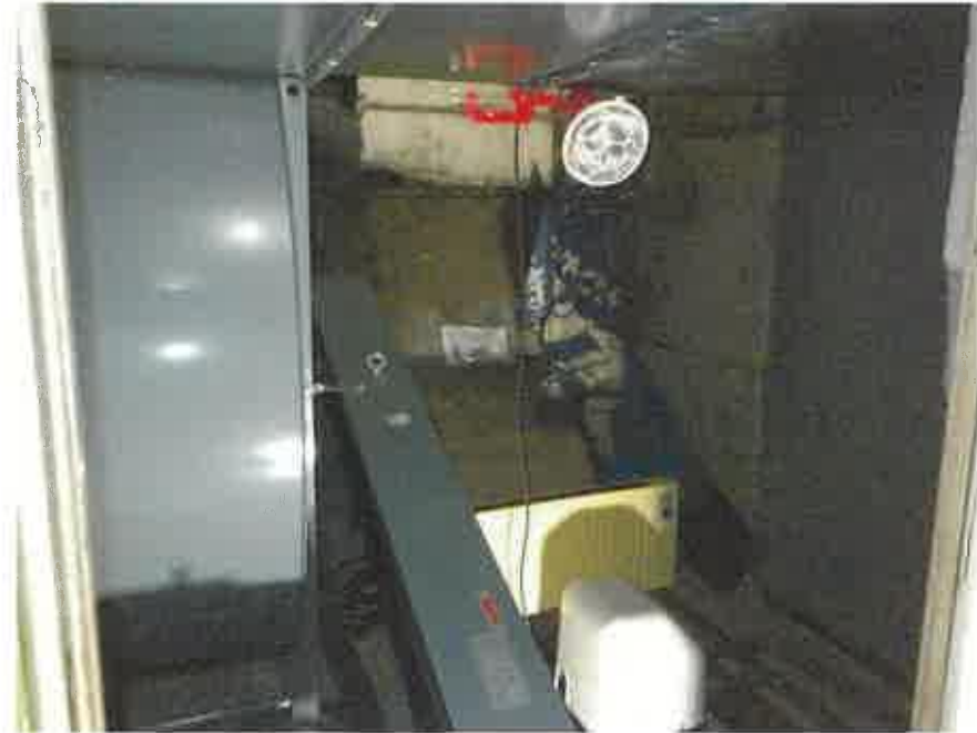
物件7の8階略北側の排煙機械室
