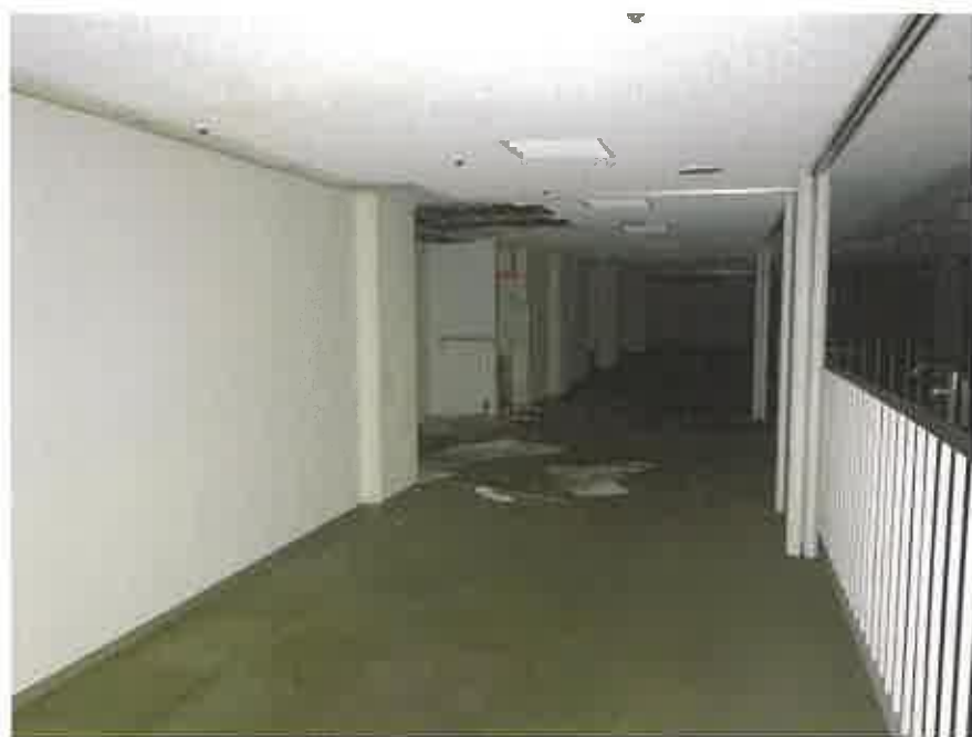
物件 7 の 6 階略東側の元店舗部分
