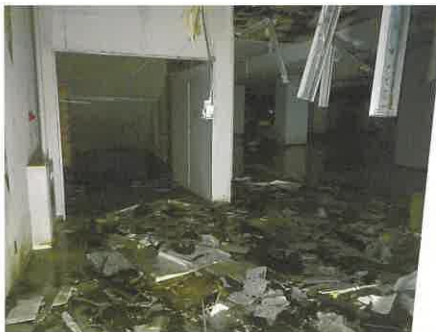
物件3の1階略南側の階段入口付近
