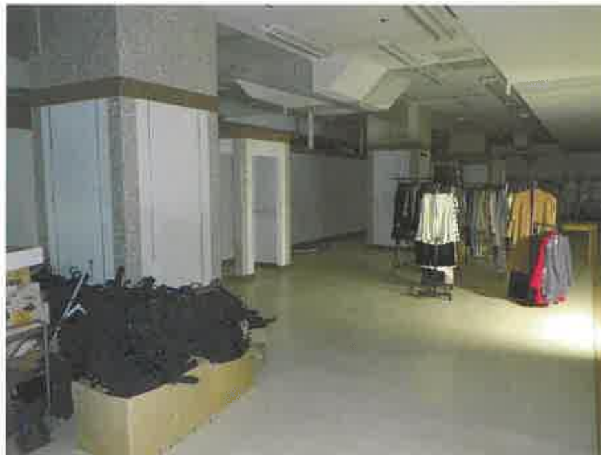
物件3の1階の元店舗部分
