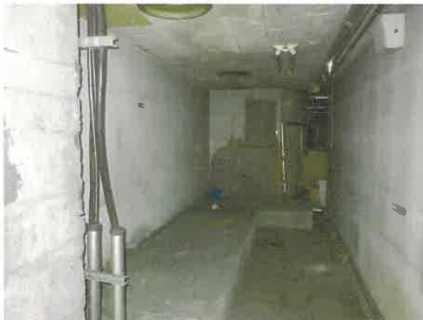
物件3の2階略西側の倉庫
