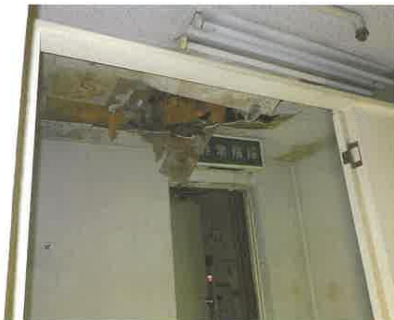
物件7の7階略北西側の天井部分
