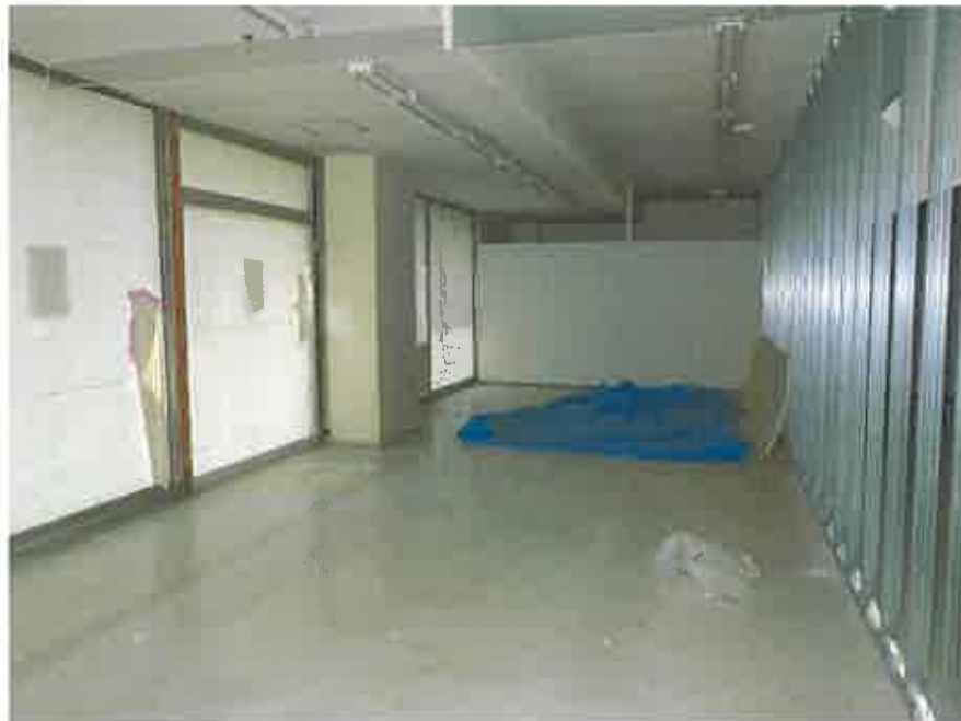
物件3の1階略北側の事務所（改装中）部分
