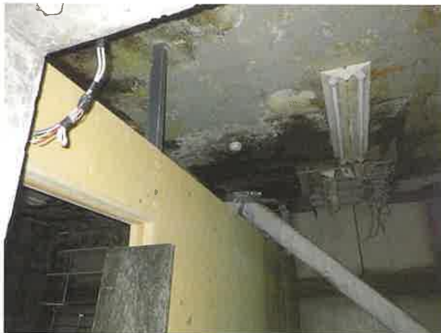
物件 9 の 4 階略北西側の倉庫
