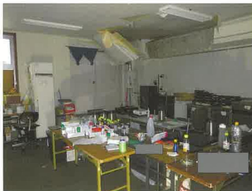
物件7の8階中央付近の配膳・スタッフ室
