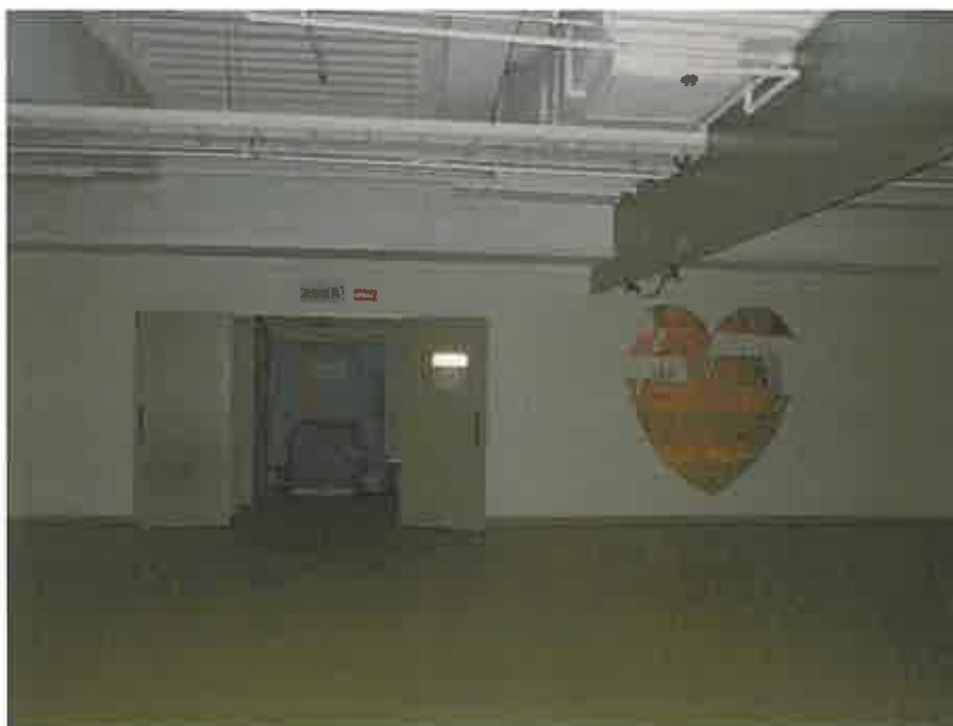
物件 3 の 3 階略北側の元店舗部分
