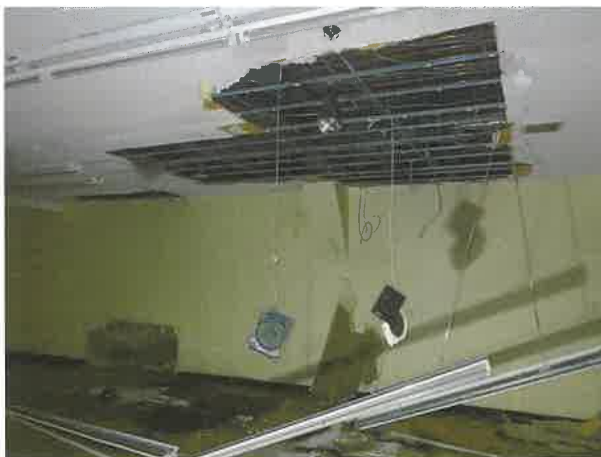
物件 5 の 5 階略南西側の元店舗の天井部分
