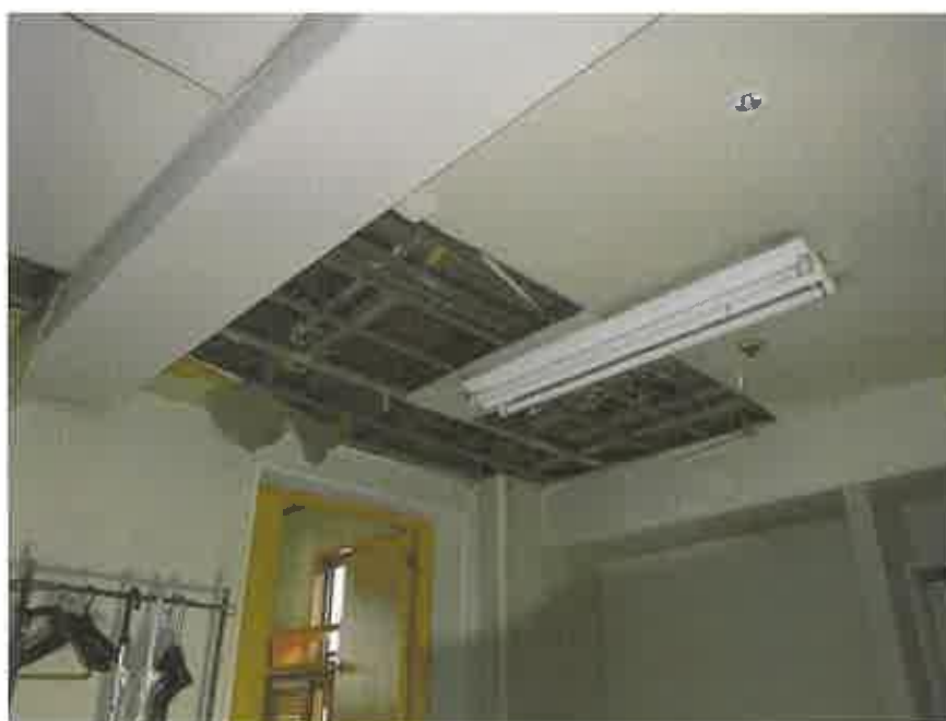
物件7の7階略北東側の事務室の天井部分
