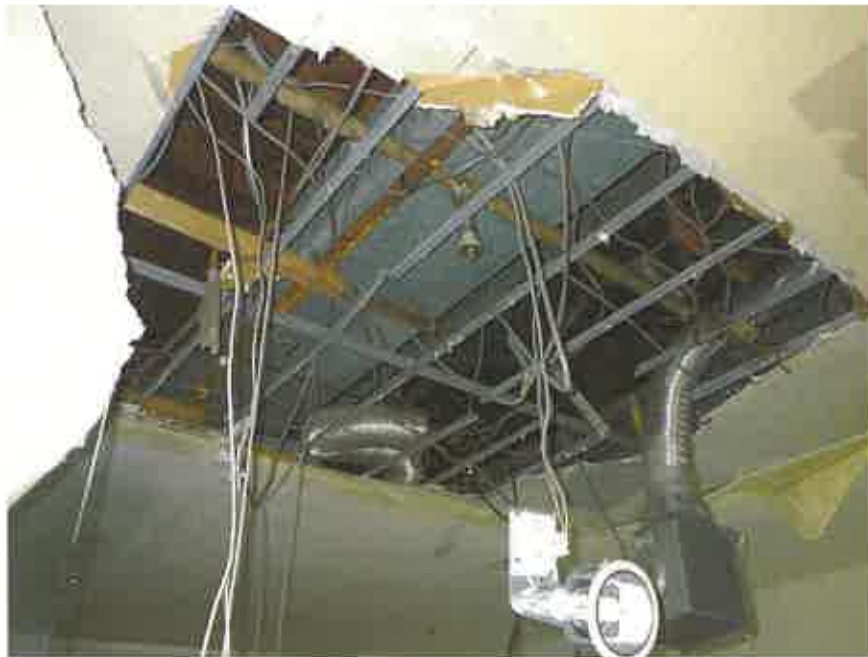
物件 7 の 8 階略東側の元店舗の天井部分
