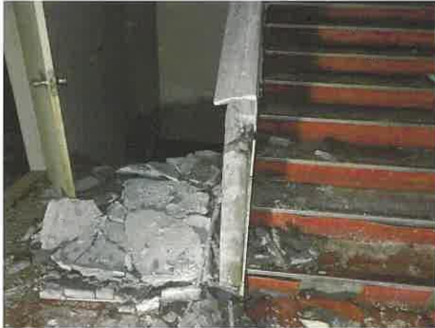
一棟の建物の7階略北西側の階段部分
