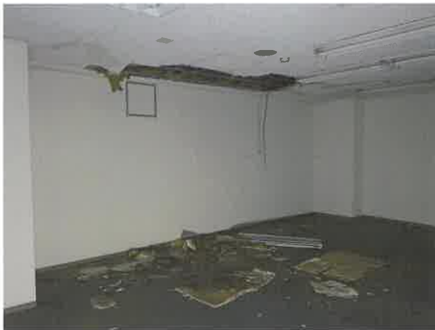
物件 7 の 6 階略南東側の元店舗の天井部分
