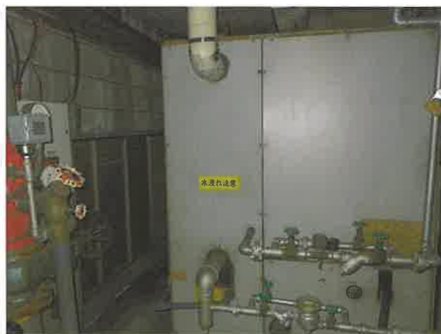
物件3の2階略南西側の機械室
