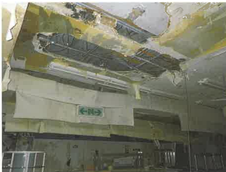
物件3の1階略南東側の天井部分
