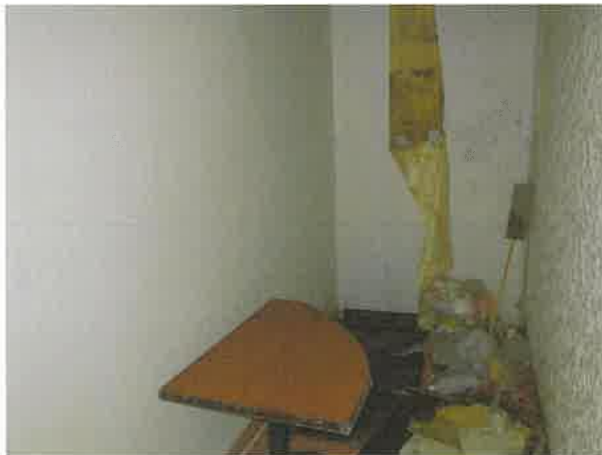
物件 3 の 3 階略南西側のバックヤード
