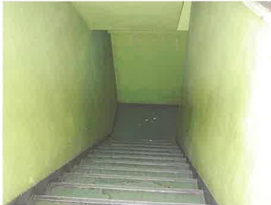
一棟の建物の 8 階略北東側の階段部分
