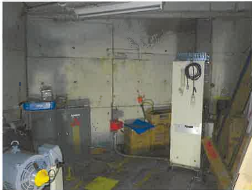
物件7の8階略北東側のE V機械室
