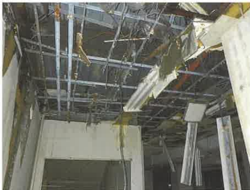
物件3の1階略南側の階段入口付近の天井部分
