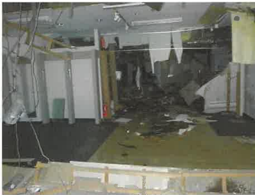
物件3の2階略東側の元店舗部分
