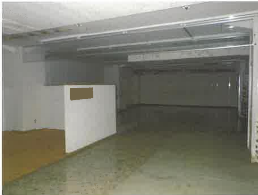
物件 3 の 3 階略南東側の元店舗部分
