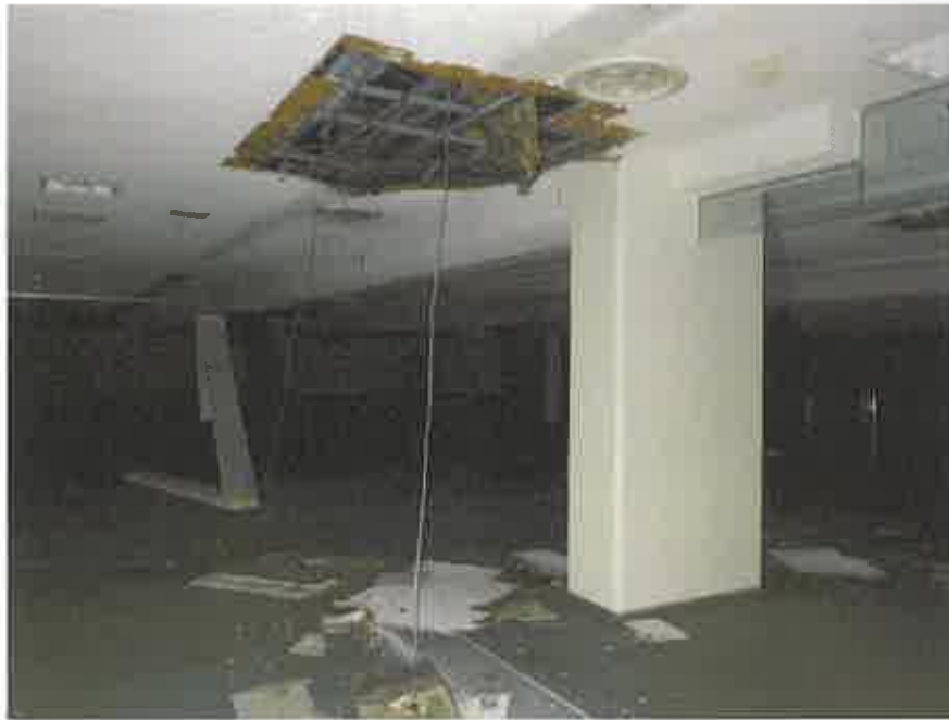
物件7の6階略南側の元店舗の天井部分
