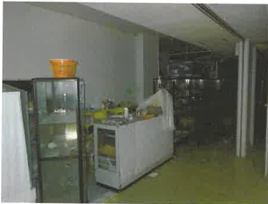
物件 5 の 4 階略東側の元店舗部分
