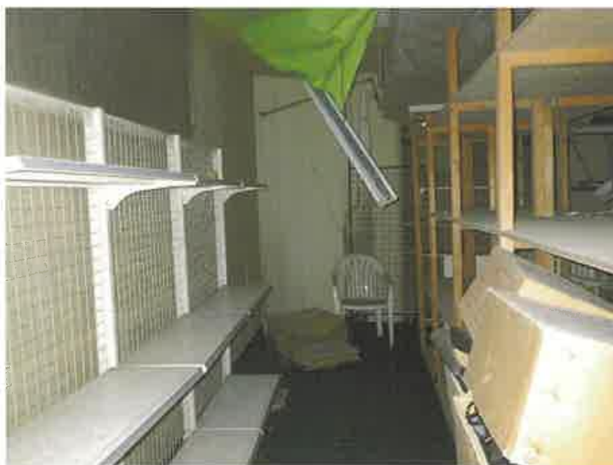
物件3の3階略西側のバックヤード
