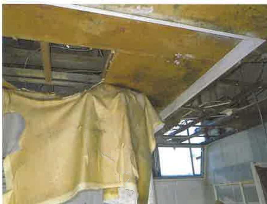
物件 8 の 3 階略北西側の倉庫
