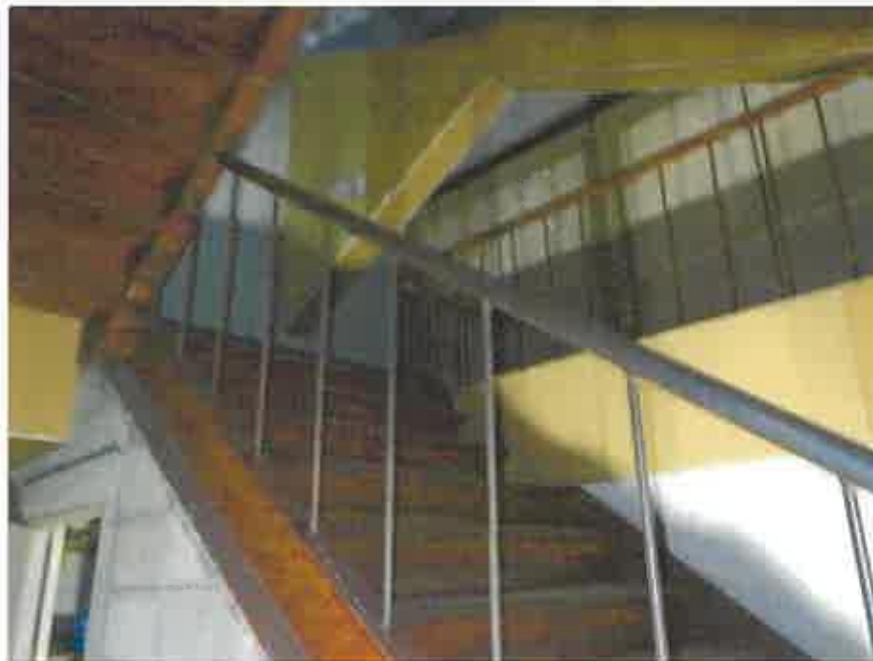
一棟の建物の7階略南東側の階段部分
