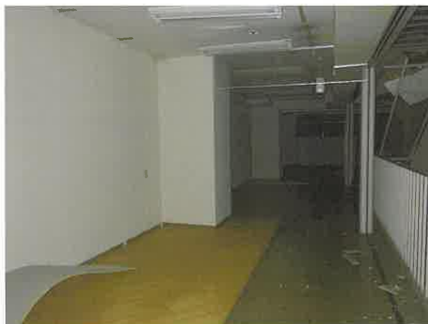
物件3の3階略東側の元店舗部分
