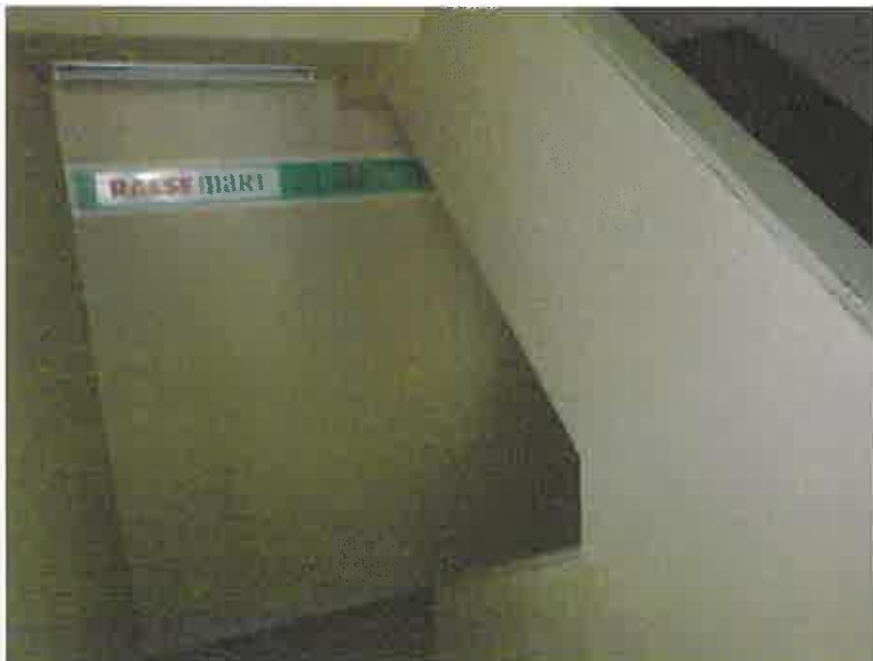
一棟の建物の1階略北東側の階段部分
