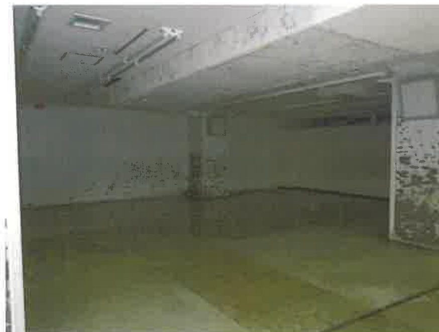
物件 3 の 3 階略南東側の元店舗部分
