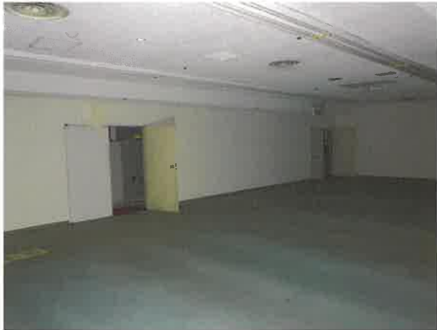
物件7の6階略南西側の元店舗部分
