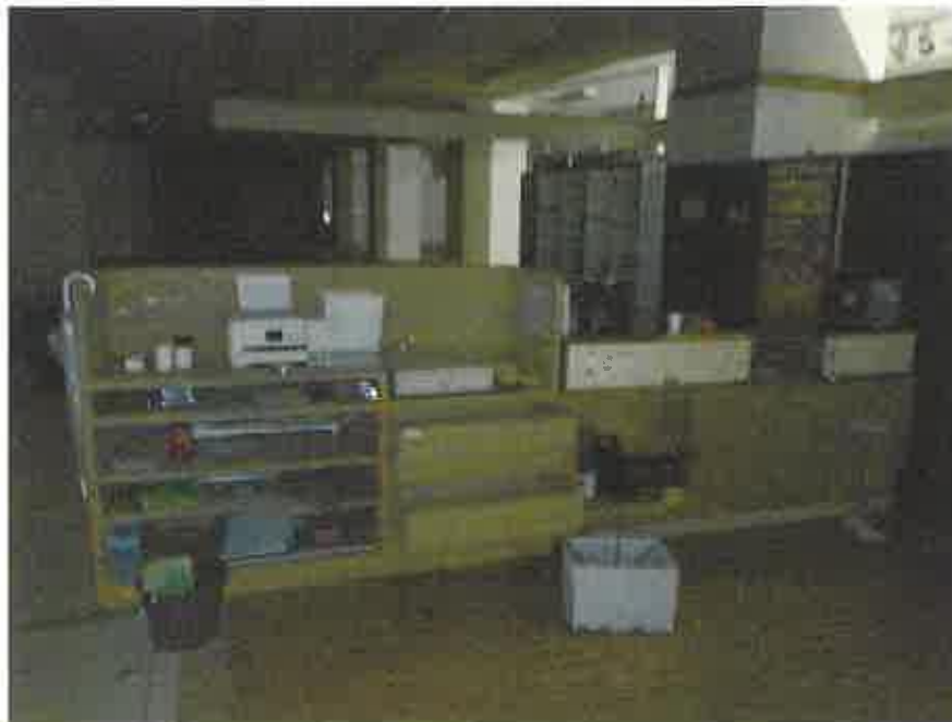
物件3の1階略東側の元店舗部分
