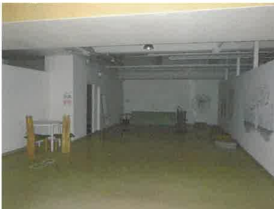
物件 3 の 3 階略北側の元店舗部分
