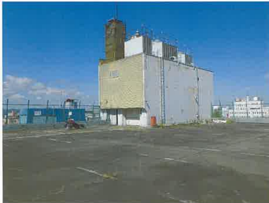
一棟の建物の屋上部分
