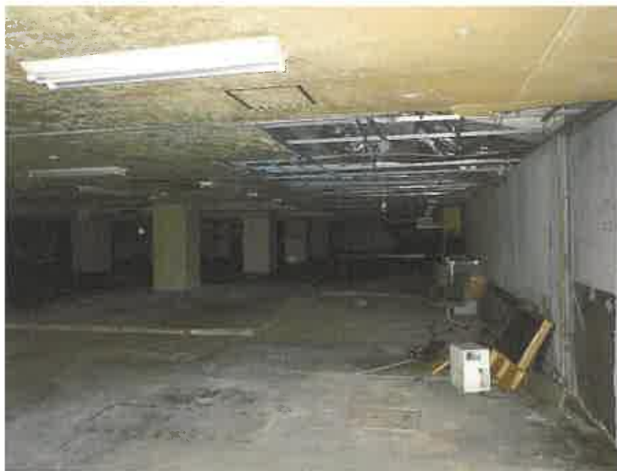
物件3の地下1階略西側部分
