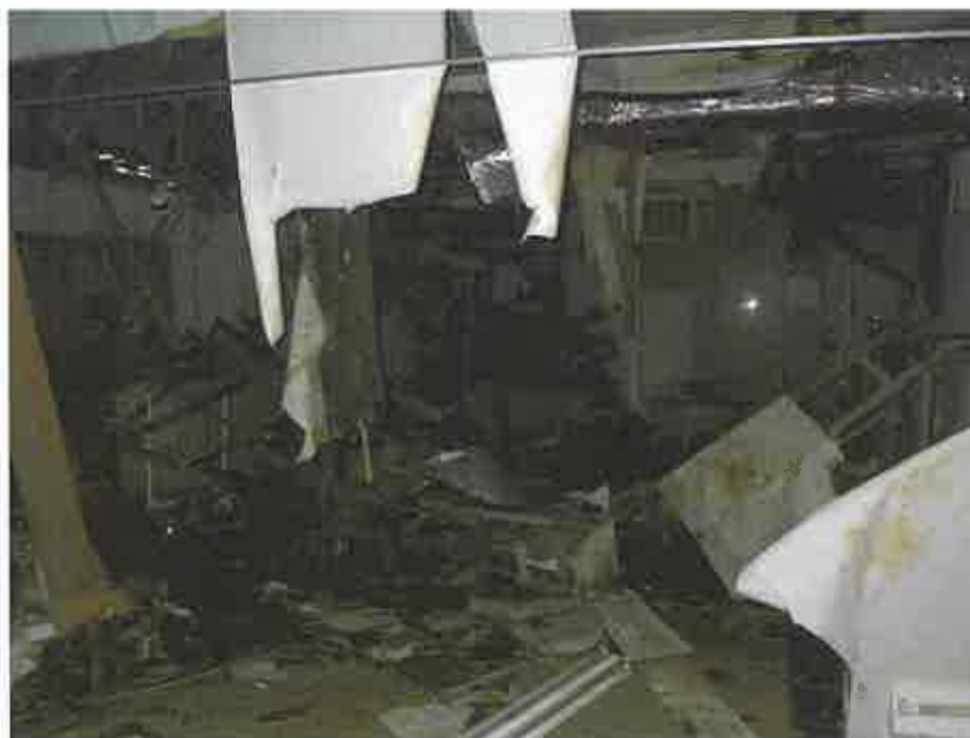
物件3の2階略南東側の元店舗部分
