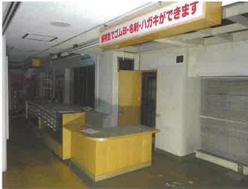
物件 5 の 5 階略東側の元店舗部分
