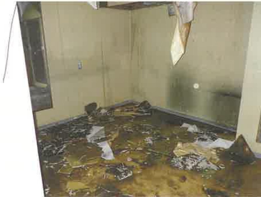
物件3の3階略西側のバックヤード
