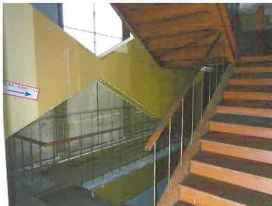
一棟の建物の 8 階略南東側の階段部分
