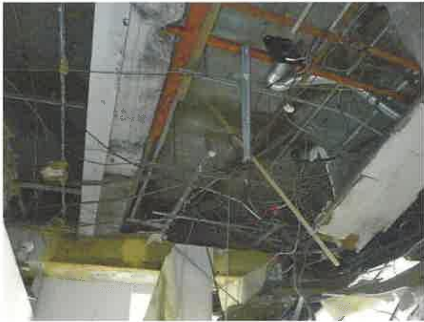
物件4の1階元店舗の天井部分
