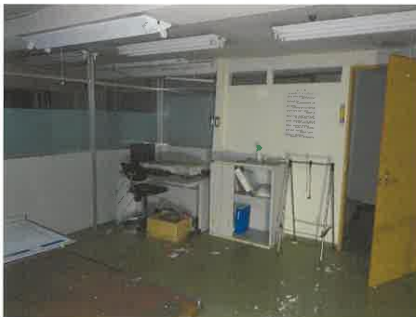
物件7の7階略北東側の事務室
