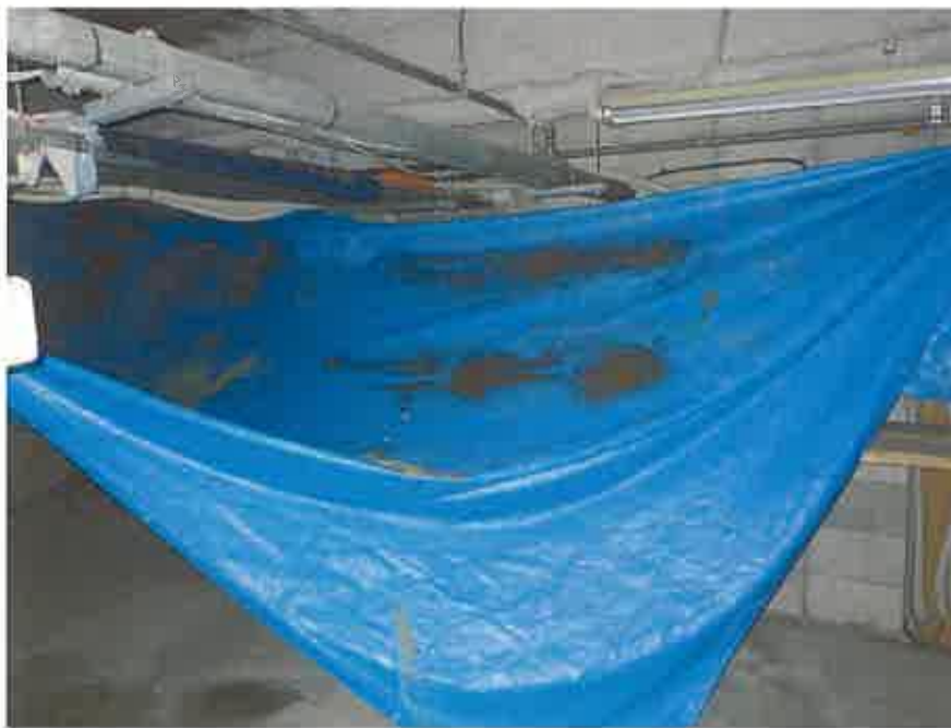
物件 5 の 5 階略南西側の倉庫
