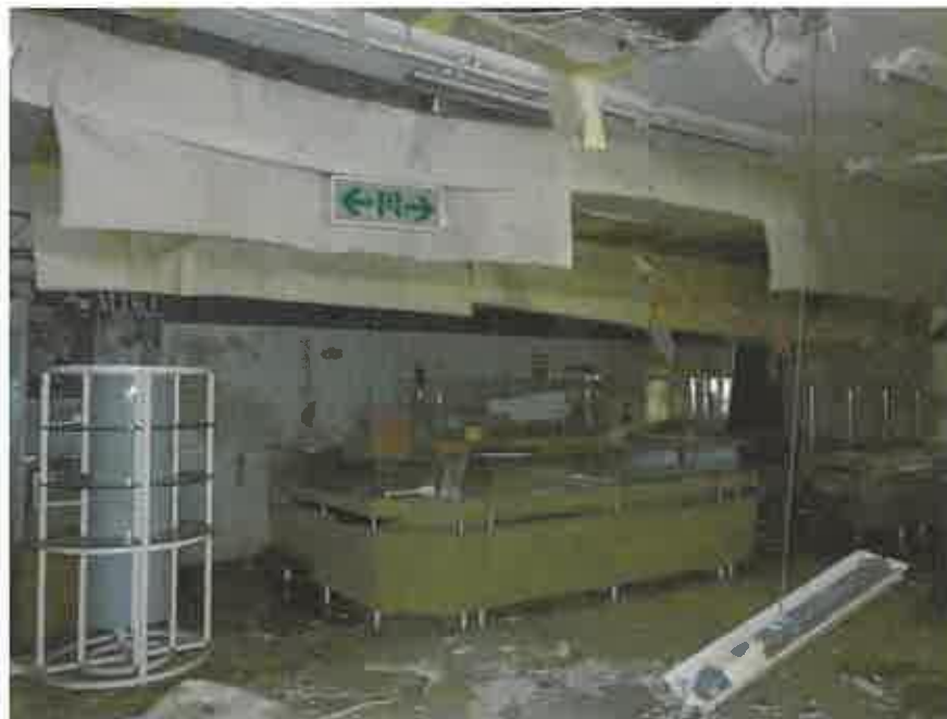
物件3の1階略南東側の元店舗部分
