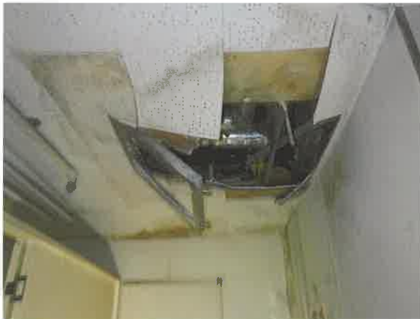
物件7の7階略北西側の天井部分
