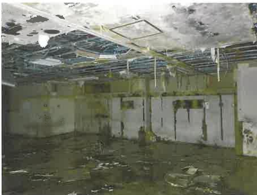
物件4の地下1階元店舗の天井部分
