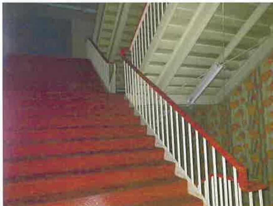
一棟の建物の3階略南側の階段部分
