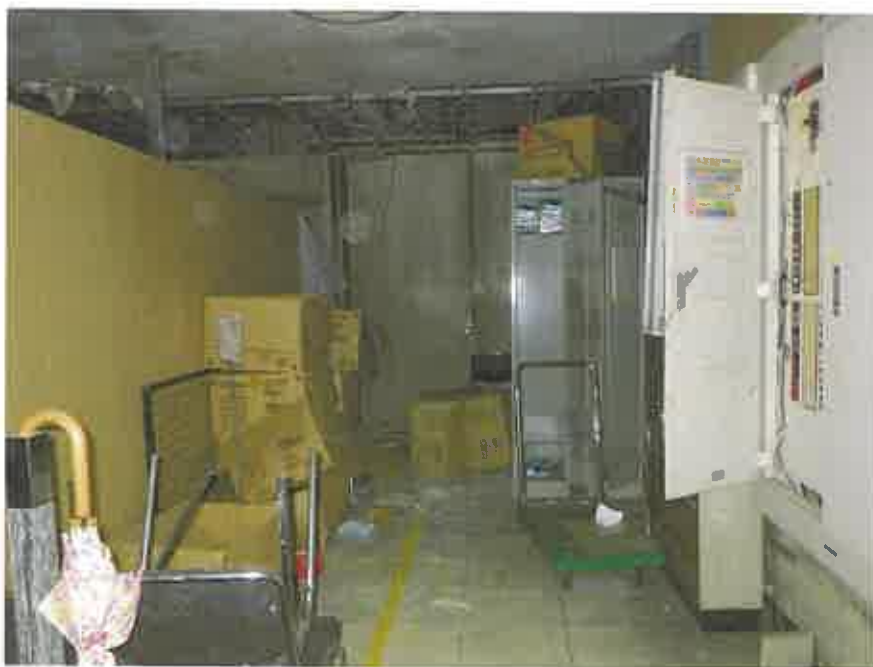
物件5の4階略南西側の通路部分
