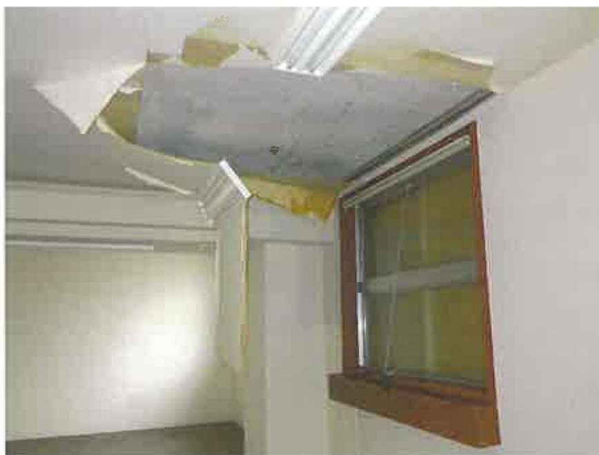
物件 7 の 8 階中央付近の学習室の天井部分
