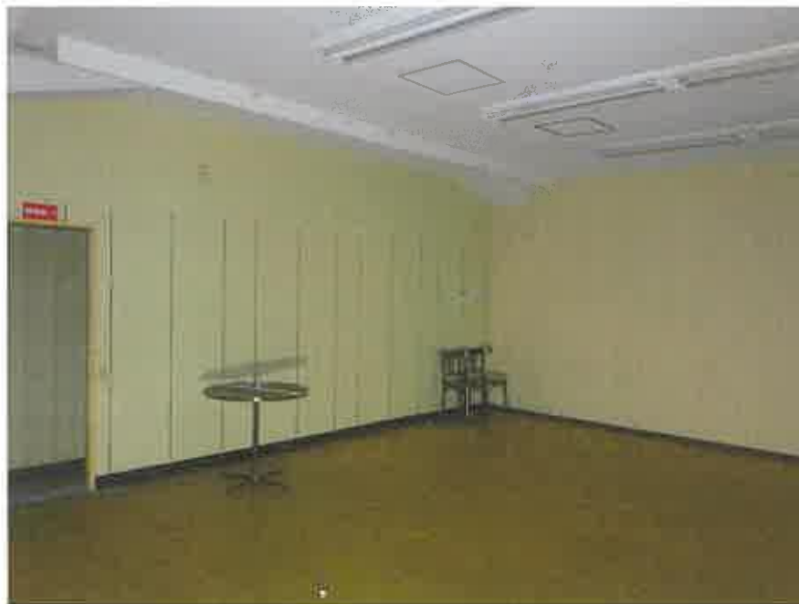
物件 5 の 5 階略東側の元店舗部分
