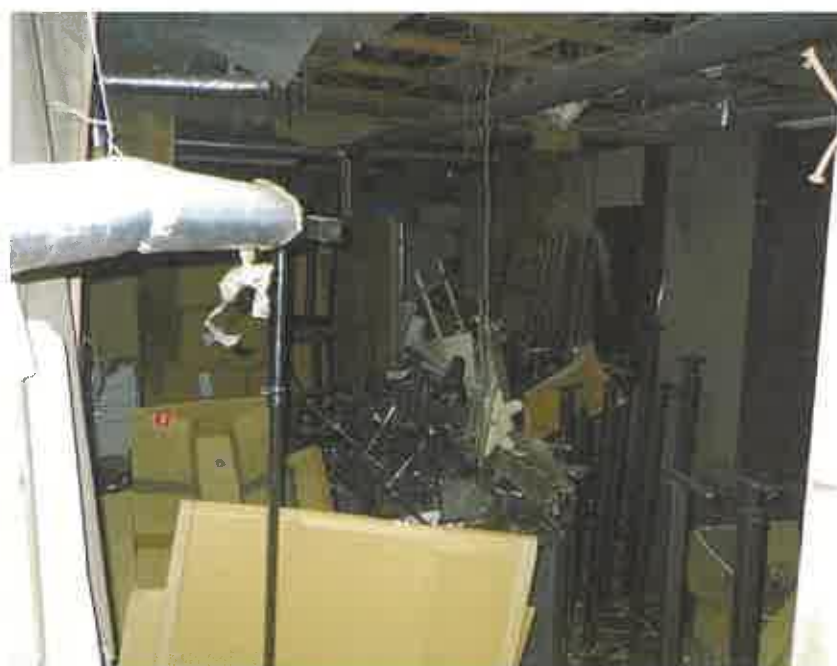
物件3の2階略北西側の倉庫
