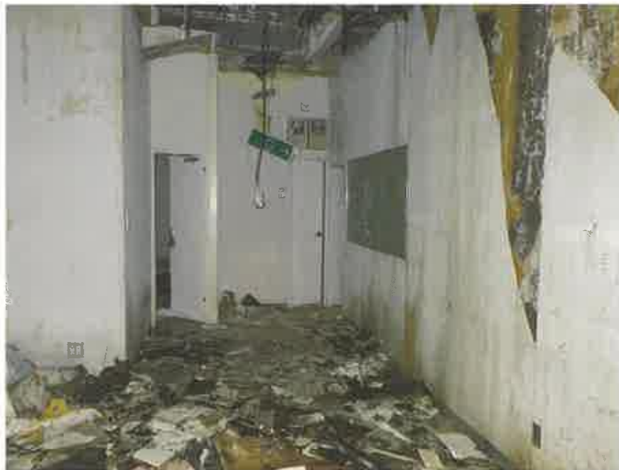
物件3の1階略南側の階段入口付近
