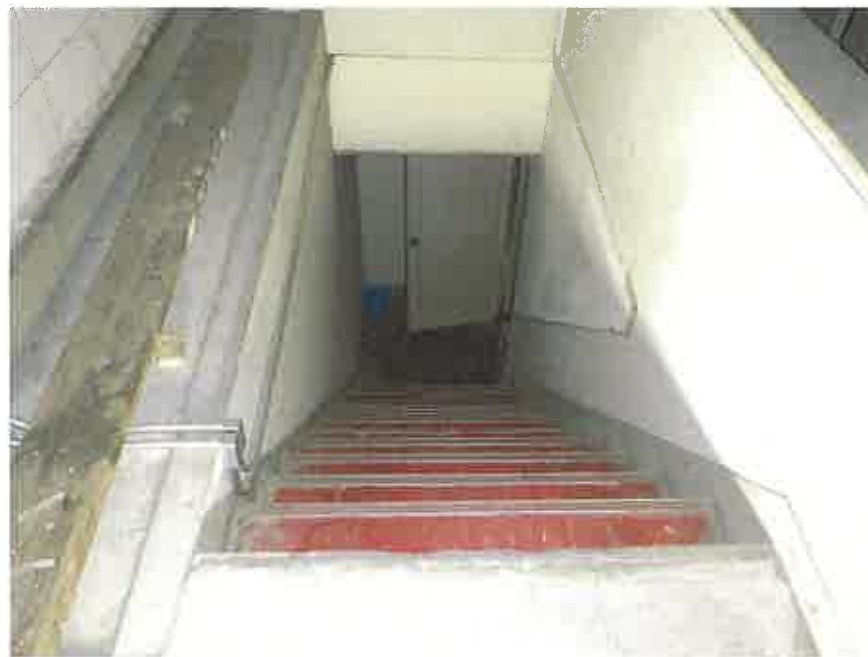
略北東側塔屋の階段部分
