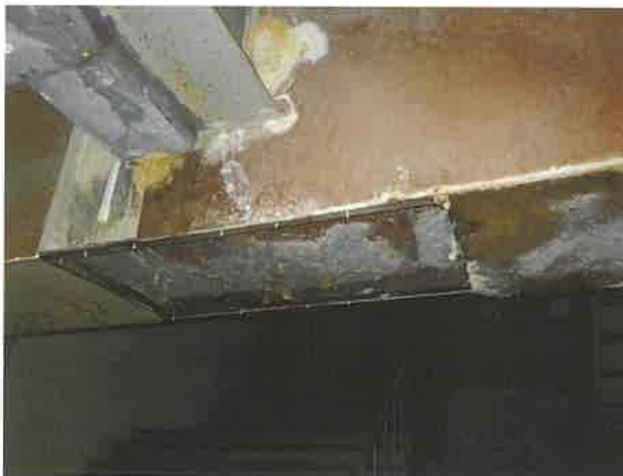
物件 5 の 5 階略北西側の天井部分
