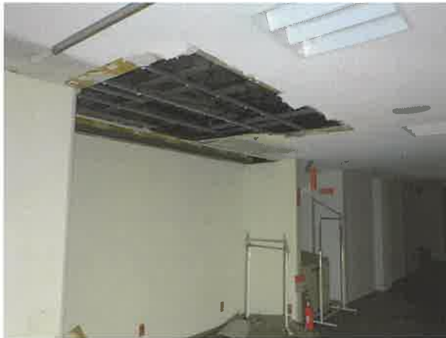
物件7の6階略東側の元店舗の天井部分
