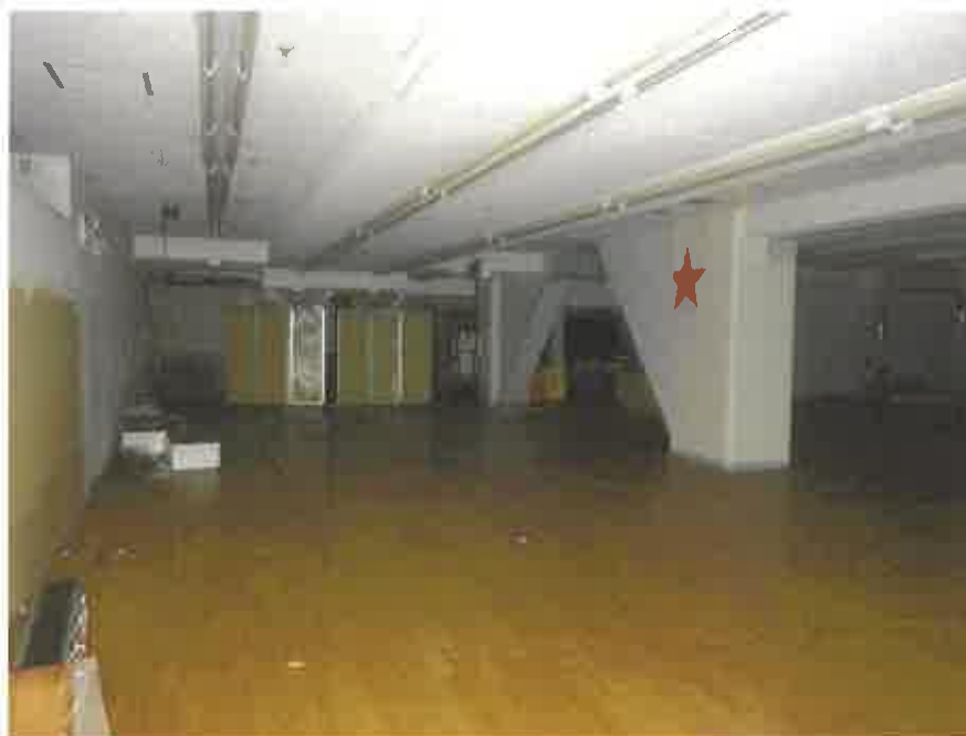
物件 5 の 5 階略北側の元店舗部分
