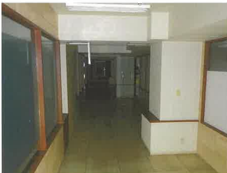
物件 7 の 8 階中央付近の廊下
