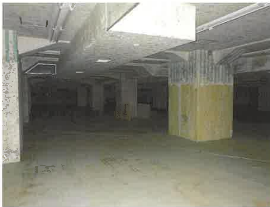
物件 3 の地下 1 階中央付近
