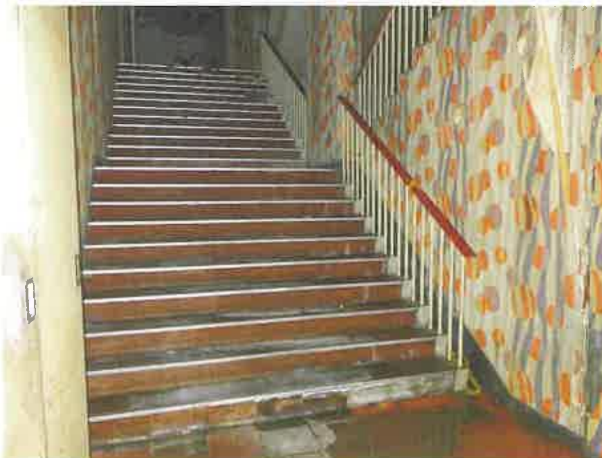
一棟の建物の地下1階略南側の階段部分
