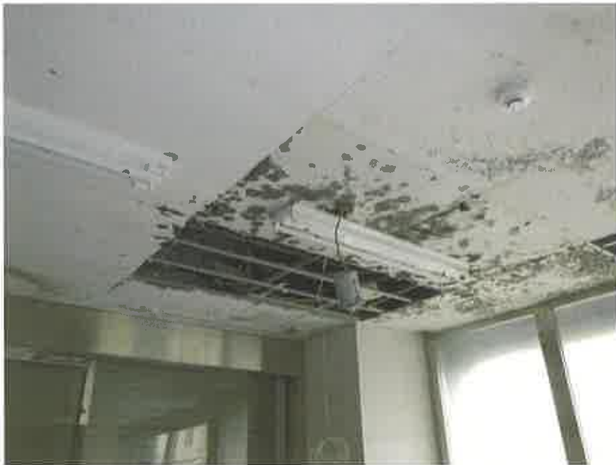
物件4の1階元店舗の天井部分
