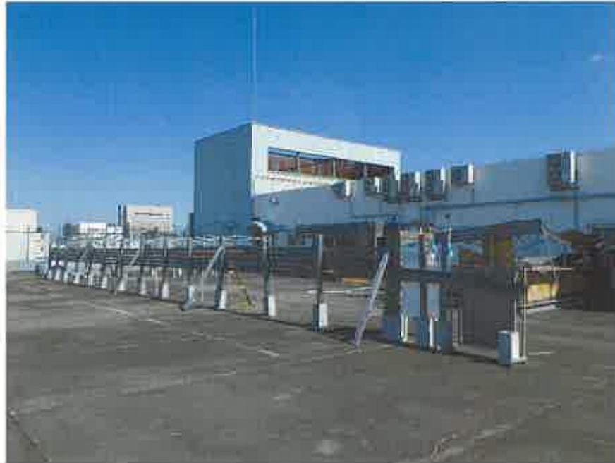
一棟の建物の屋上部分
