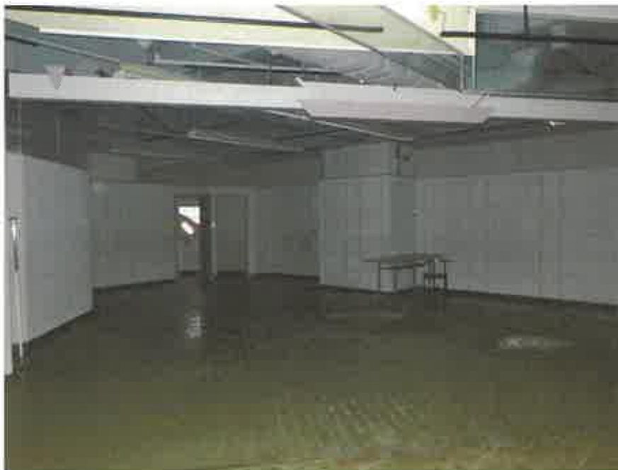
物件3の3階略北東側の元店舗部分
