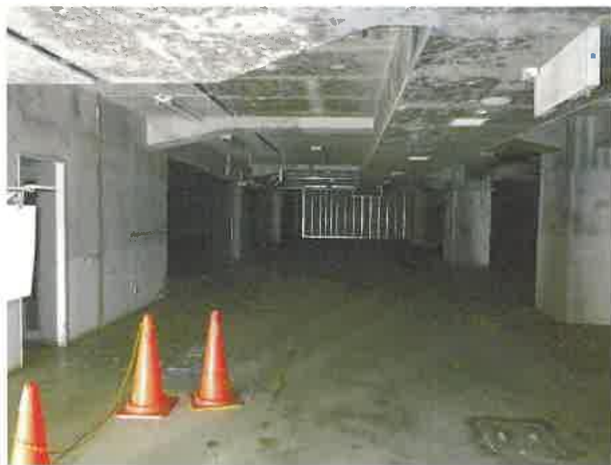
物件3の地下1階略北側部分
