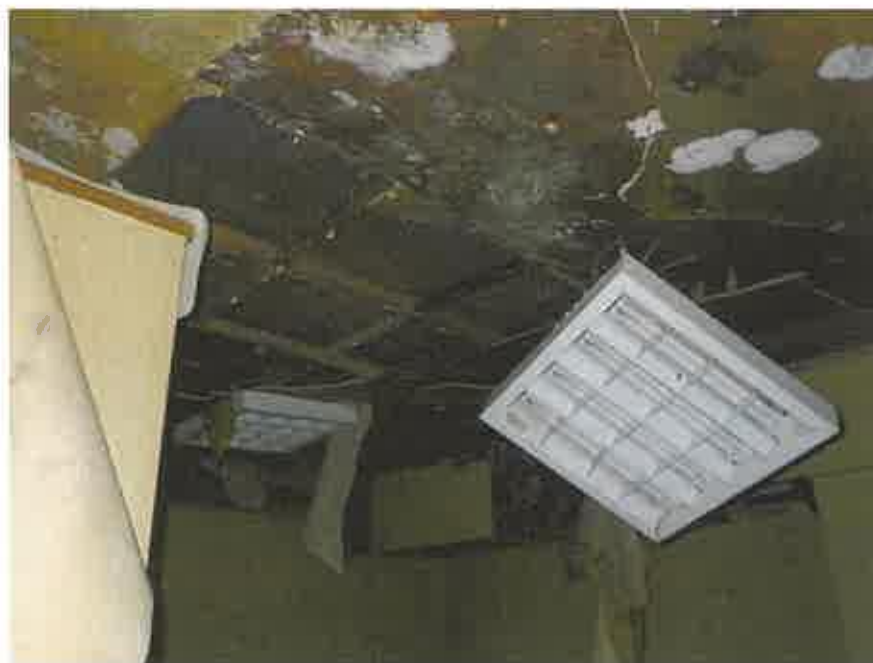
物件3の3階略西側のバックヤード天井部分
