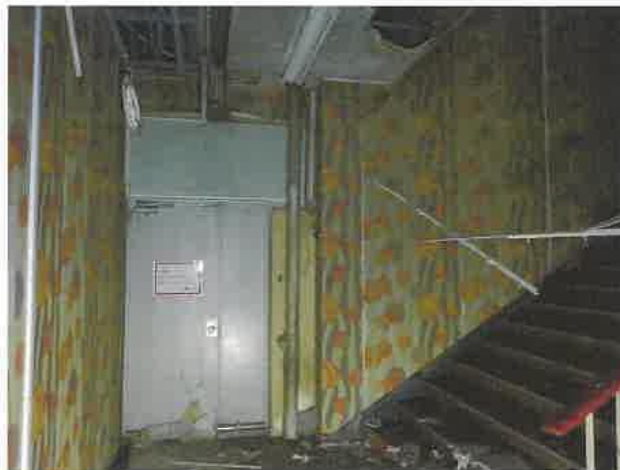
一棟の建物の1階略南側の階段部分
