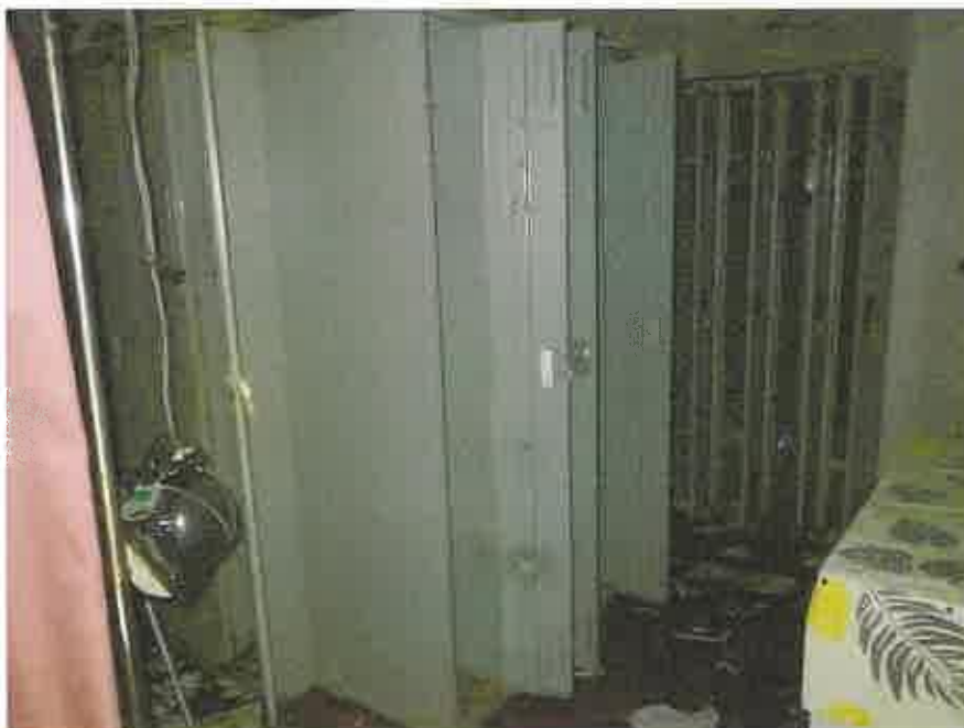
物件3の2階略西側のロッカー室
