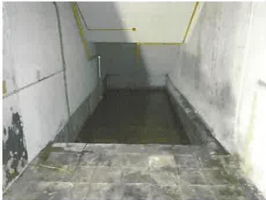
一棟の建物の地下1階略南側の階段下部分
