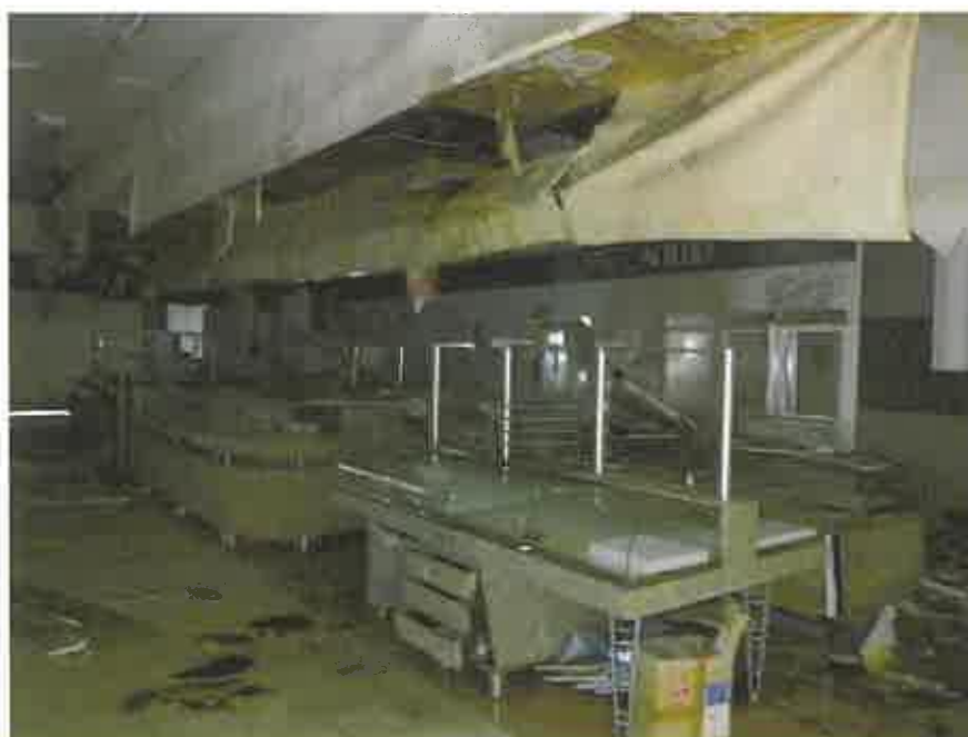
物件3の1階略南東側の元店舗部分
