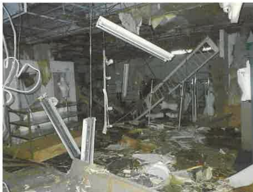
物件3の2階略南東側の元店舗部分
