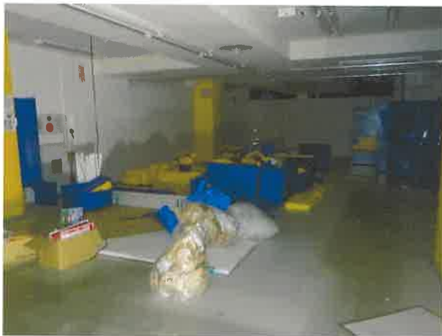
物件 5 の 4 階略南東側の元店舗部分
