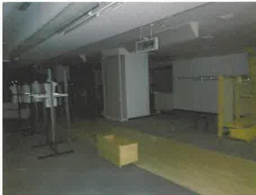
物件3の2階略北側の元店舗部分
