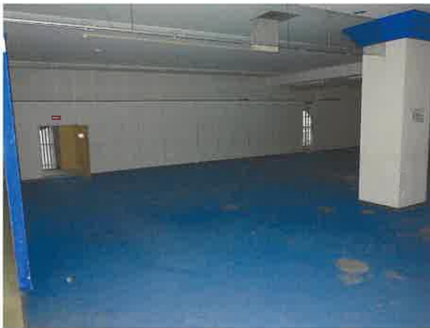
物件 5 の 4 階略北側の元店舗部分
