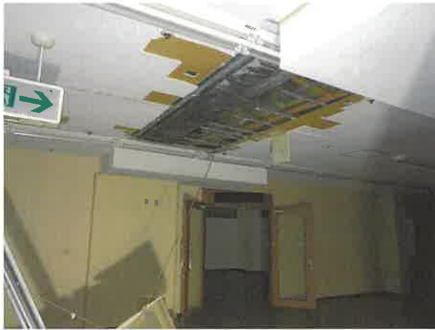
物件5の5階略南東側の元店舗の天井部分
