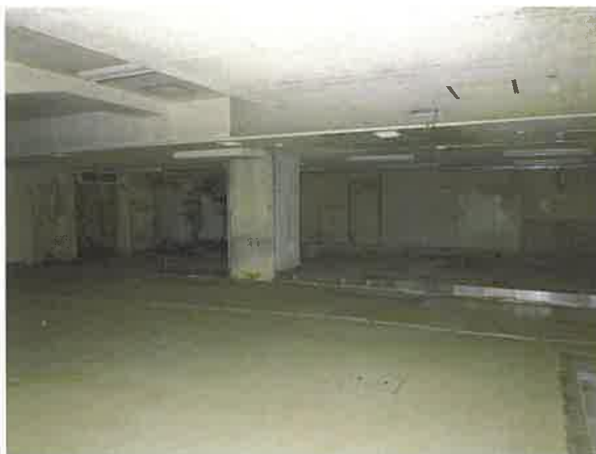
物件3の地下1階略南西側部分
