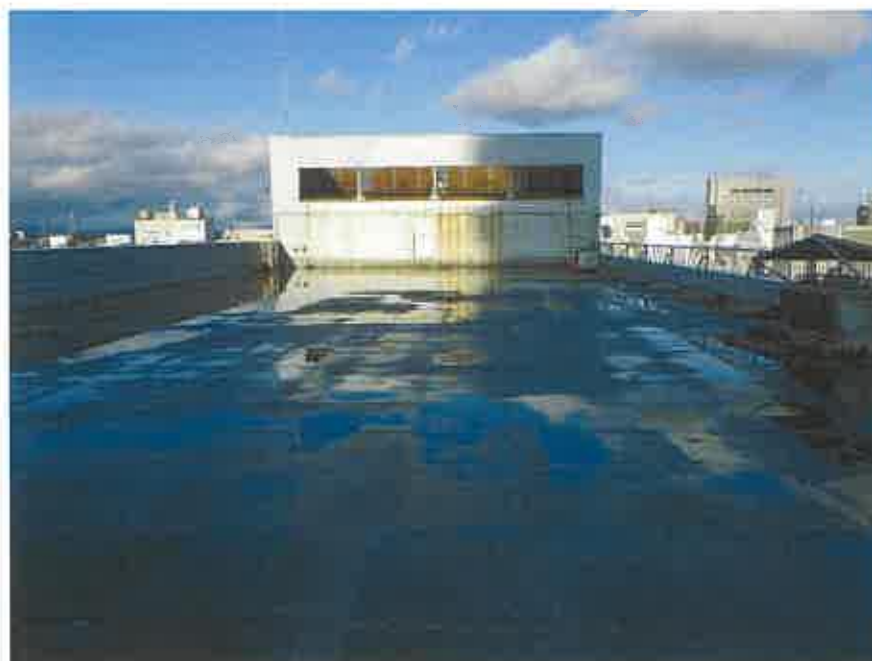
一棟の建物の屋上部分
