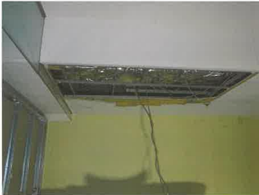
物件5の5階略西側のバックヤードの天井部分
