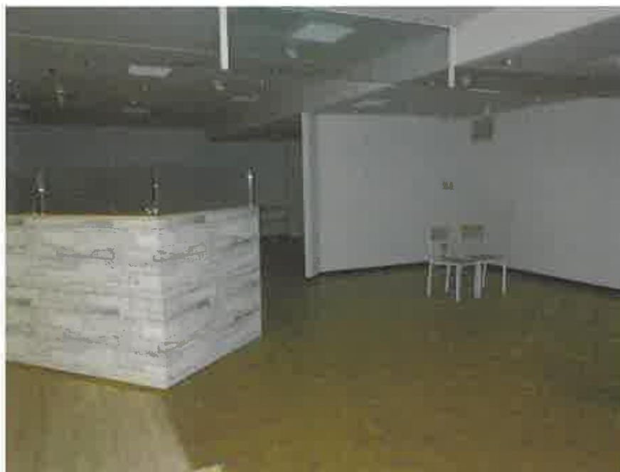
物件 3 の 2 階略北側の元店舗部分
