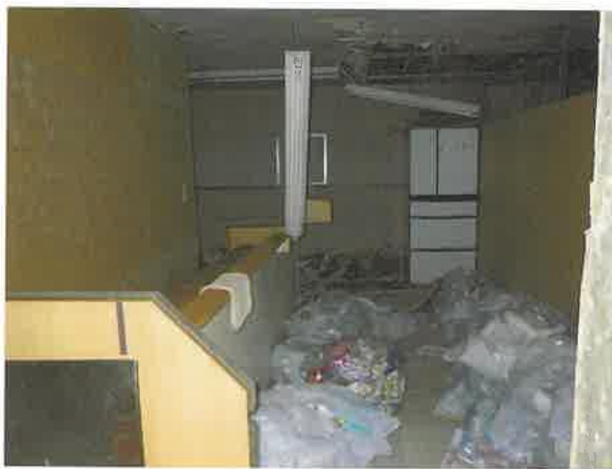
物件5の4階略南西側のバックヤード
