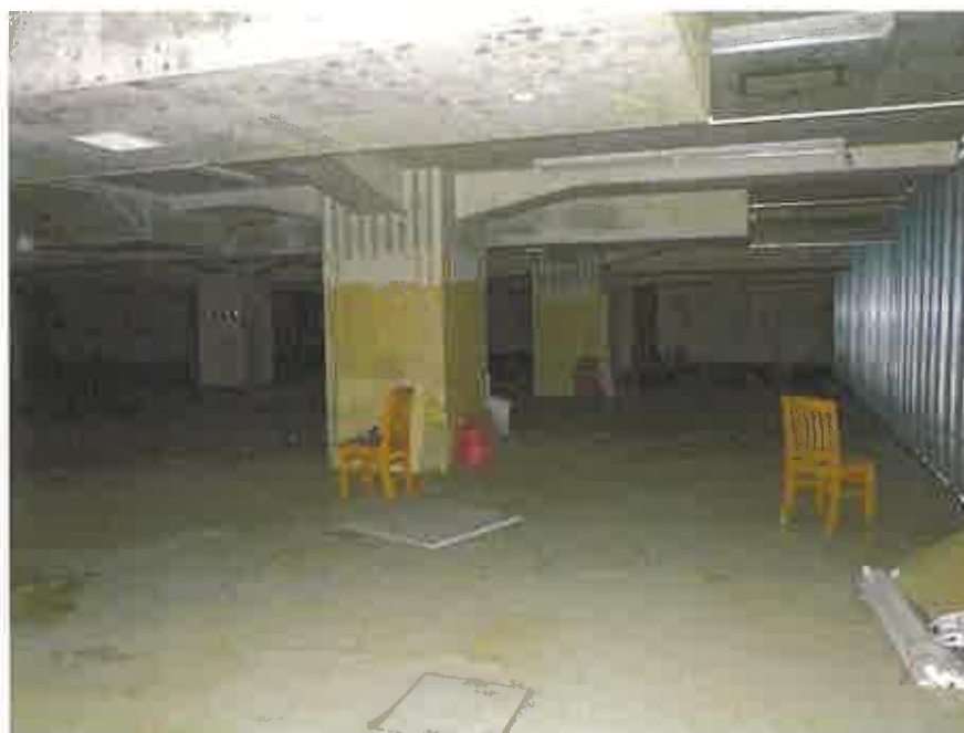
物件 3 の地下 1 階中央付近
