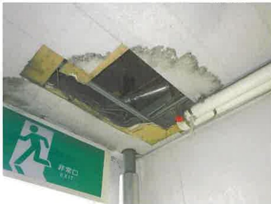
一棟の建物の1階略北側入口の天井部分
