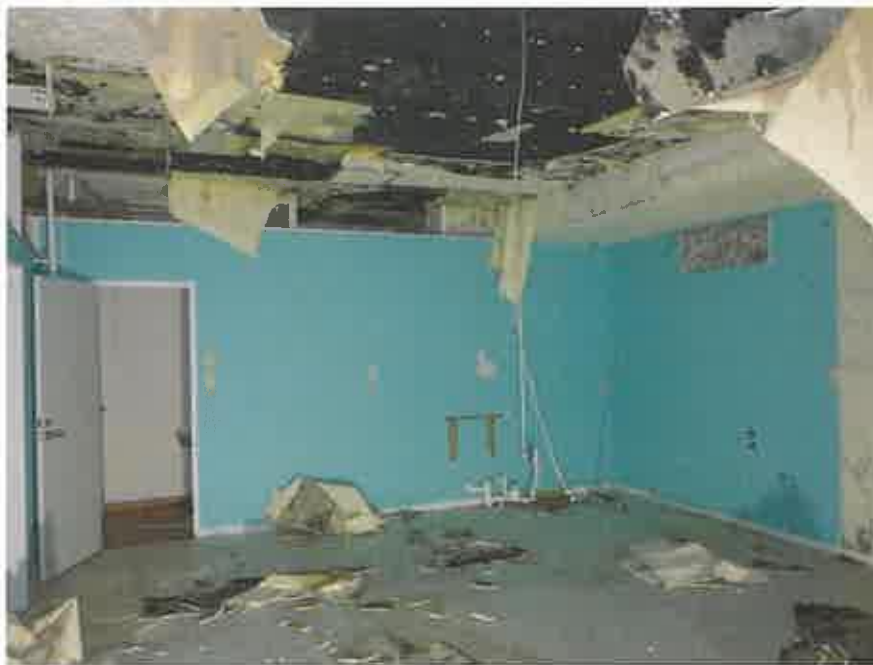
物件3の3階略南西側のバックヤード
