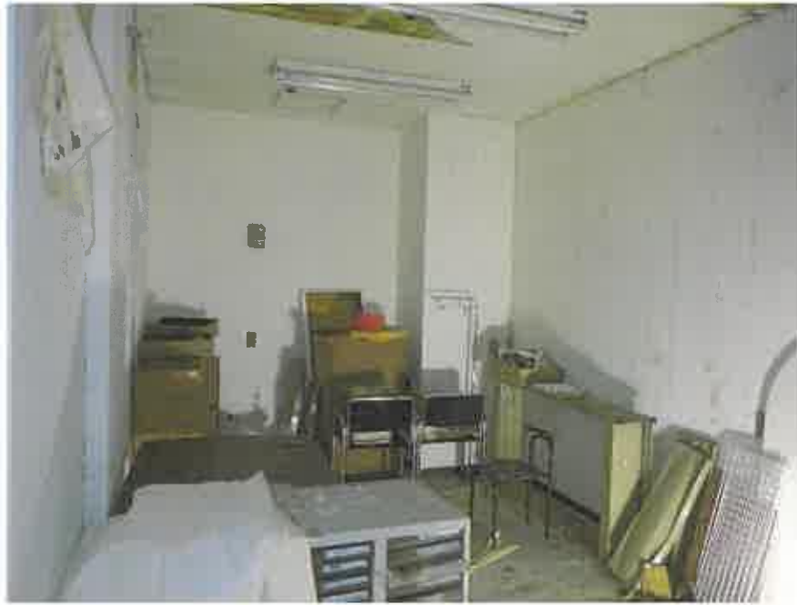
物件 3 の 1 階略南西側の元店舗部分
