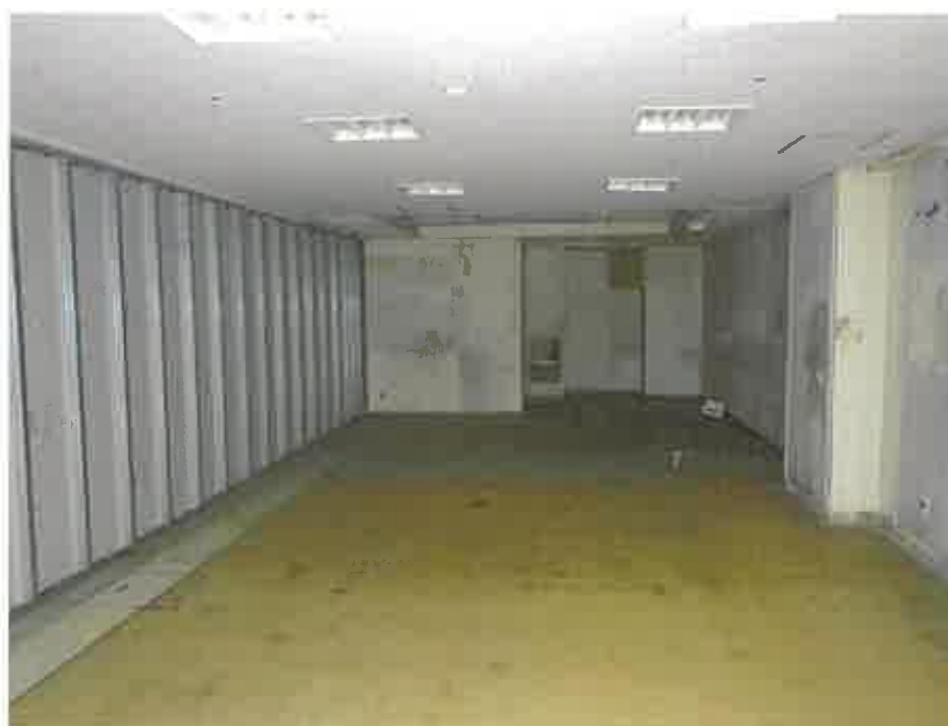
物件3の地下1階略北東側部分
