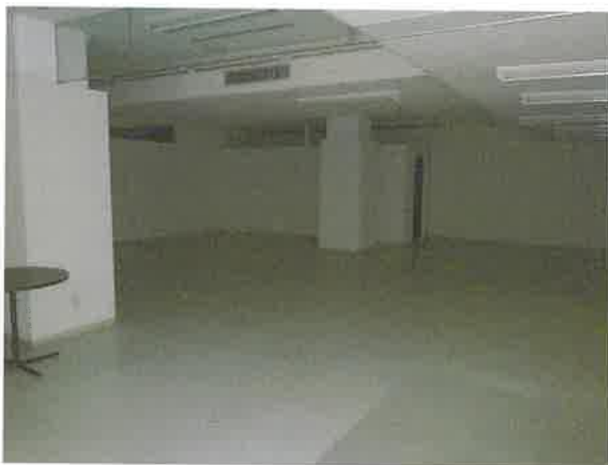
物件 5 の 4 階略南側の元店舗部分
