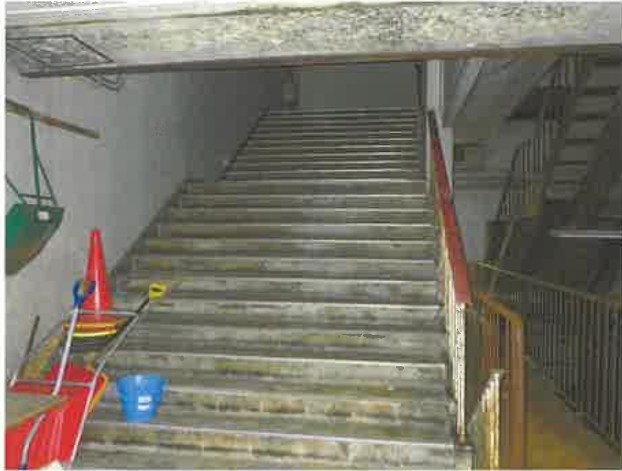
一棟の建物の1階略北西側の階段部分
