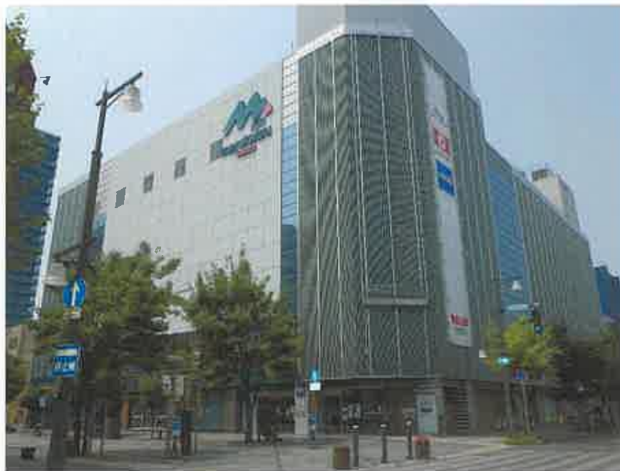
本件各土地の形状、本件一棟の建物の外観
