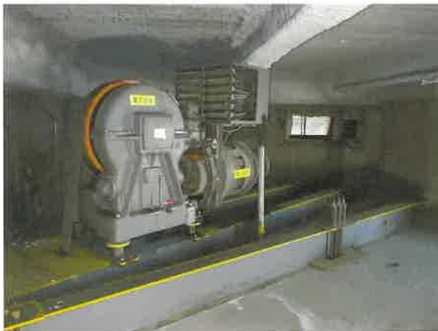
略北西側塔屋の内部
