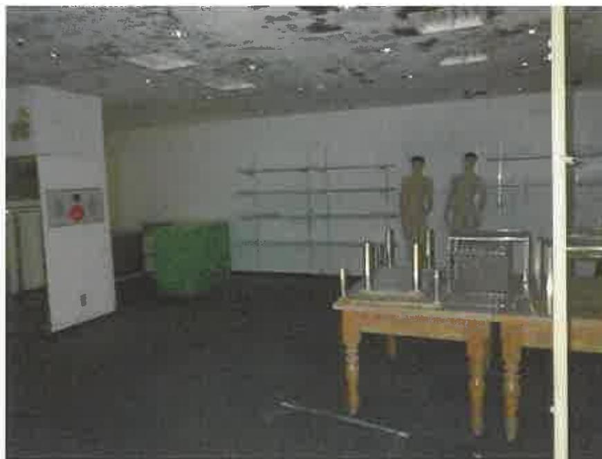
物件3の2階略南側の元店舗部分
