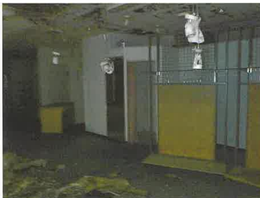
物件3の2階略南側の元店舗部分
