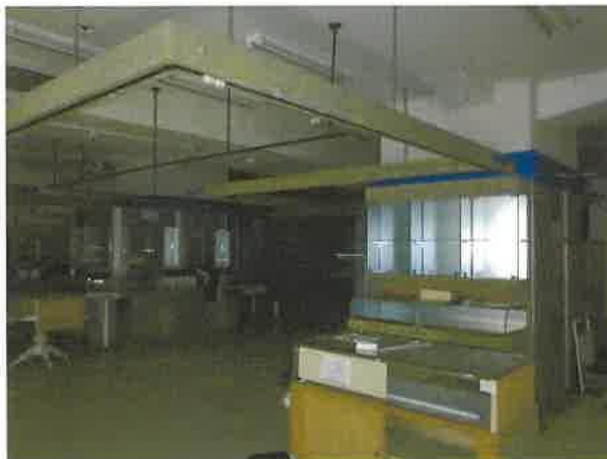
物件3の1階略東側の元店舗部分
