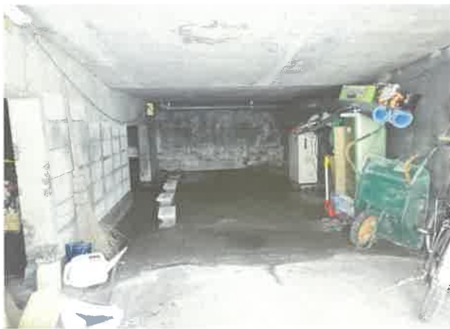
附属建物（車庫）内部の状況
