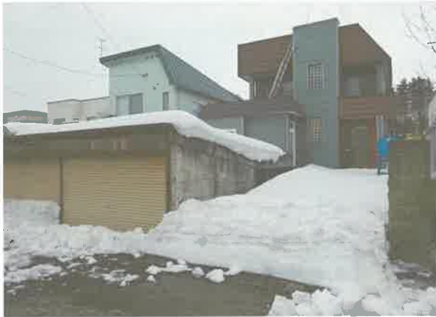
本件建物の外観、本件土地の形状、附属建物（車庫）
