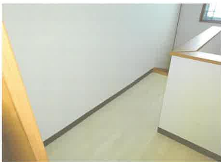
2 階増床部分のホールの状況
