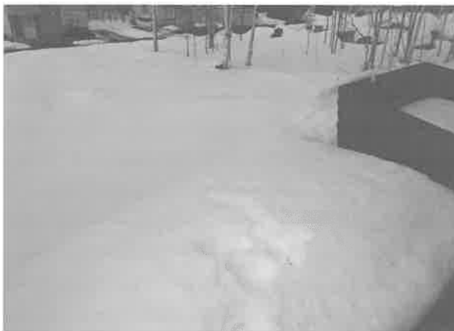
本件建物の裏側の法面の状況
