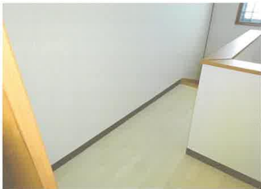
2階増床部分のホールの状況
