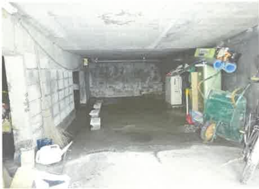
附属建物（車庫）内部の状況
