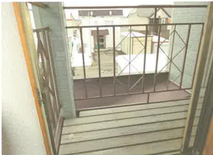
ベランダの状況（2階洋室4から出入り可）
