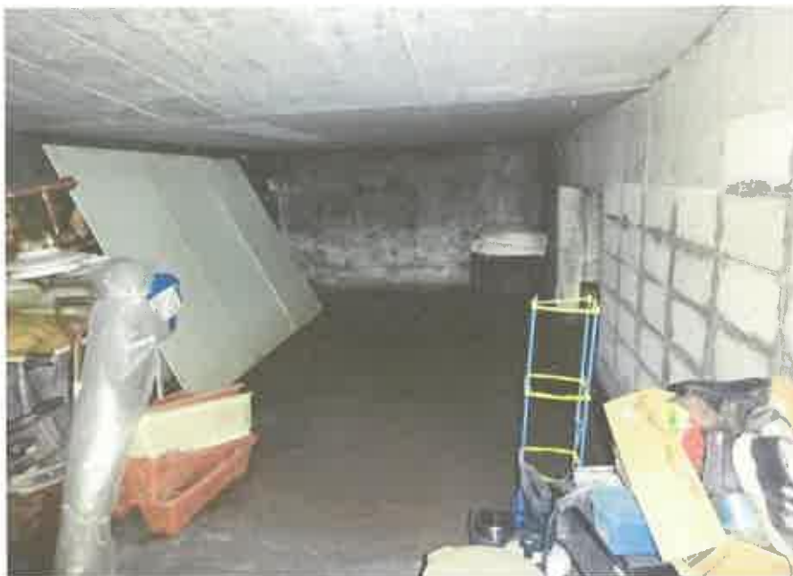
附属建物（車庫）内部の状況
