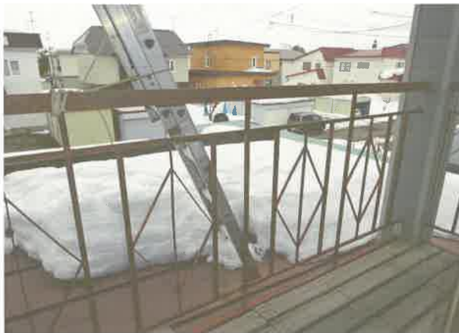
ベランダの状況（2階洋室5から出入り可）
