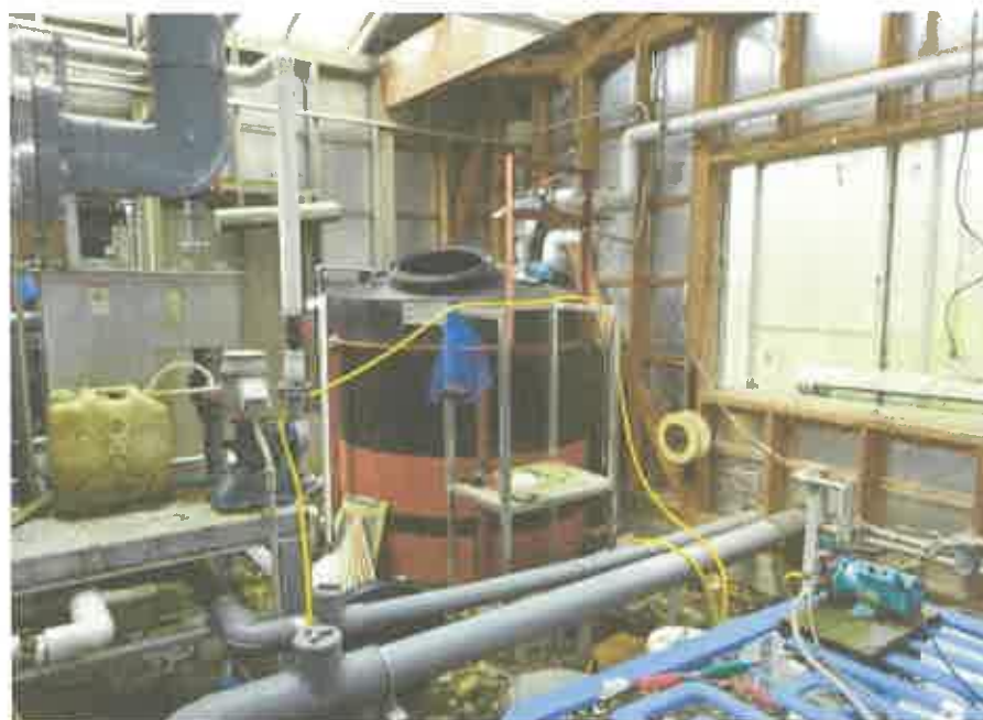
物件1 3建物（機械室）内部の状況
