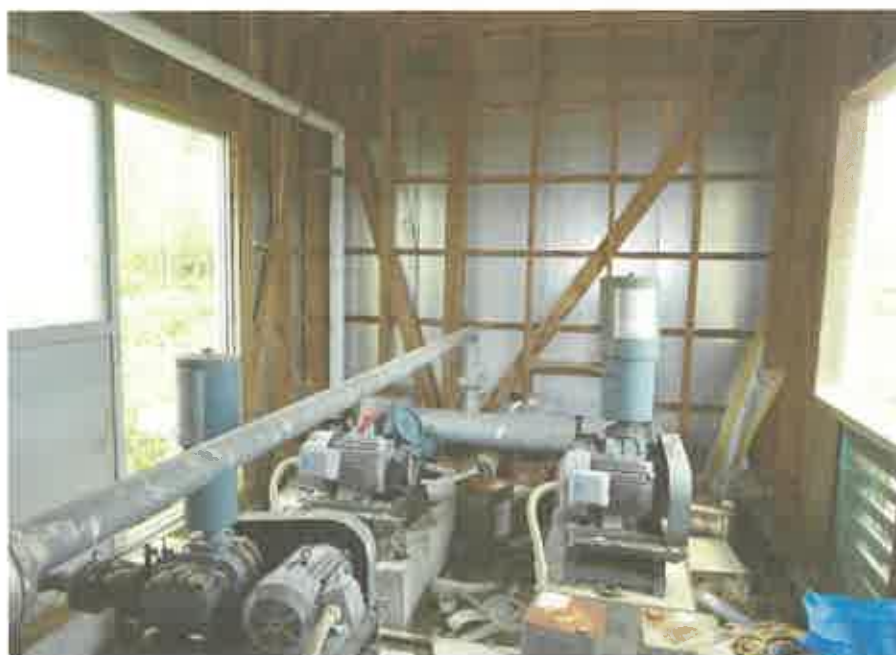
物件13建物（機械室）内部の状況
