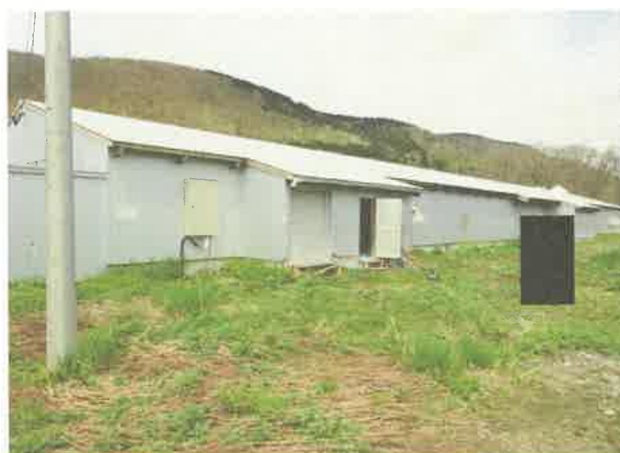
物件1 1建物（畜舎）
