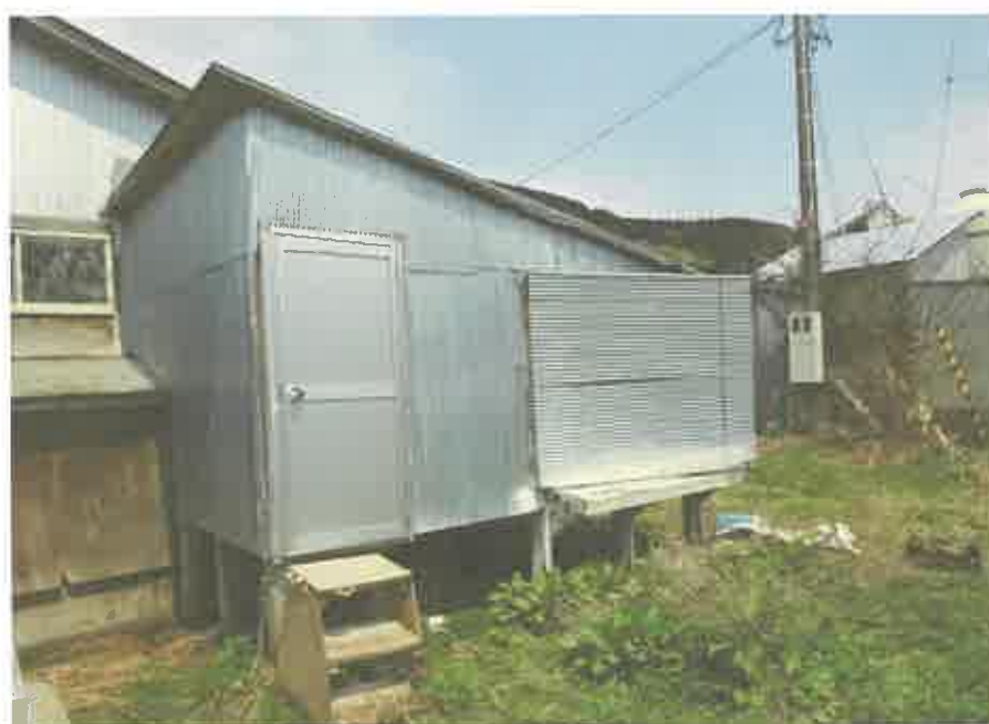
木製仮設物置
