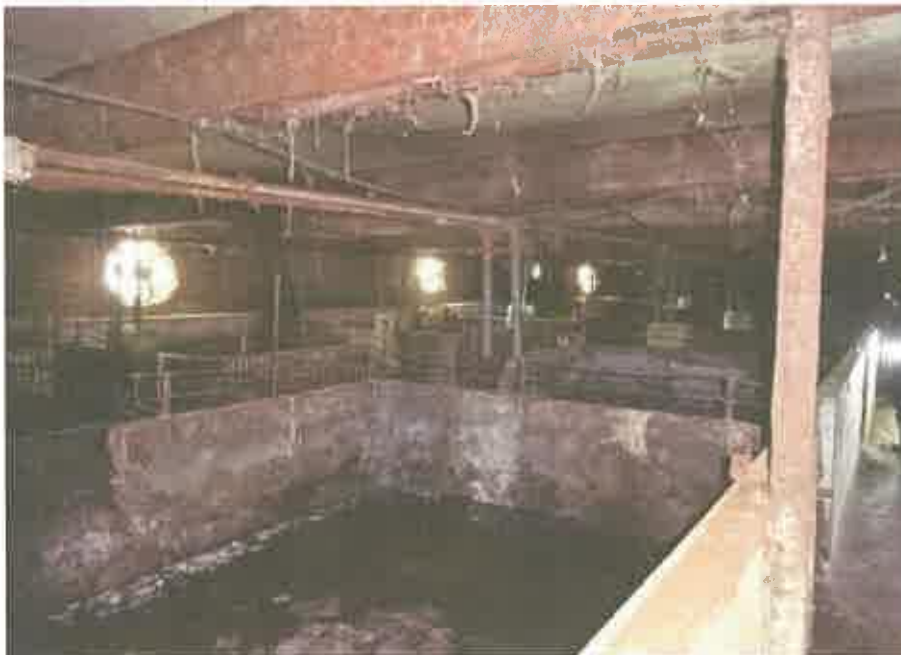
物件 1 2 建物の未登記附属建物①の内部の状況 (畜舎部分)
