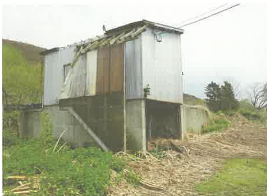
物件1 3建物（機械室）の外観
