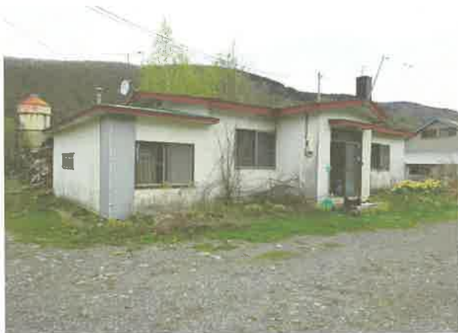
物件1 2建物の居宅部分の外観
