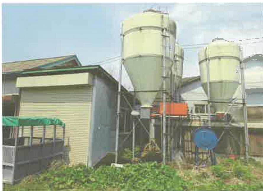
物件1 2 建物のうち、畜舎の残存部分
