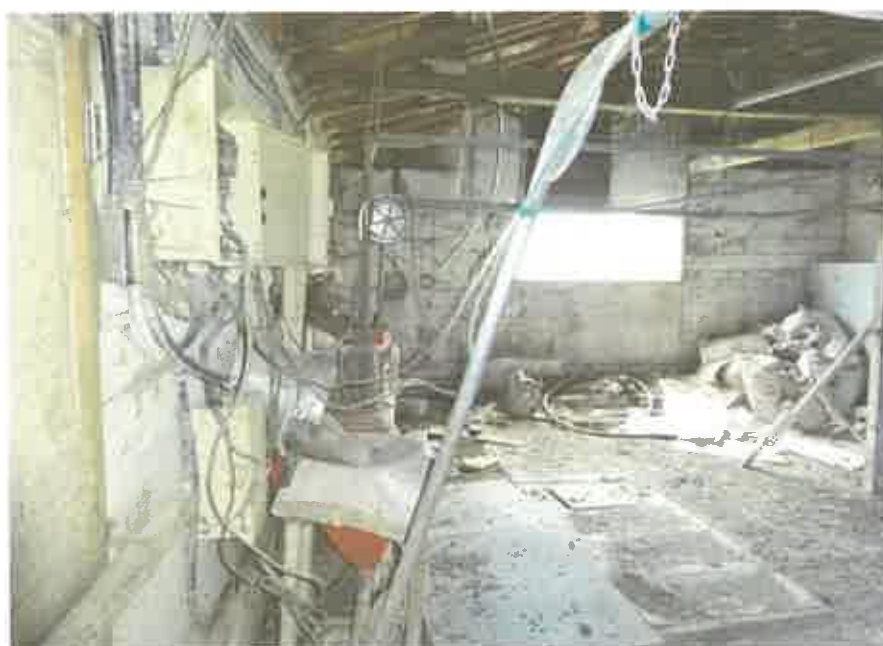
物件1 2 建物の未登記附属建物①の内部の状況 (略南東側の倉庫部分)
