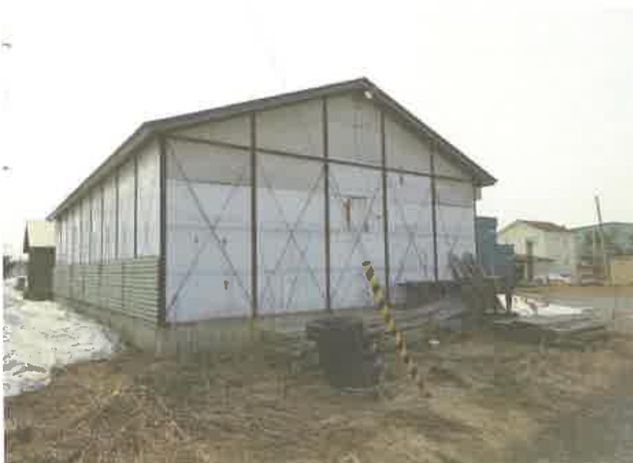
物件5土地及び物件6土地並びに同土地に跨って建てられている 未登記の目的外建物1（倉庫）
