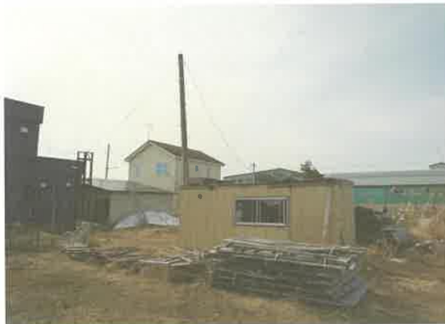
物件2土地及び物件3土地上に跨って存在するプレハブ仮設物置 及び私営柱
