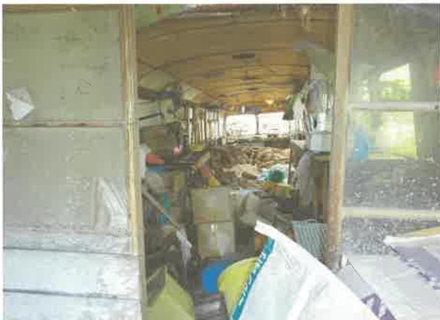
物件1 2建物のうち、居宅部分の前室に接続する廃バス内部の状況
