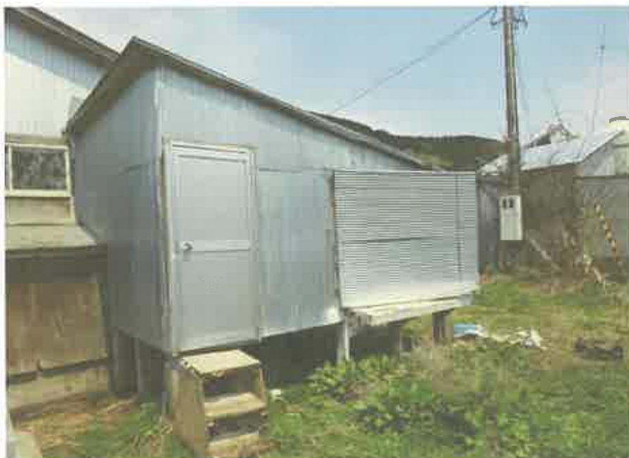
木製仮設物置
