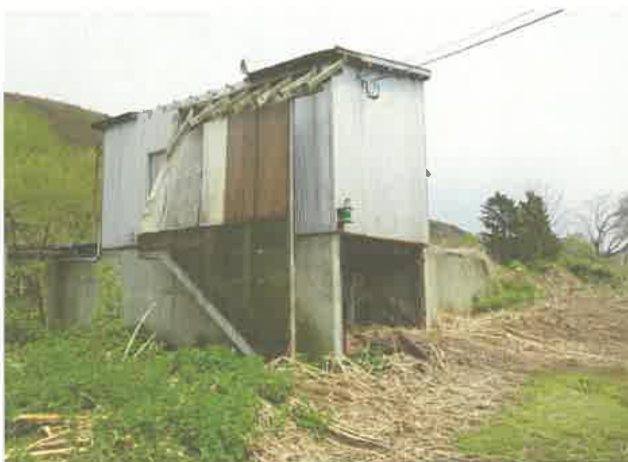
物件13建物（機械室）の外観
