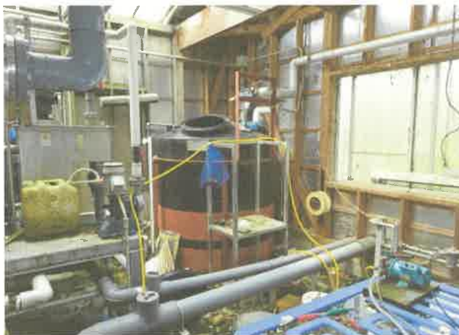
物件13建物（機械室）内部の状況
