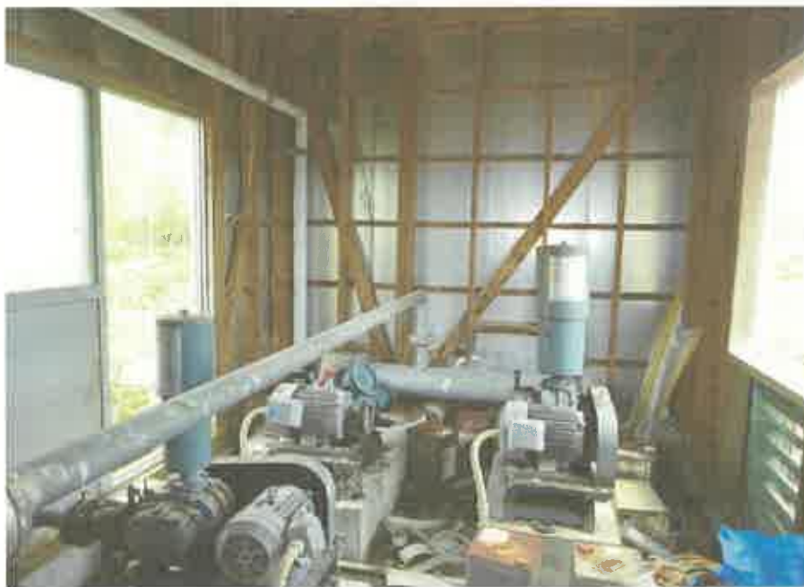
物件13建物（機械室）内部の状況
