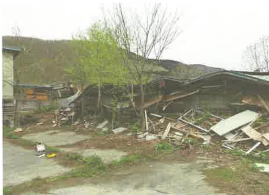
物件1 2 建物の倒壊状況
