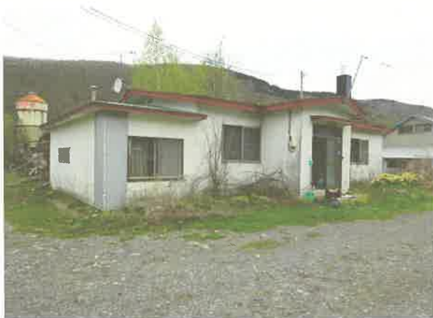
物件 1 2 建物の居宅部分の外観
