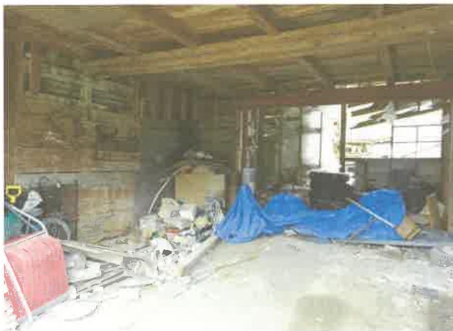
物件1 2 建物の未登記附属建物②の内部の状況 (倉庫)
