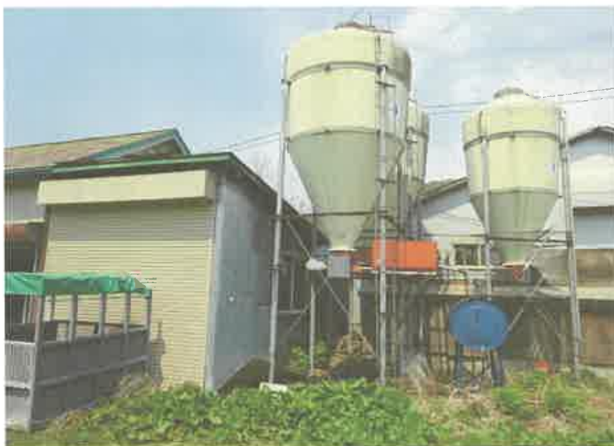
物件1 2建物のうち、畜舎の残存部分
