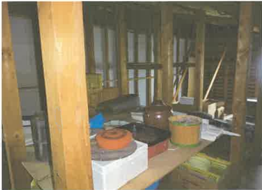
2階小屋裏の状況
