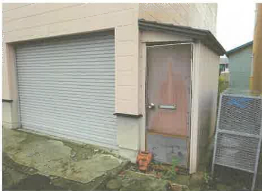
1 階増床部分（物置）
