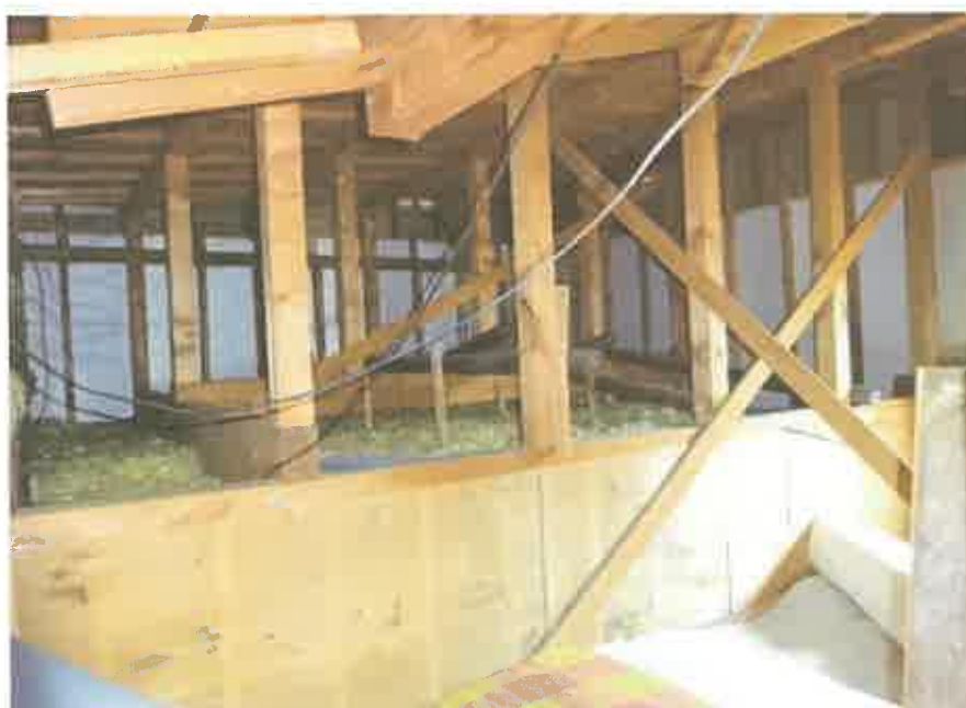
2 階小屋裏の状況
