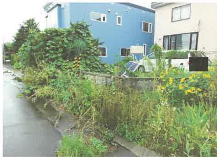
コンクリートブロック塀の状況
