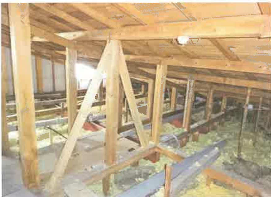
2階小屋裏の状況（鉄骨梁により補強）
