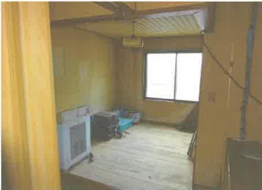
1 階共同住宅部分の 10 号室の居間
