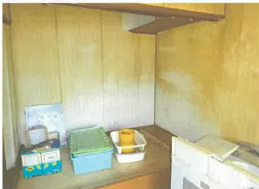
1 階共同住宅部分の 1 0 号室の居間
