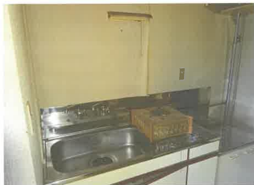
2階共同住宅部分の205号室の台所
