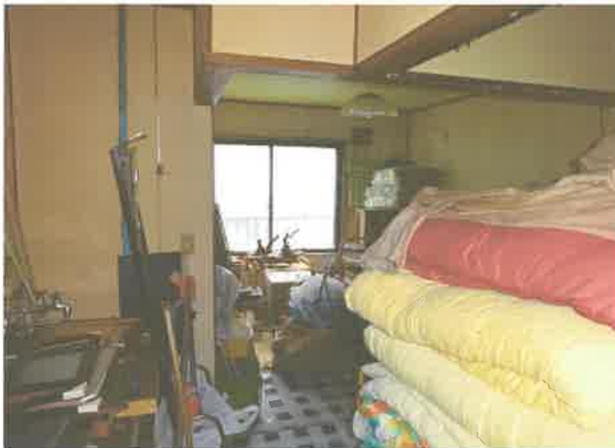
1階共同住宅部分の16号室の居間
