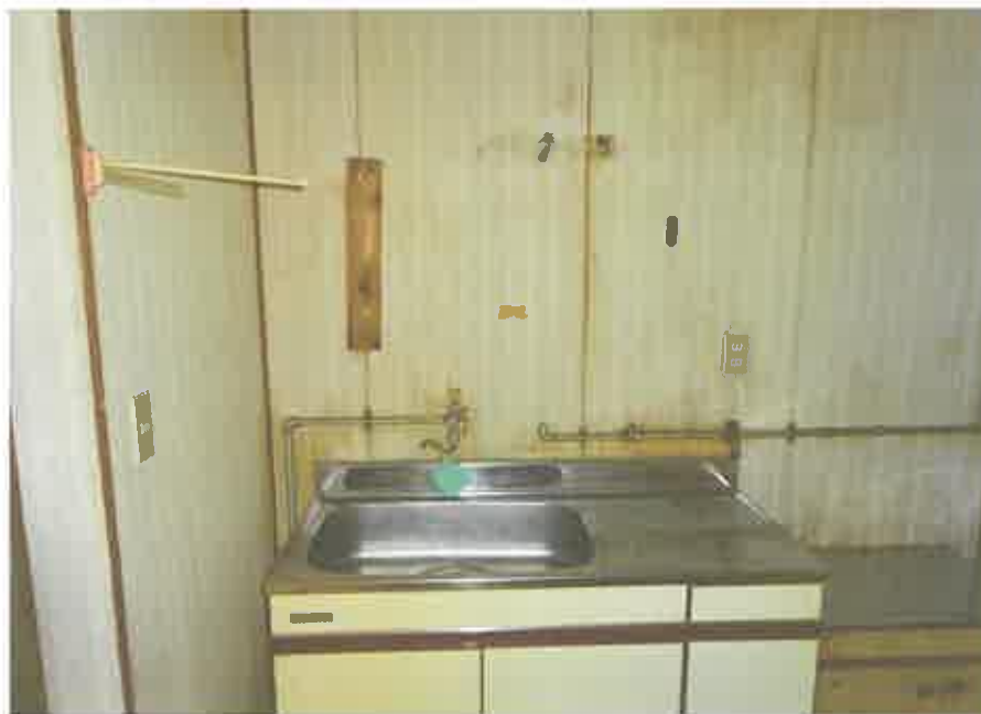
1 階共同住宅部分の 1 1 号室の台所
