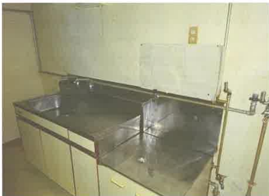
2階共同住宅部分の210号室の台所
