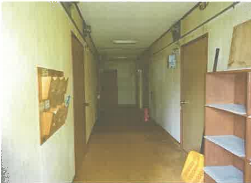
1 階共同住宅部分の廊下の状況
