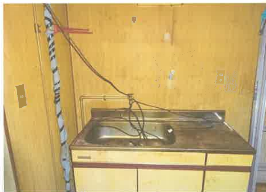
1 階共同住宅部分の 1 0 号室の台所
