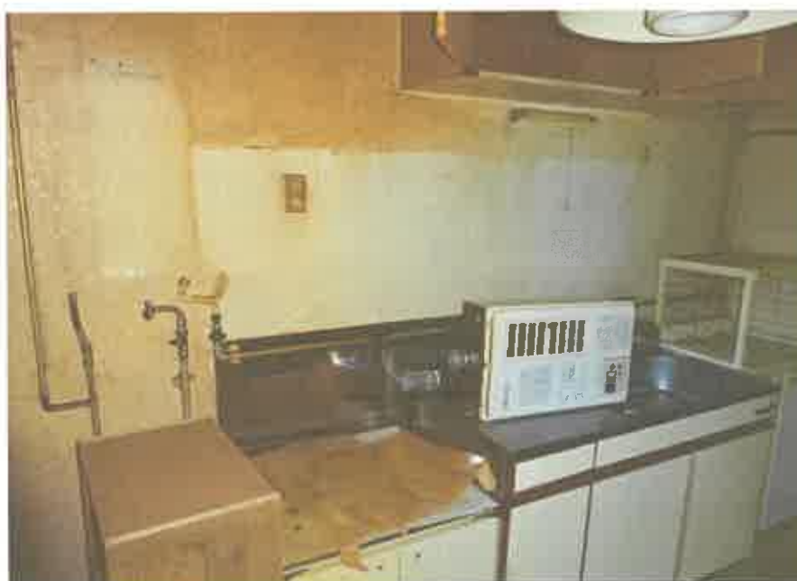
2階共同住宅部分の208号室の台所
