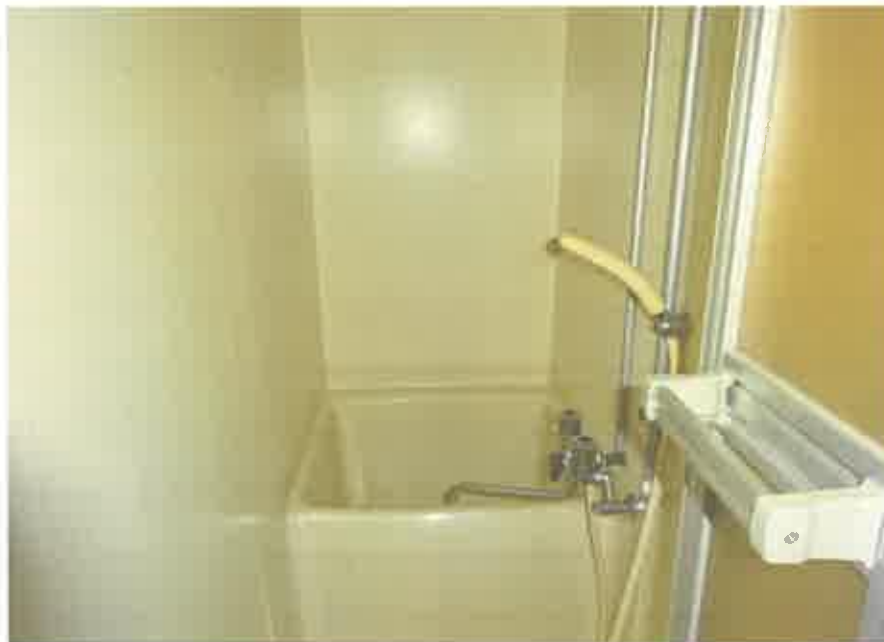
2階共同住宅部分の203号室の浴室
