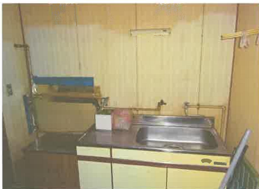
1 階共同住宅部分の 1 5 号室の台所
