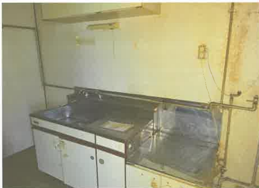
2階共同住宅部分の202号室の台所
