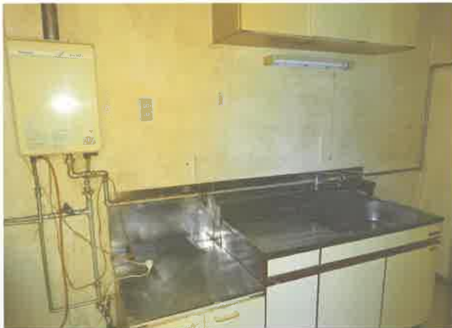
2階共同住宅部分の201号室の台所
