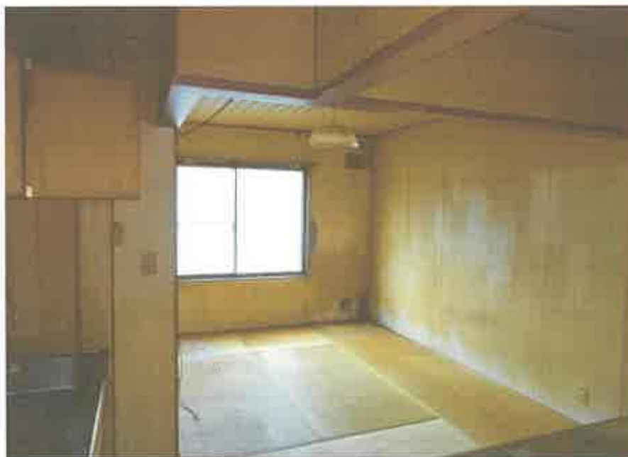
1 階共同住宅部分の 1 2 号室の居間
