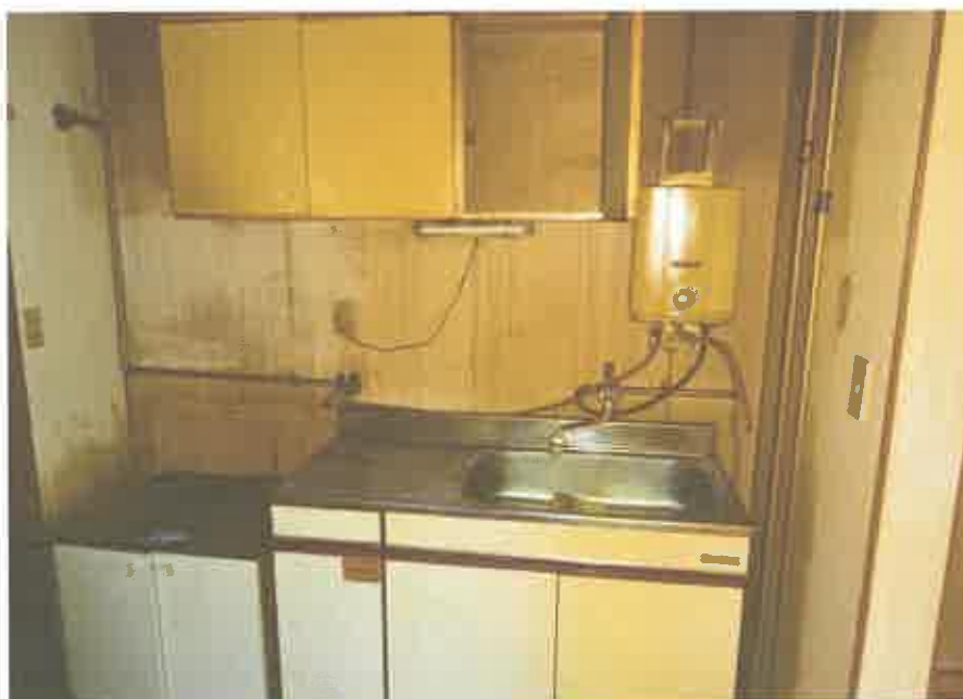
1 階共同住宅部分の 1 2 号室の台所
