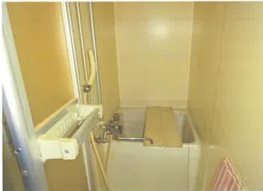
2階共同住宅部分の207号室の浴室
