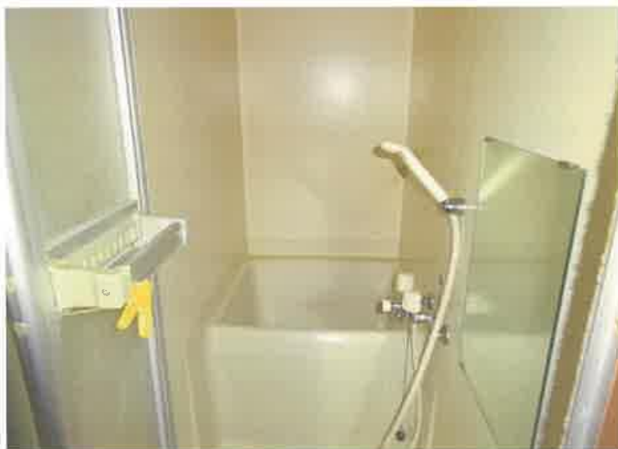
2階共同住宅部分の210号室の浴室
