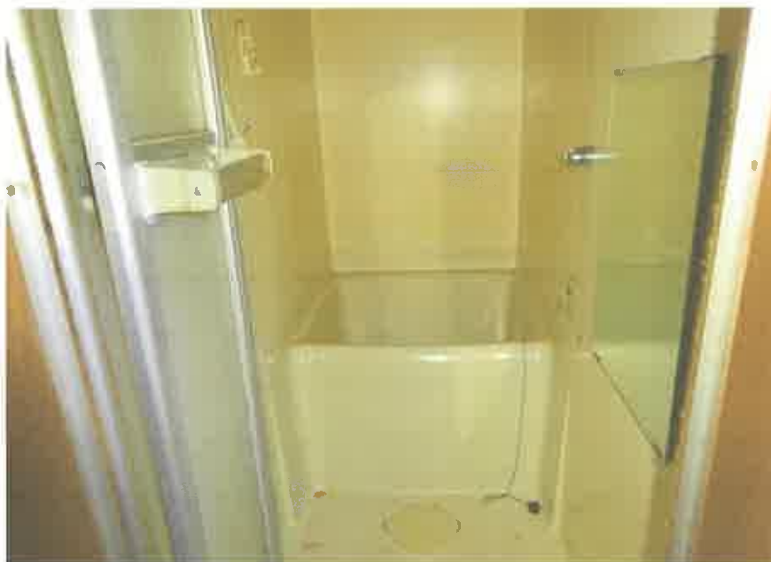
2階共同住宅部分の202号室の浴室
