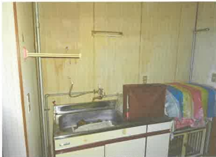
1 階共同住宅部分の 1 3 号室の台所
