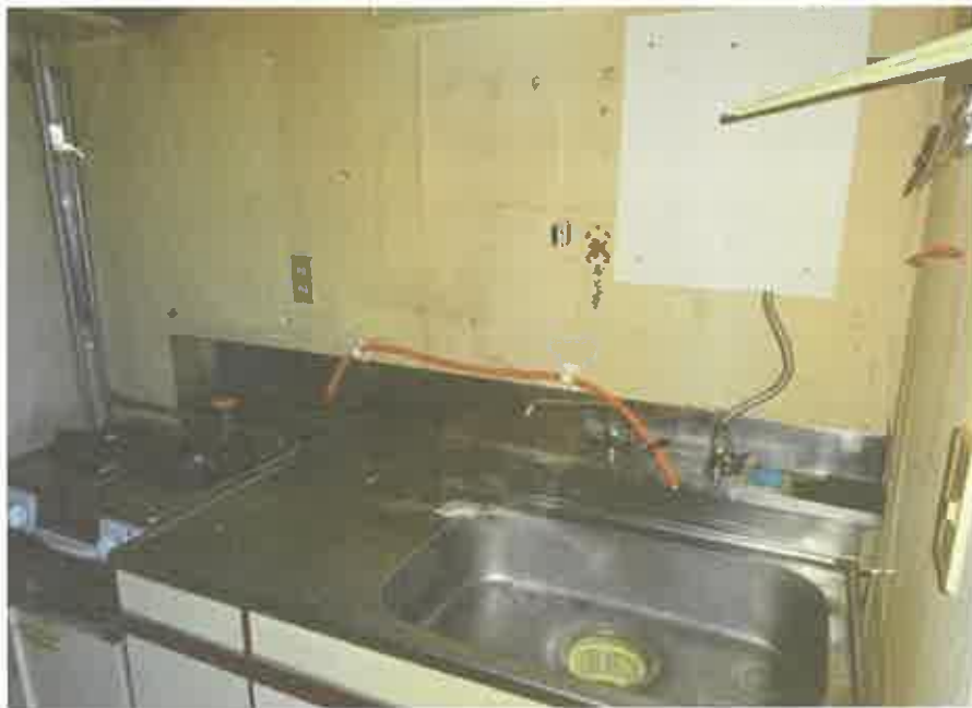
2階共同住宅部分の206号室の台所
