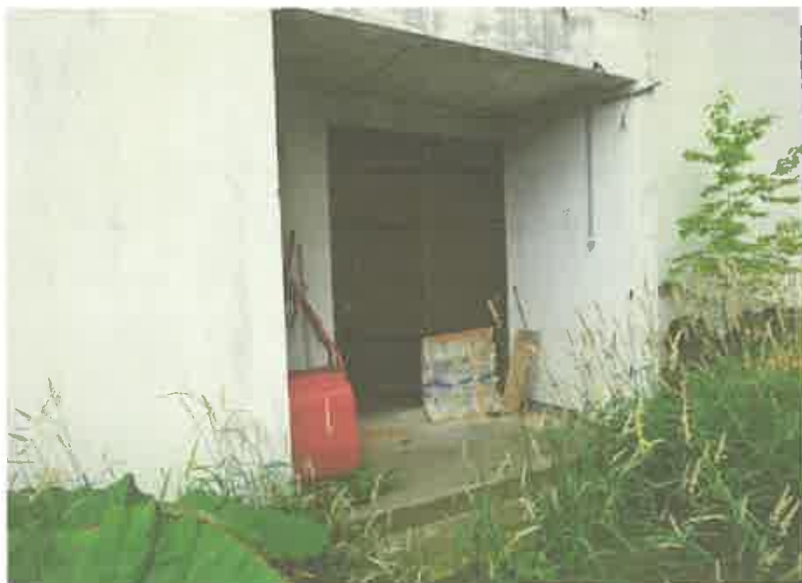
1 階共同住宅部分の入口玄関の状況
