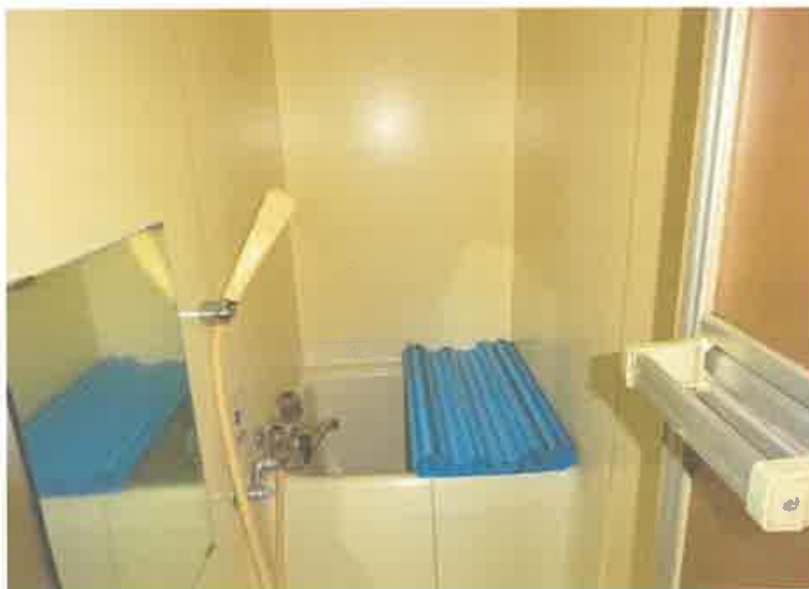
2階共同住宅部分の201号室の浴室
