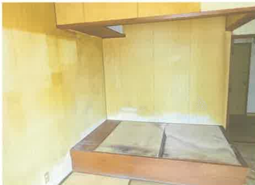
1 階共同住宅部分の 1 2 号室の居間
