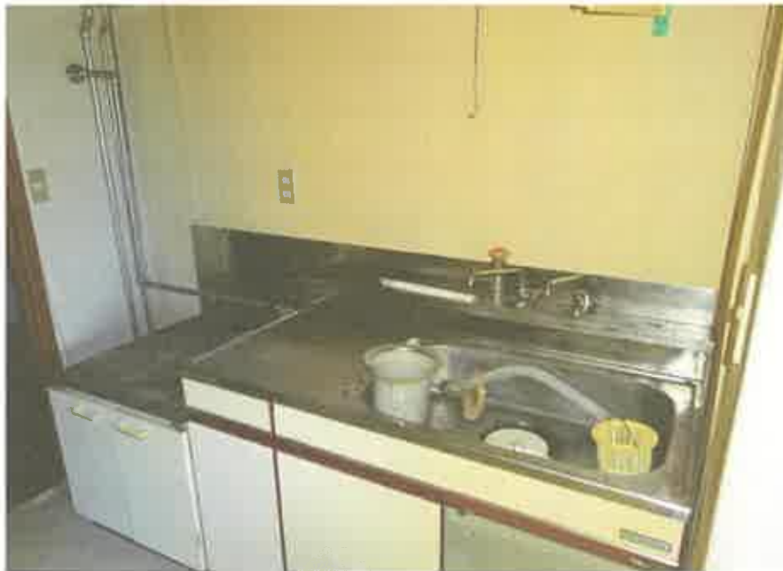
2階共同住宅部分の203号室の台所
