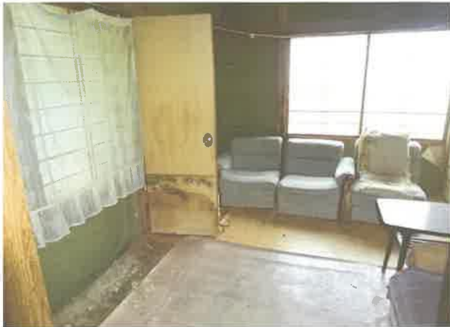
1 階居宅部分の和室 3
