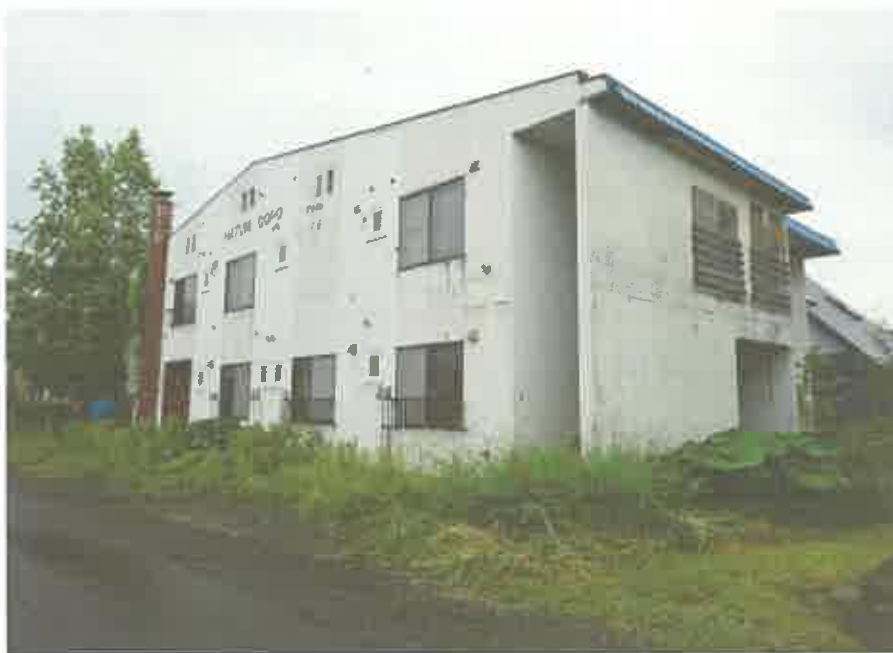
本件建物の外観、本件土地の状況
