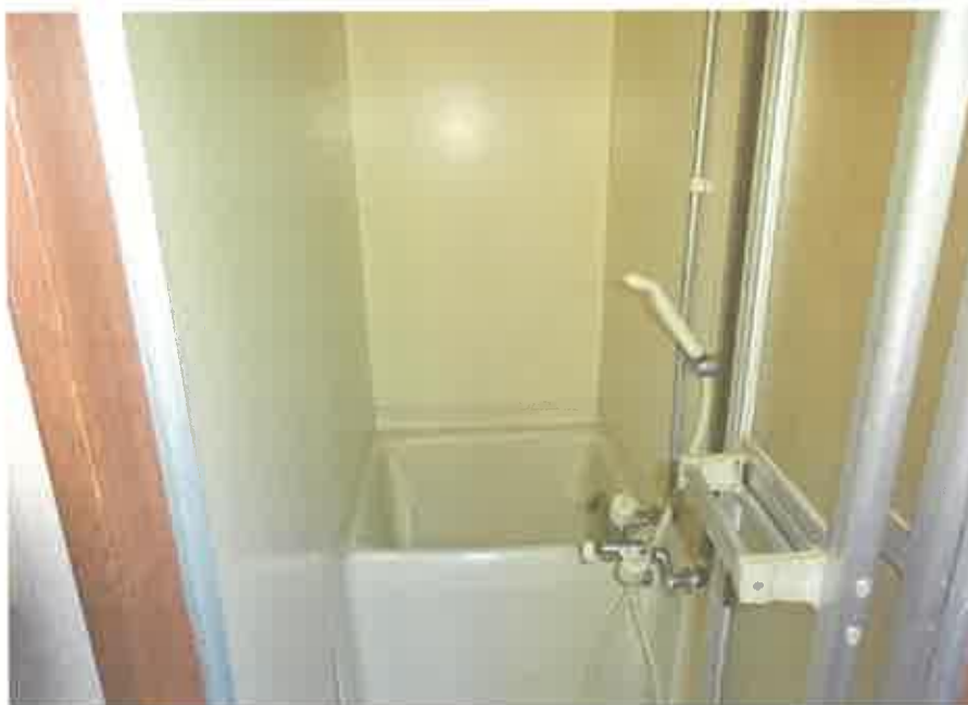
2階共同住宅部分の206号室の浴室
