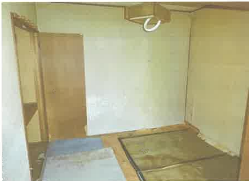
2階共同住宅部分の208号室の和室
