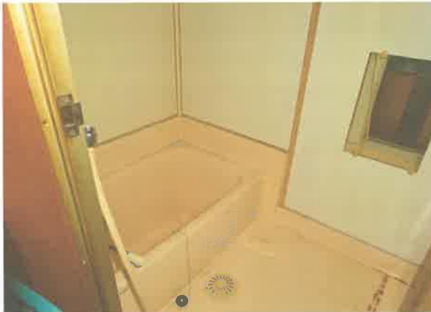
1階居宅部分の浴室
