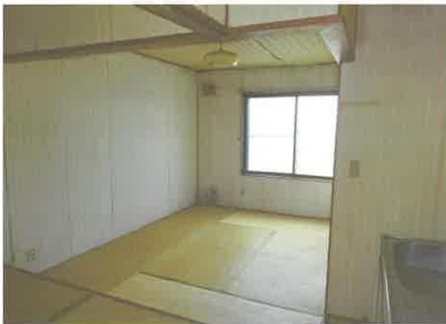
1階共同住宅部分の11号室の居間
