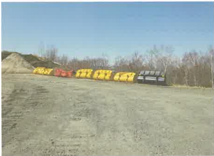
土地上の機材の状況
