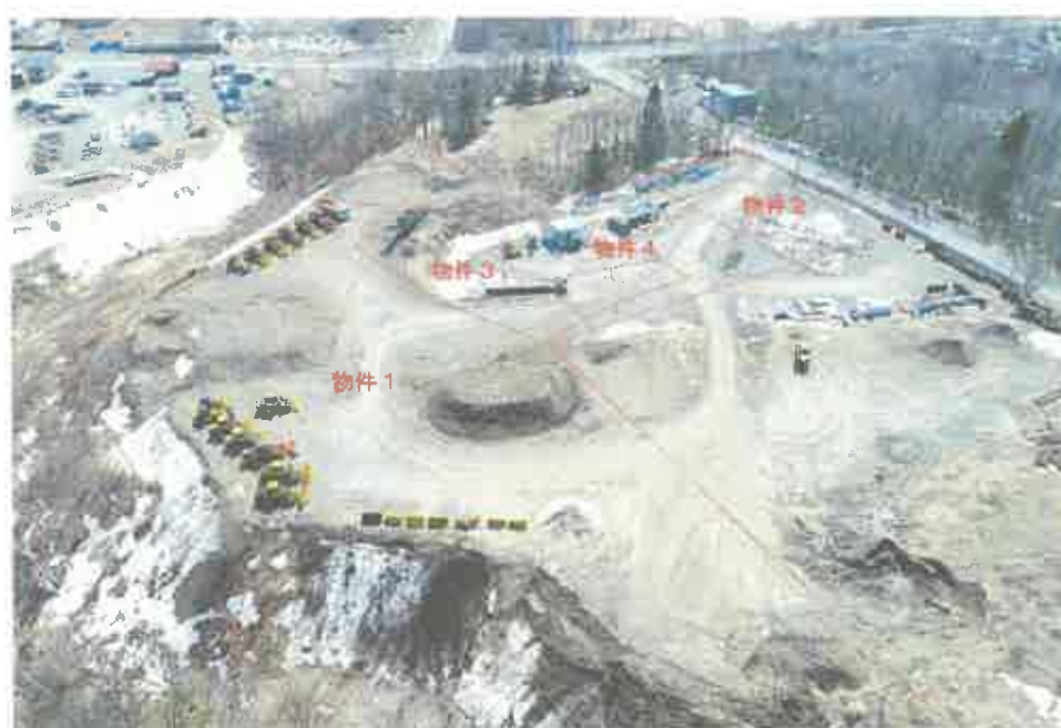
本件各土地の状況（ドローンにより撮影） （土地の番号の表示付き）
