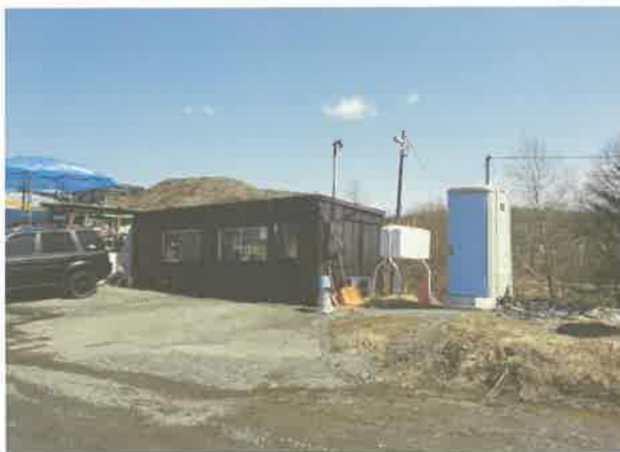
軽量鉄骨造仮設事務所、ポリエチレン製仮設トイレ
