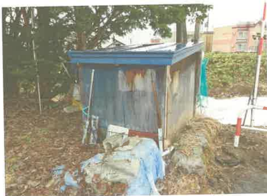
木製仮設物置
