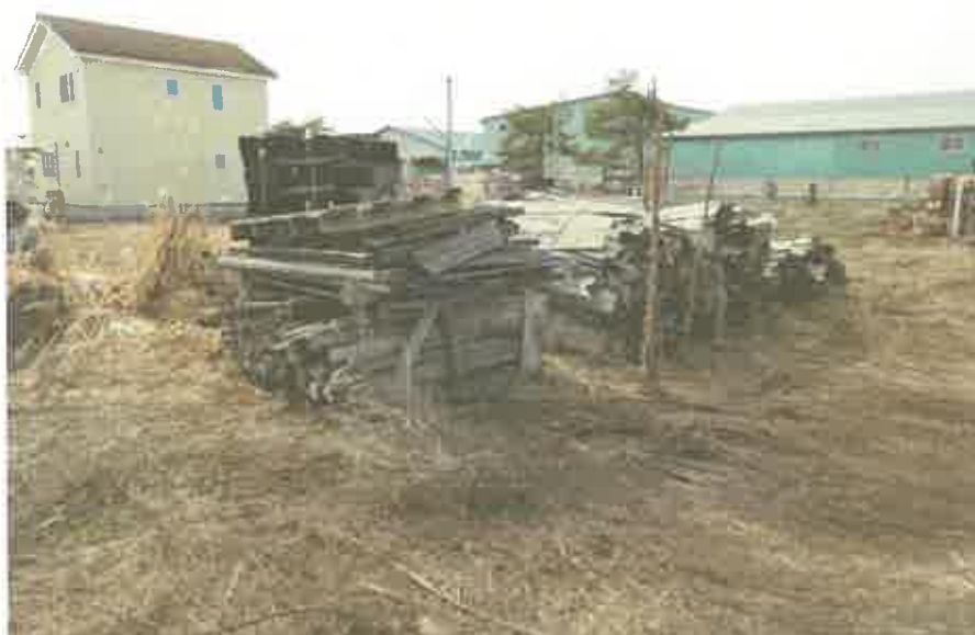
物件 1 土地及び物件 2 土地上に残置された廃材の状況
