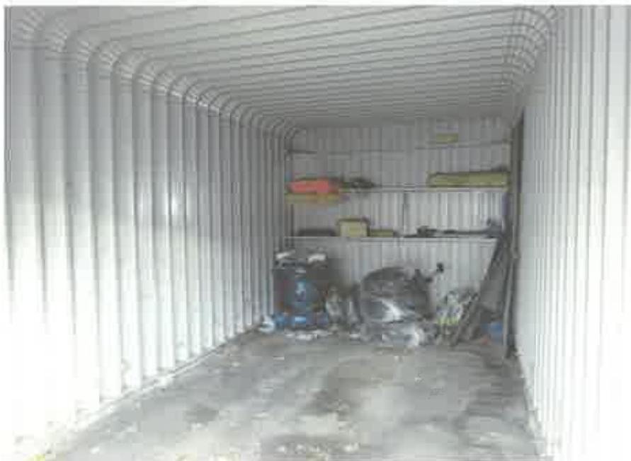
未登記附属建物（軽量鉄骨製平家建車庫）の内部
