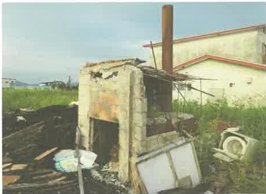
コンクリートブロック造焼却炉
