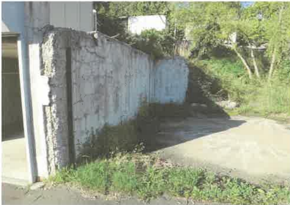
物件1と略北西側隣接地との境界沿い及びその近くのコンクリート壁
