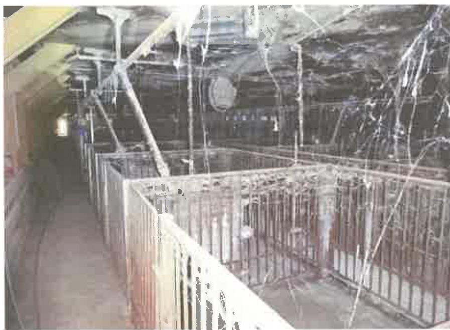
物件11建物（畜舎）内部の状況
