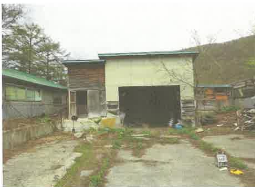
物件1 2 建物の未登記附属建物①の外観
