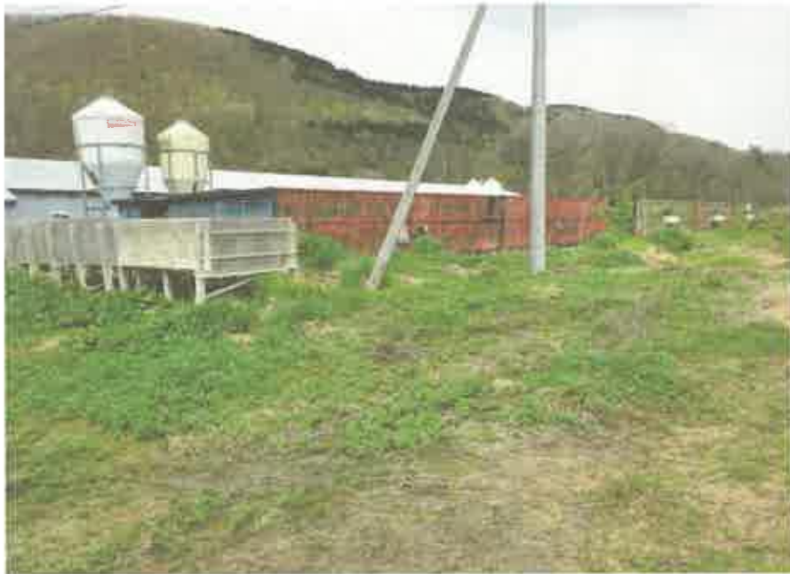
木・鉄骨製仮設畜舎 (コンテナが連結されて、畜舎として利用されている)
