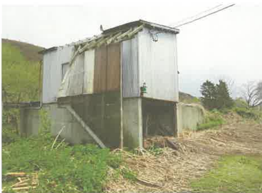
物件13建物（機械室）の外観
