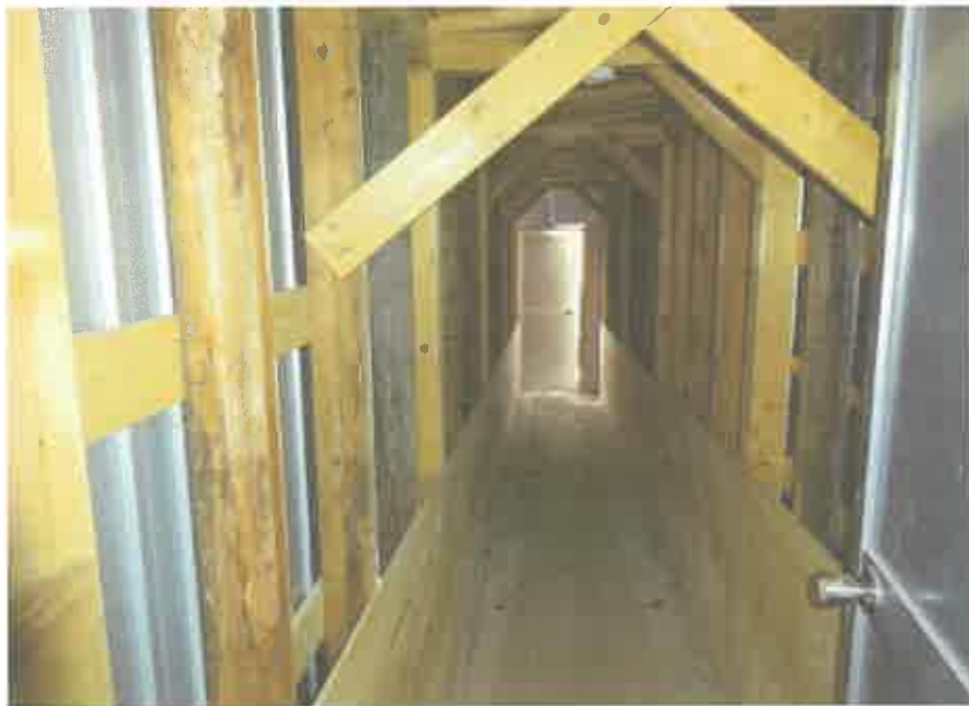
前記の写真6の通路（物件11建物の増築部分）の内部の状況
