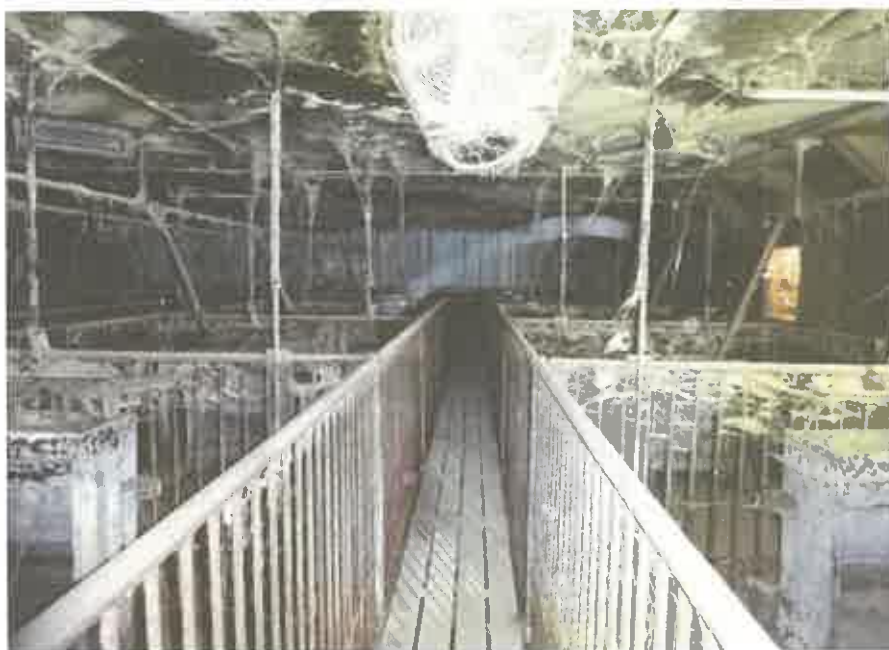
物件1 1建物（畜舎）内部の状況
