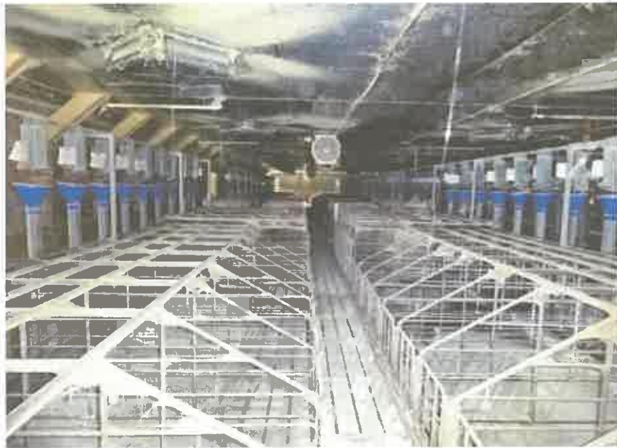
物件1 1建物（畜舎）内部の状況
