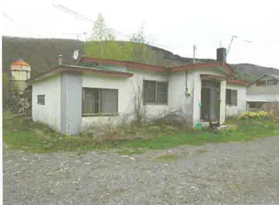
物件1 2建物の居宅部分の外観
