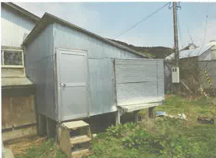
木製仮設物置
