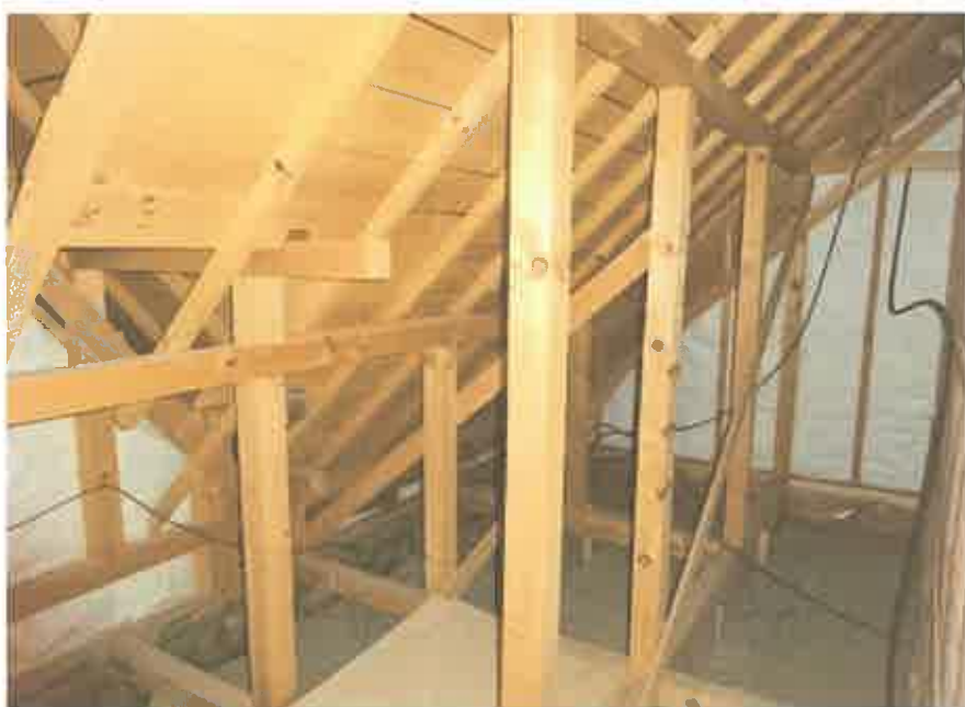
2 階小屋裏（納戸）の状況
