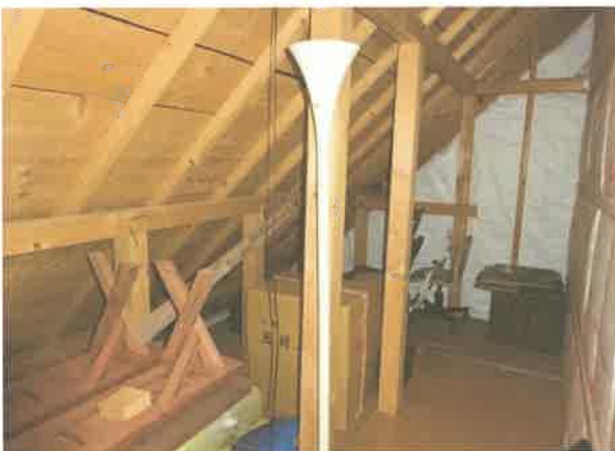
2 階小屋裏（納戸）の状況
