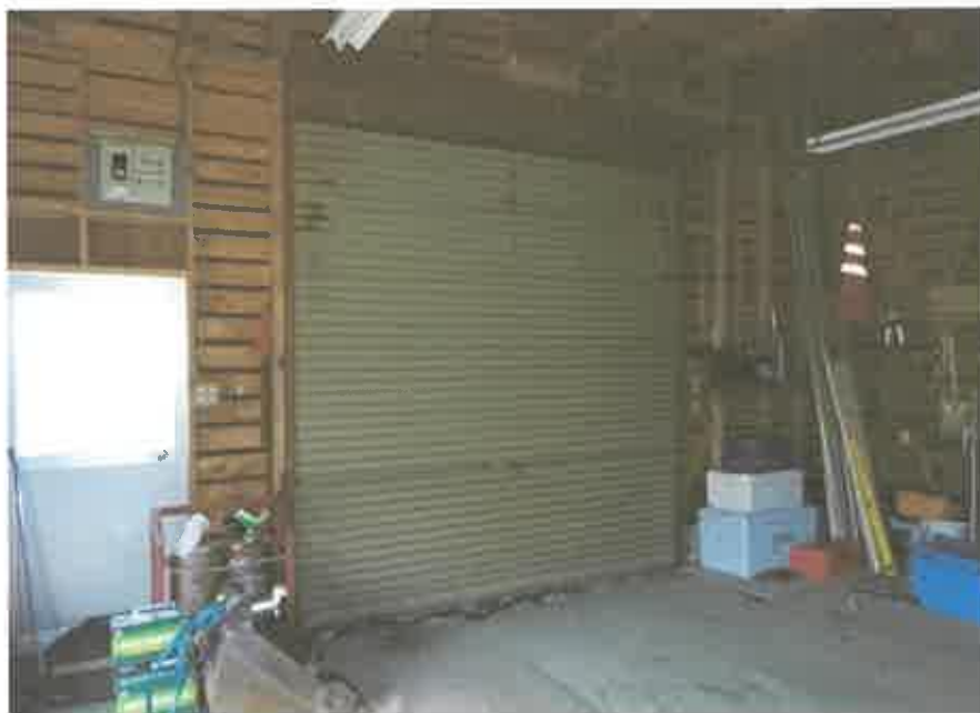
1 階（作業所）の状況
