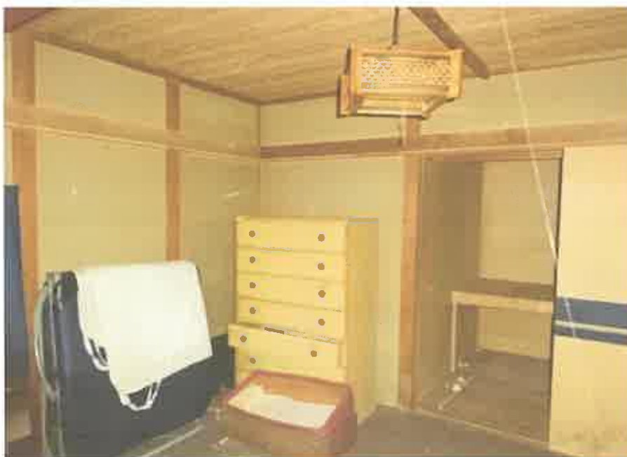
1 階居宅部分の和室 2
