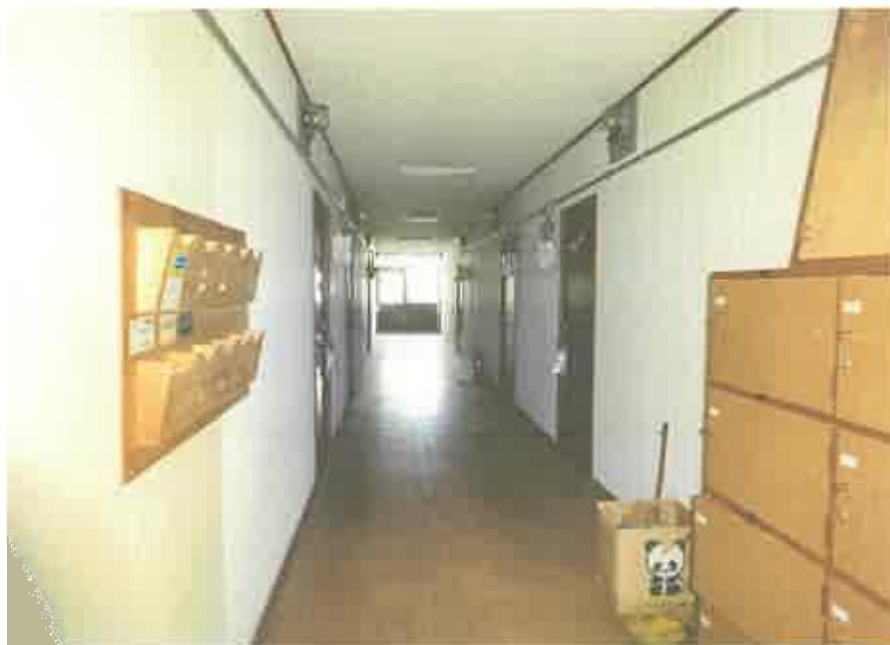
2 階共同住宅部分の廊下の状況
