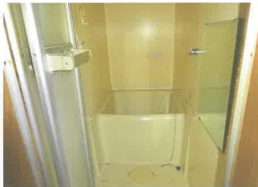
2階共同住宅部分の202号室の浴室
