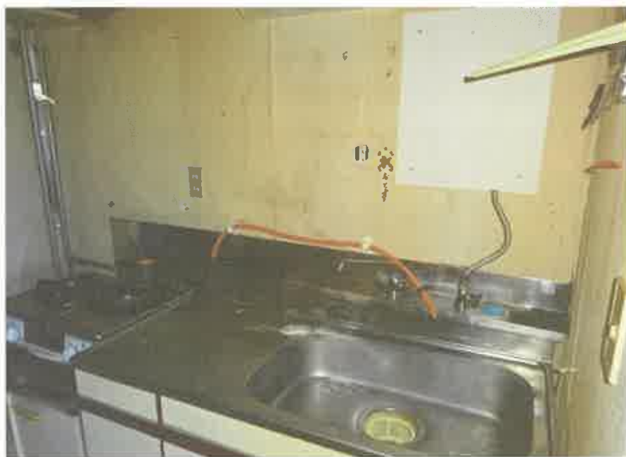
2階共同住宅部分の206号室の台所
