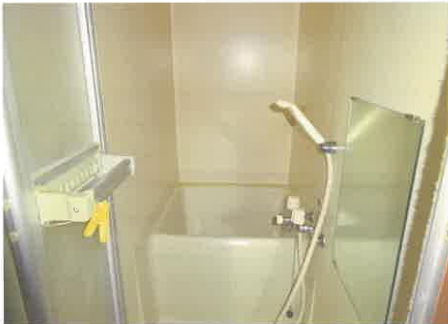
2階共同住宅部分の210号室の浴室
