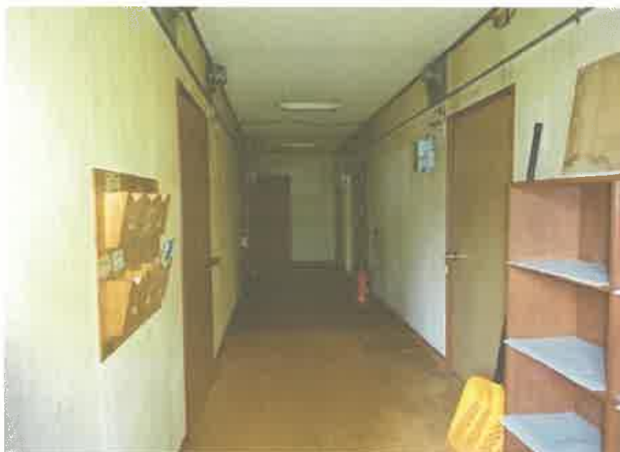
1 階共同住宅部分の廊下の状況
