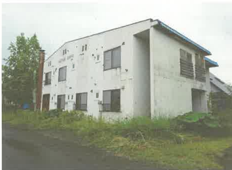
本件建物の外観、本件土地の状況
