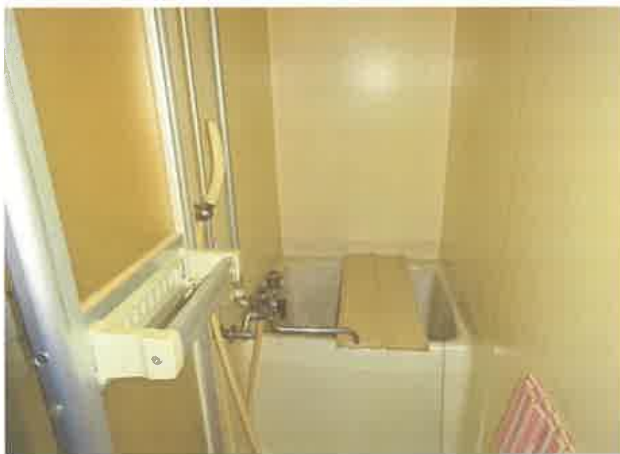
2階共同住宅部分の207号室の浴室
