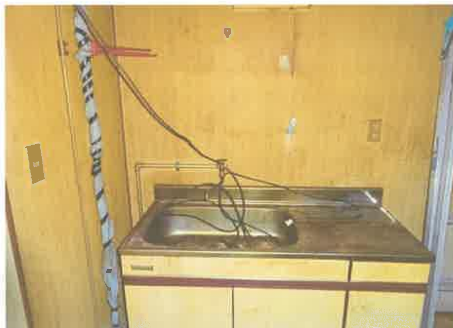
1階共同住宅部分の10号室の台所
