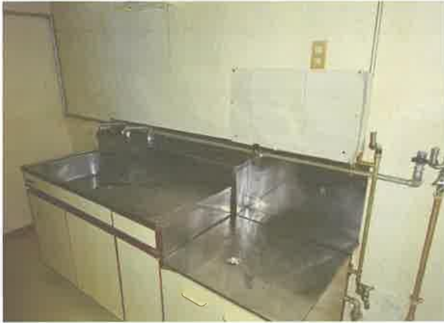
2階共同住宅部分の210号室の台所
