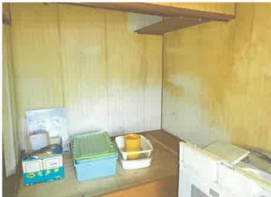
1階共同住宅部分の10号室の居間
