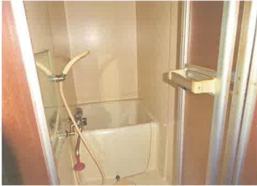
2階共同住宅部分の208号室の浴室
