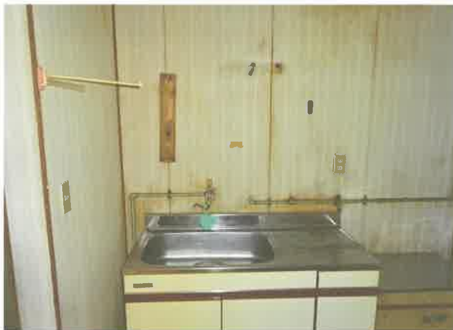
1階共同住宅部分の11号室の台所
