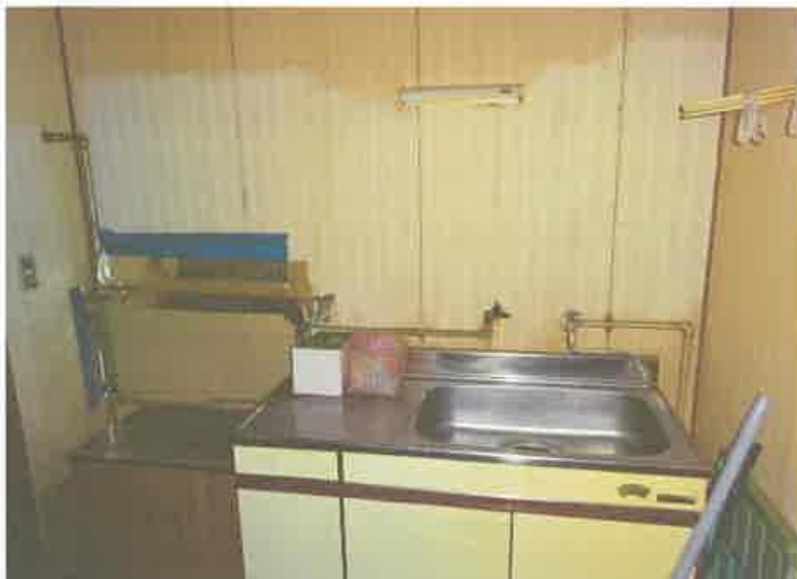
1 階共同住宅部分の 1 5 号室の台所
