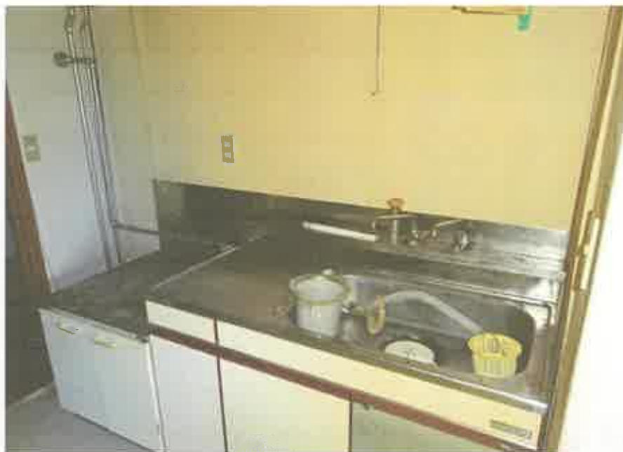
2 階共同住宅部分の 2 0 3 号室の台所
