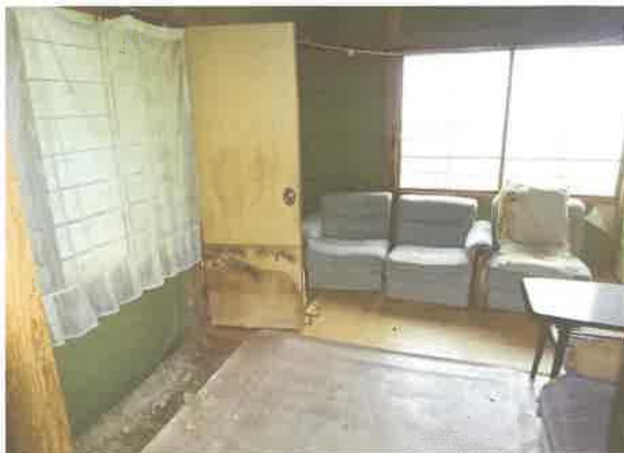
1 階居宅部分の和室 3
