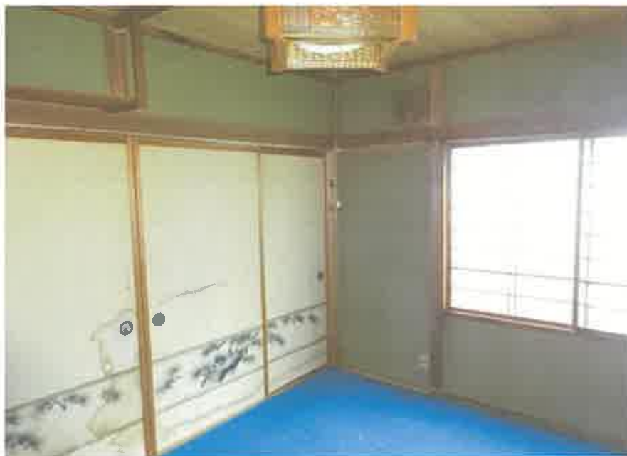
1 階居宅部分の和室 1
