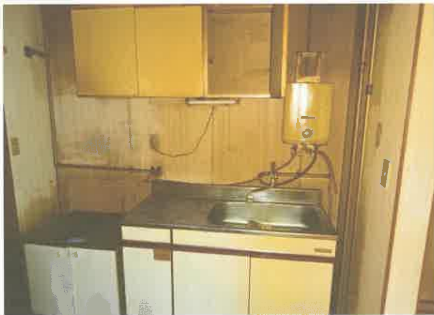
1階共同住宅部分の12号室の台所
