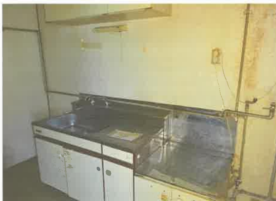
2階共同住宅部分の202号室の台所
