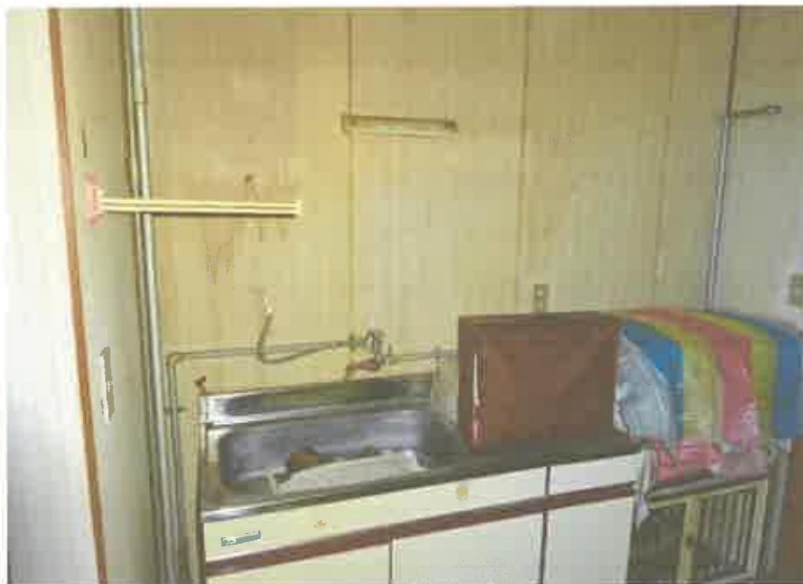
1階共同住宅部分の13号室の台所
