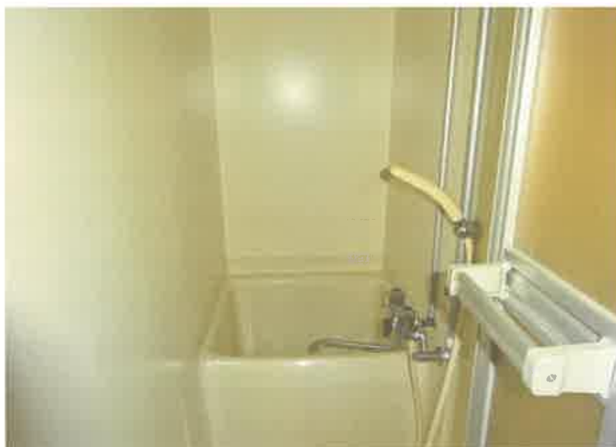
2 階共同住宅部分の 2 0 3 号室の浴室
