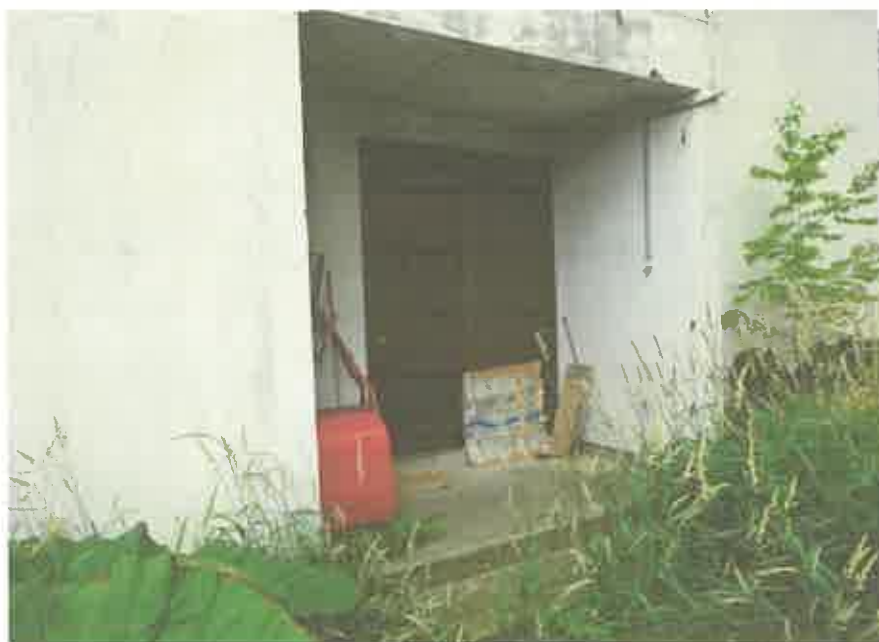
1 階共同住宅部分の入口玄関の状況
