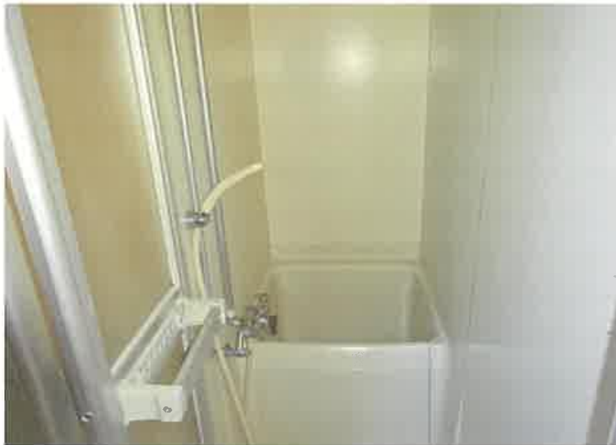
2階共同住宅部分の205号室の浴室
