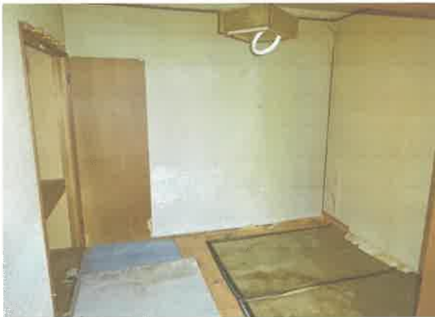
2階共同住宅部分の208号室の和室
