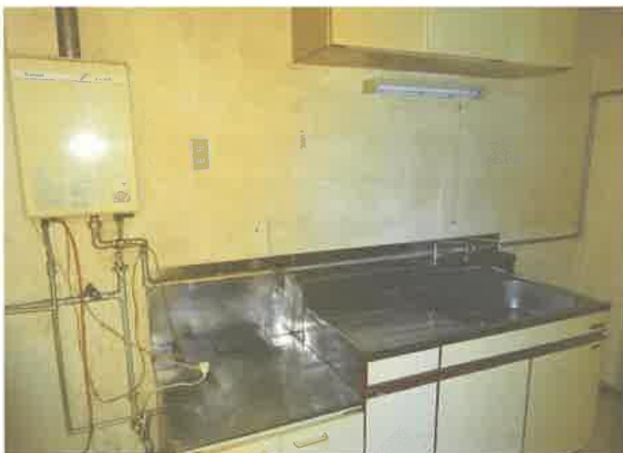
2階共同住宅部分の201号室の台所
