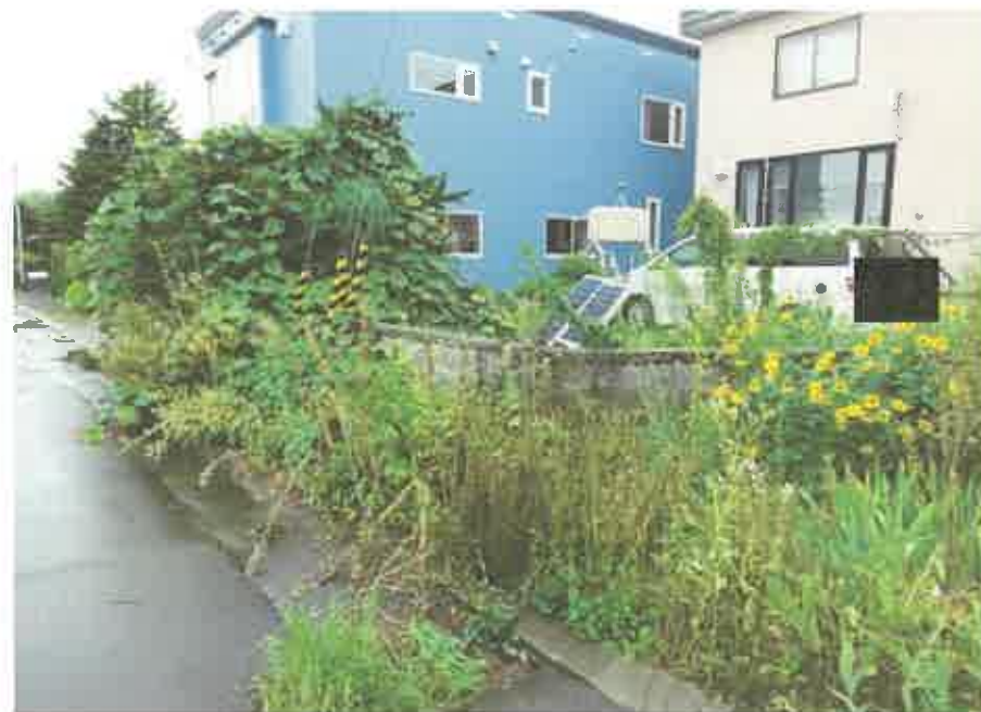
コンクリートブロック塀の状況
