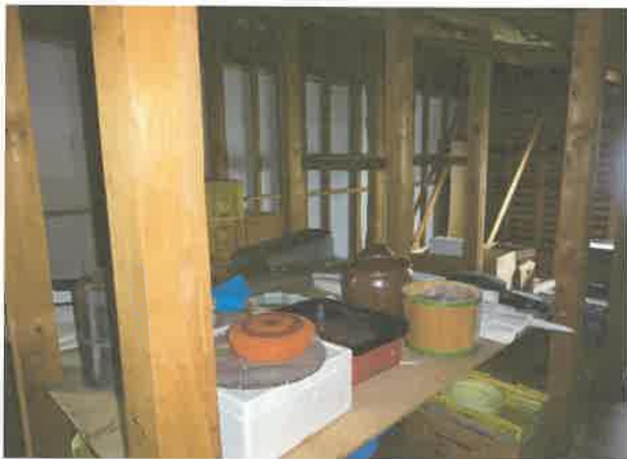
2 階小屋裏の状況
