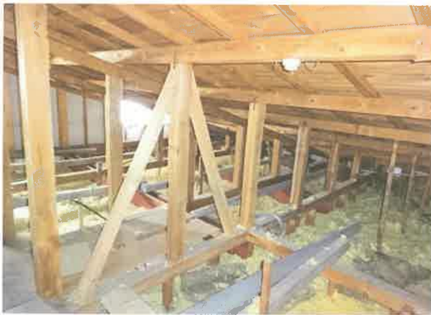
2 階小屋裏の状況（鉄骨梁により補強）
