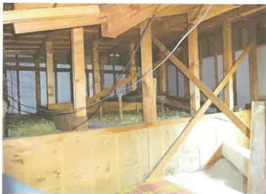
2 階小屋裏の状況
