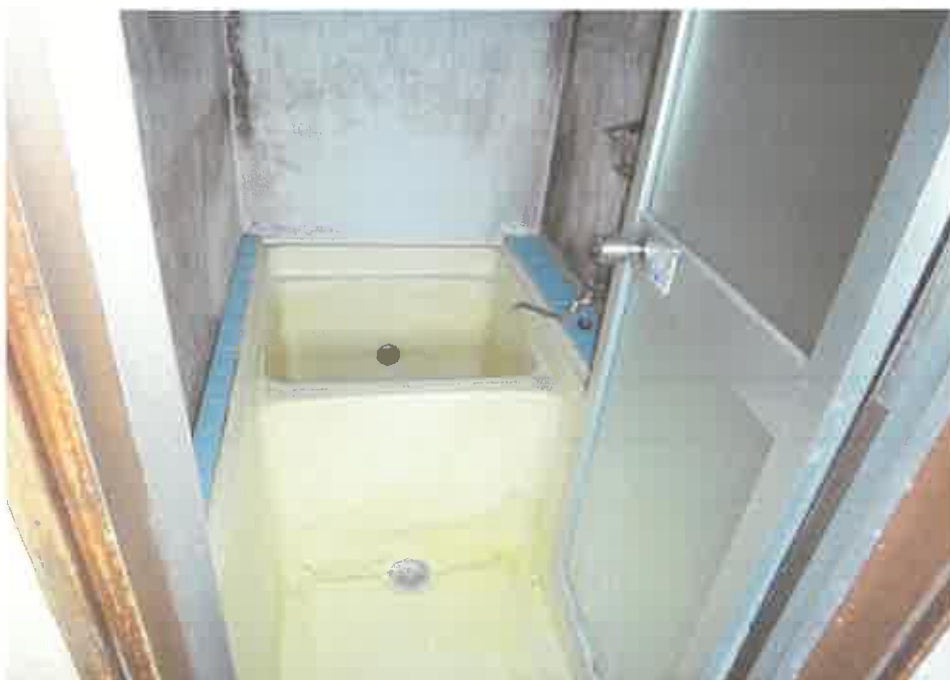
1号室1階の浴槽
