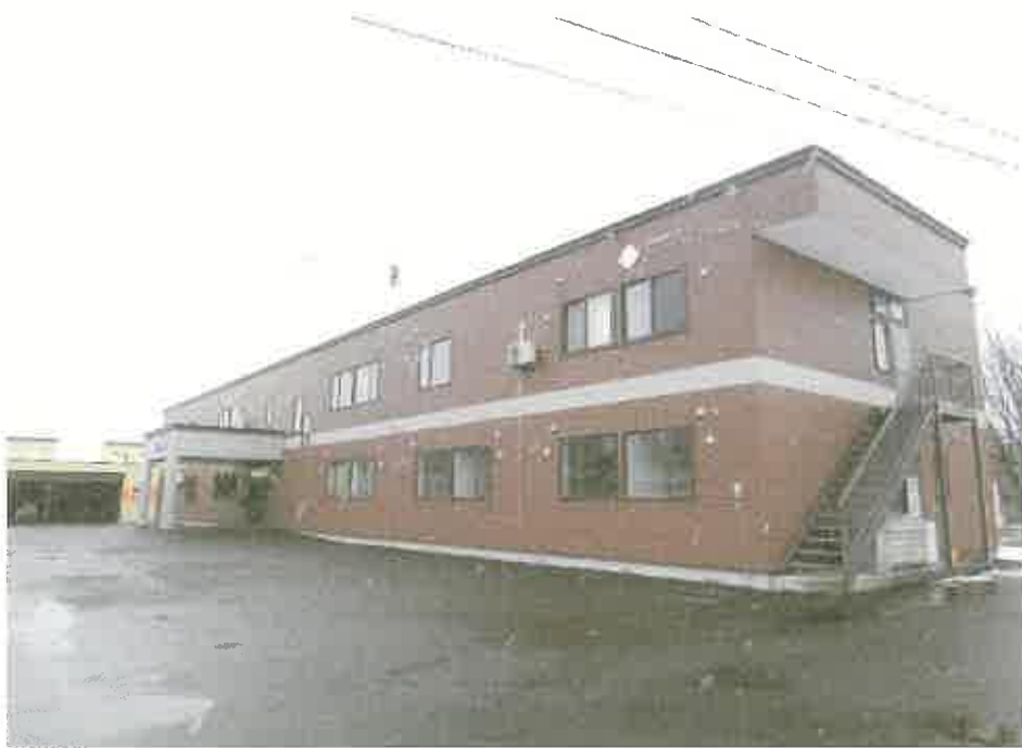
本件建物の外観、物件1の土地の形状
