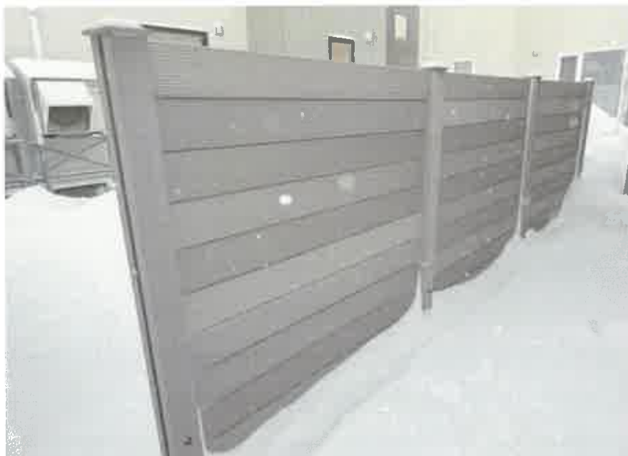
樹脂製フェンス (本件土地の北西側に存在)
