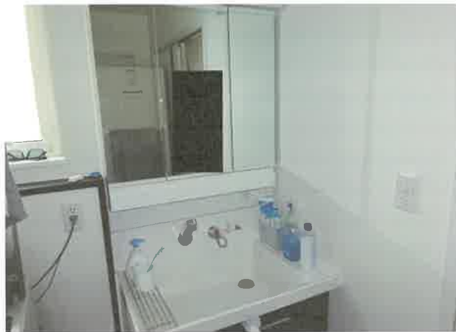
1階洗面脱衣室
