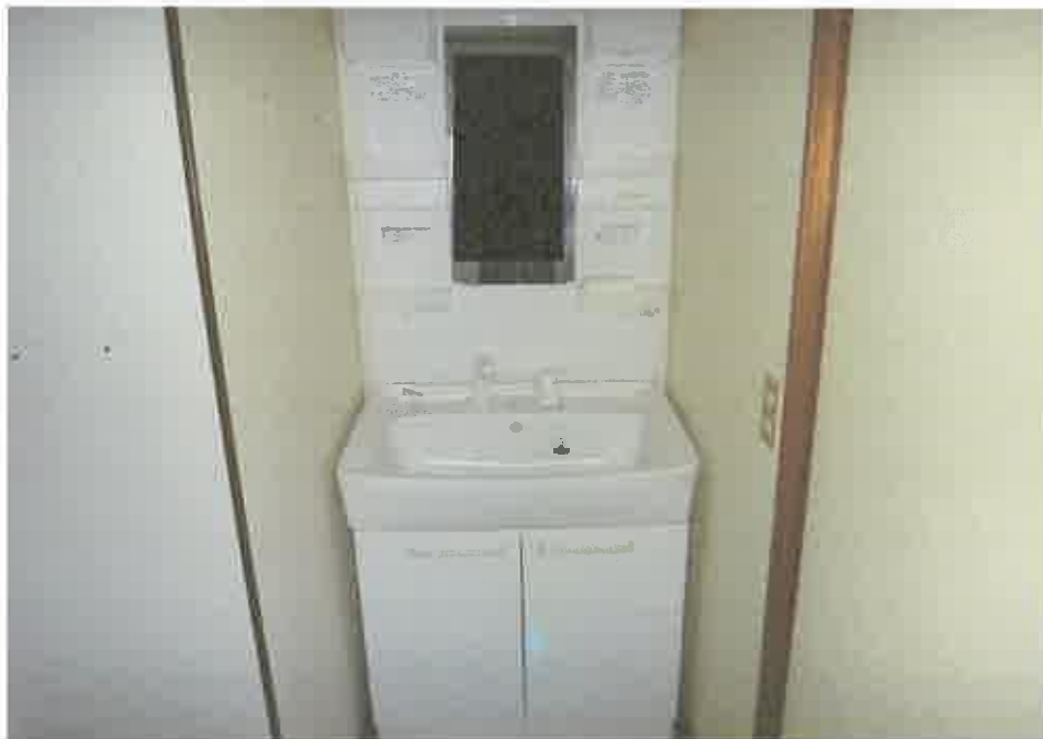
2階ユーティリティ内の洗面台
