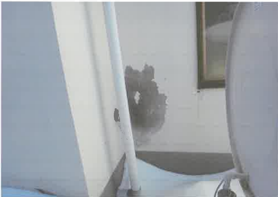
外壁の一部剥離
