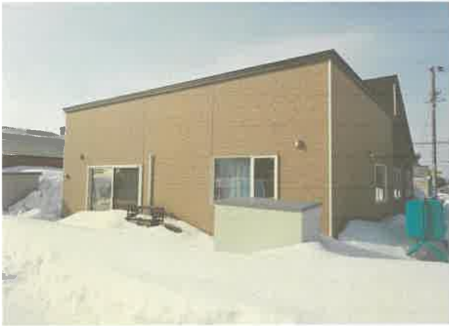
本件建物の外観、本件土地の形状、スチール製仮設物置 2
