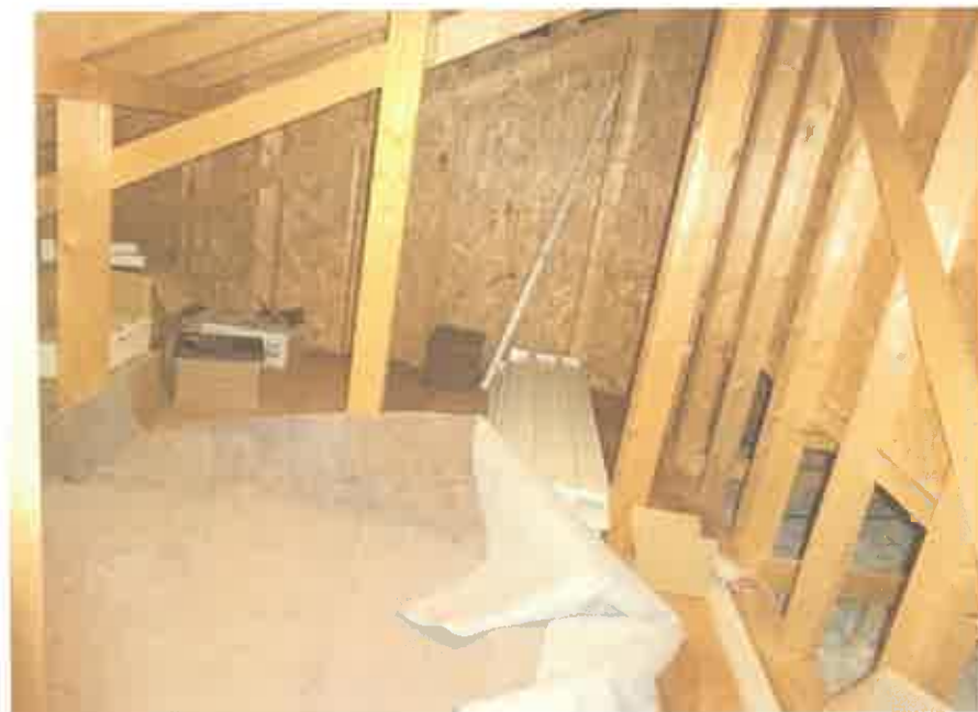
屋根裏の状況
