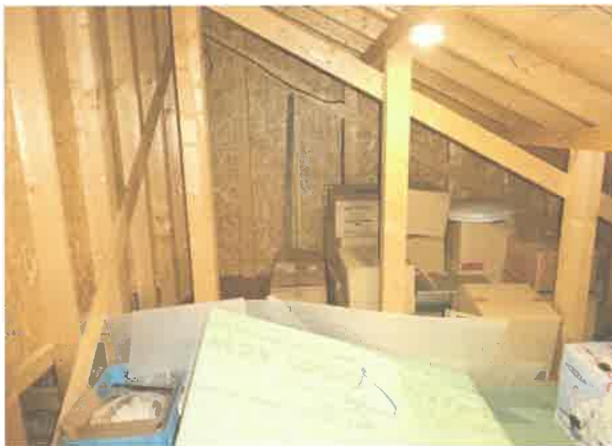
屋根裏の状況
