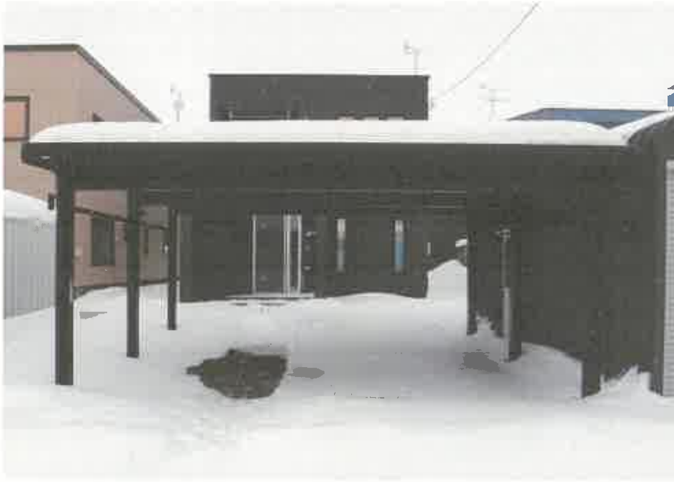
鉄骨造カーポート
