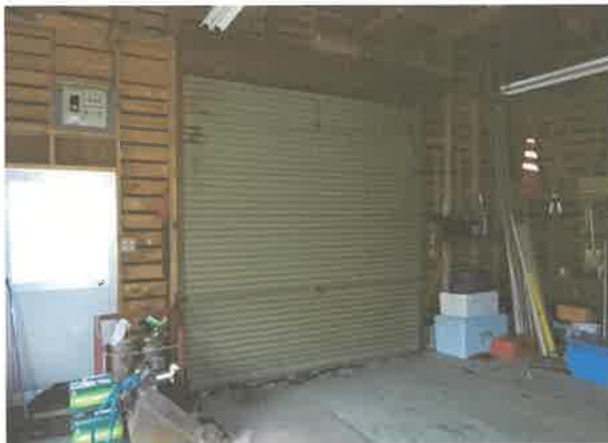
1階（作業所）の状況
