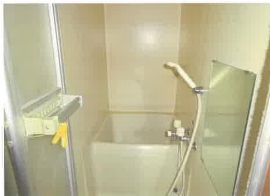
2階共同住宅部分の210号室の浴室
