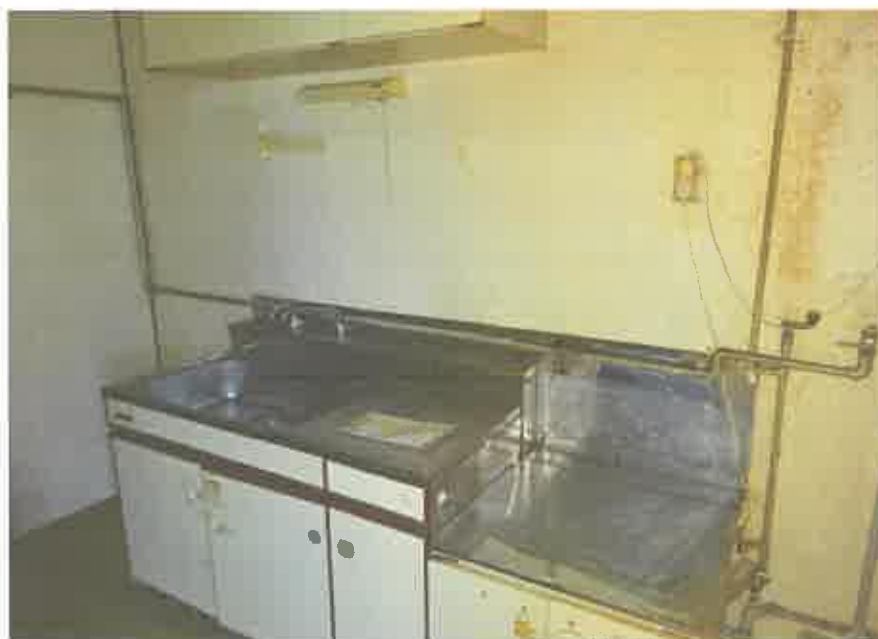
2階共同住宅部分の202号室の台所
