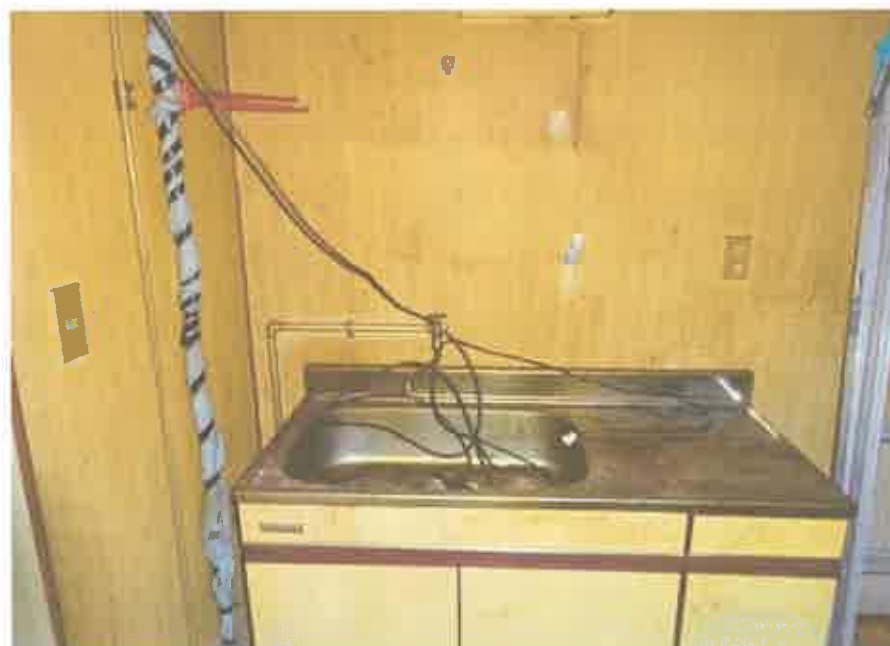
1階共同住宅部分の10号室の台所
