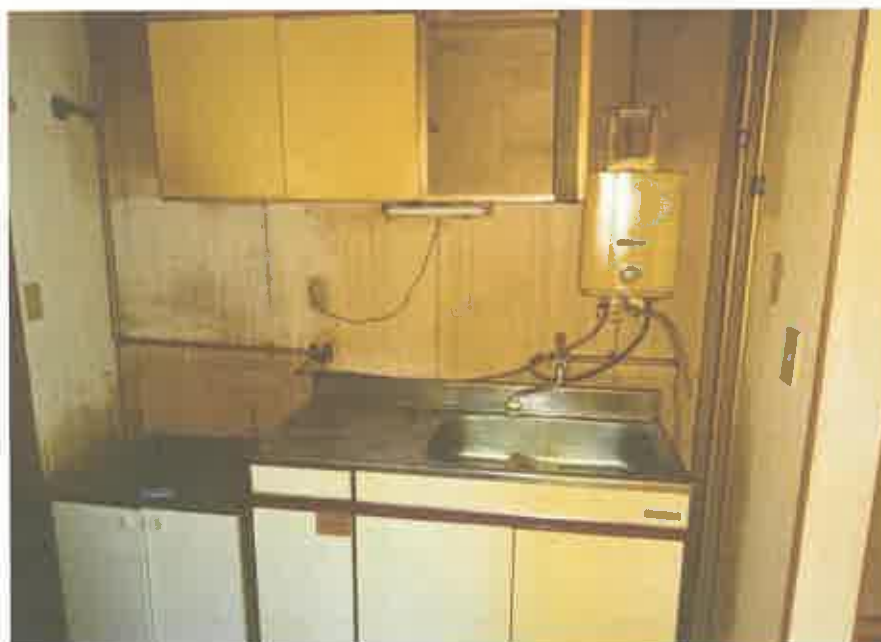
1階共同住宅部分の12号室の台所
