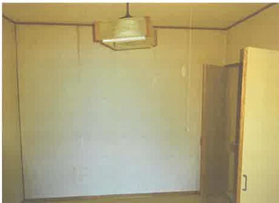
2階共同住宅部分の202号室の和室
