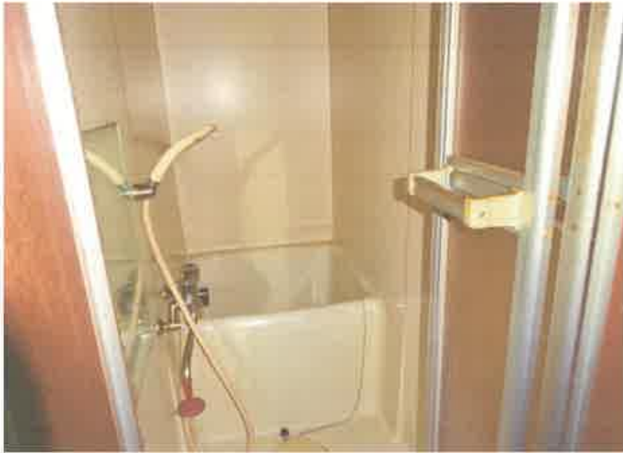
2階共同住宅部分の208号室の浴室
