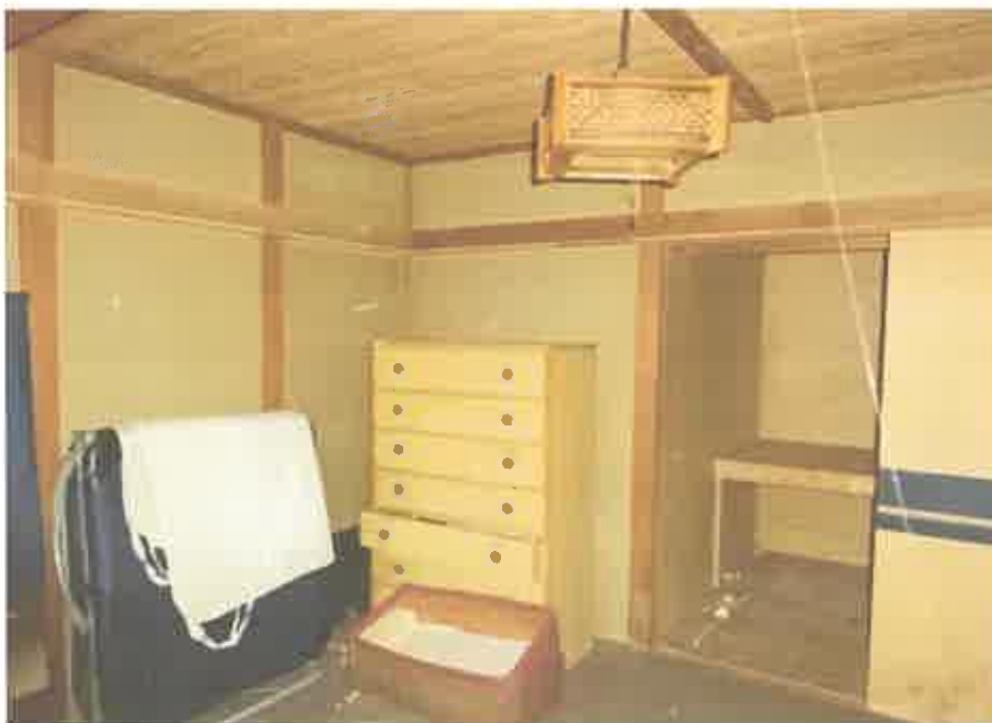
1階居宅部分の和室2
