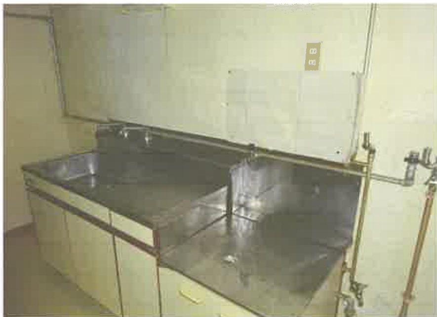
2階共同住宅部分の210号室の台所
