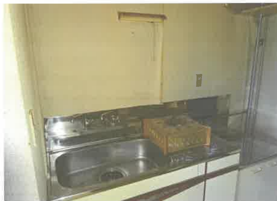
2階共同住宅部分の205号室の台所
