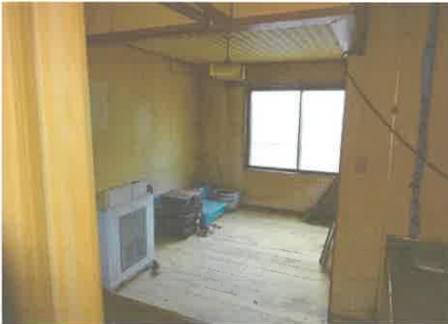
1階共同住宅部分の10号室の居間
