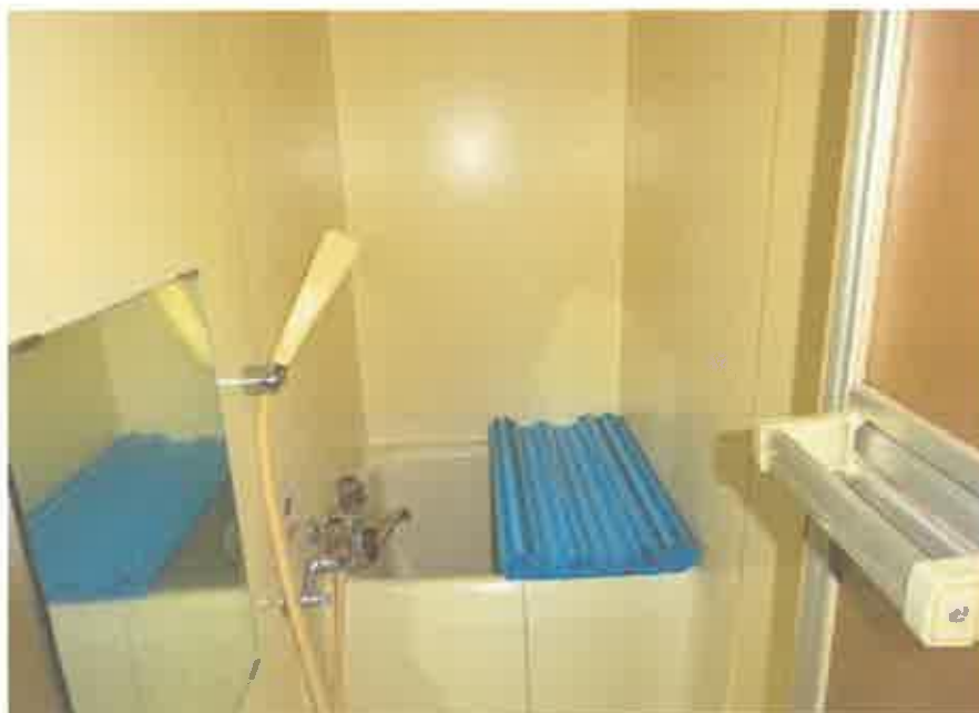
2階共同住宅部分の201号室の浴室
