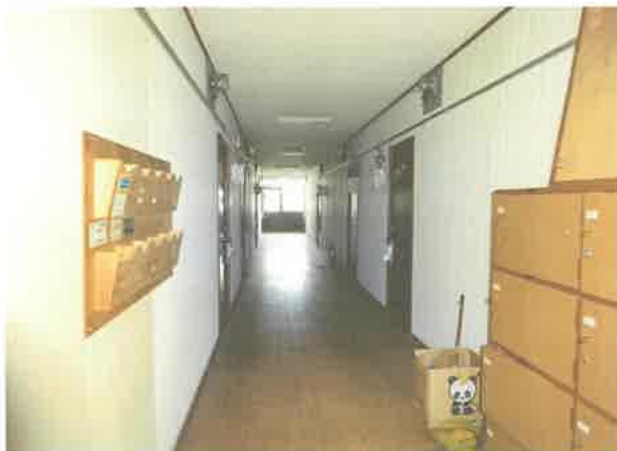
2階共同住宅部分の廊下の状況
