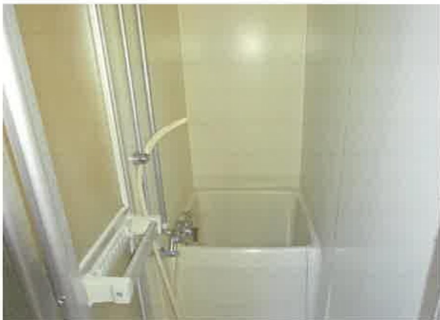
2階共同住宅部分の205号室の浴室
