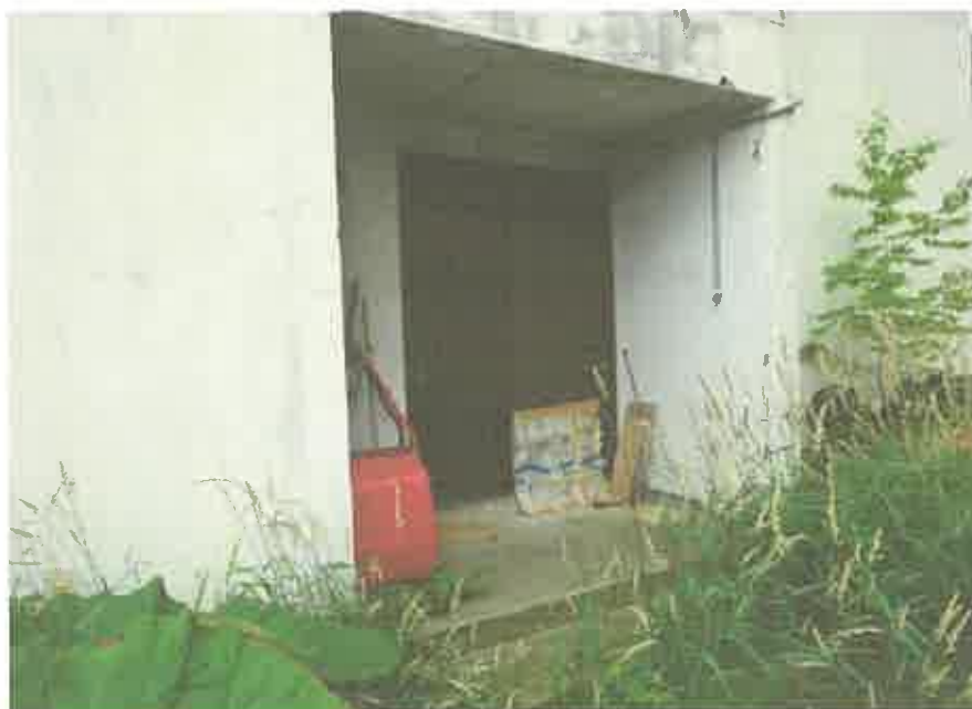
1階共同住宅部分の入口玄関の状況
