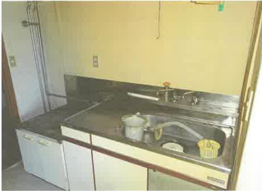
2階共同住宅部分の203号室の台所
