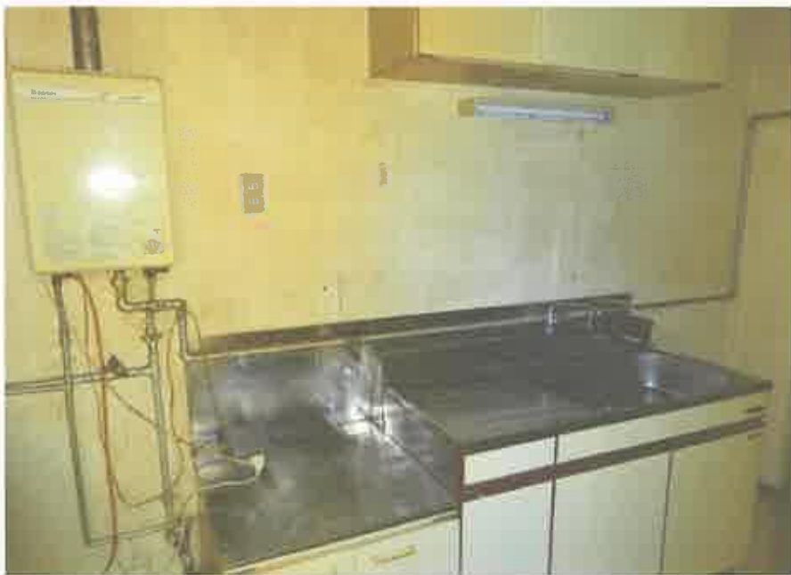
2階共同住宅部分の201号室の台所
