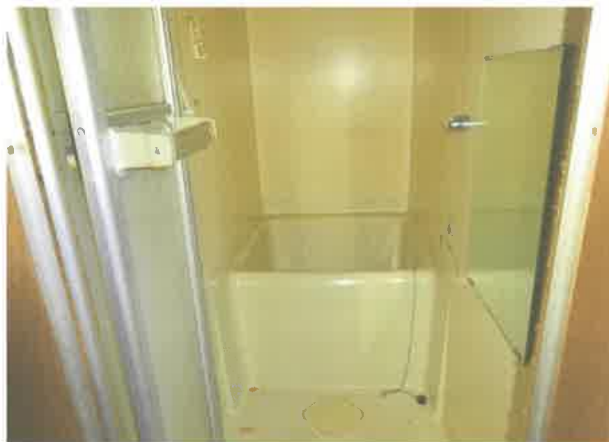
2階共同住宅部分の202号室の浴室
