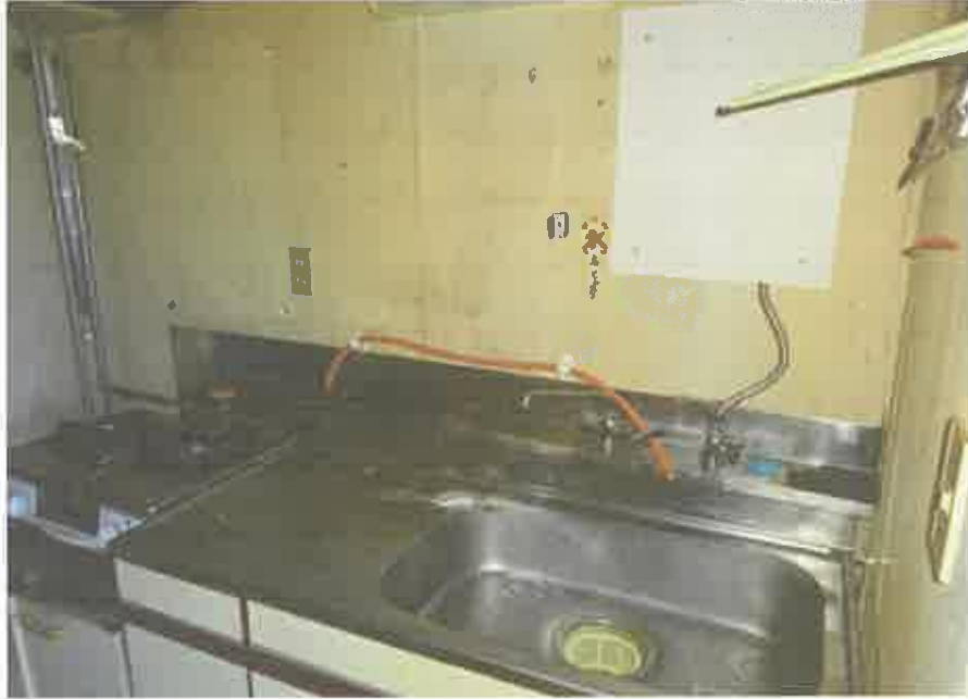
2階共同住宅部分の206号室の台所
