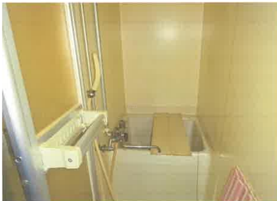
2階共同住宅部分の207号室の浴室
