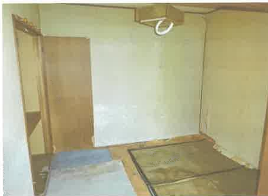
2階共同住宅部分の208号室の和室
