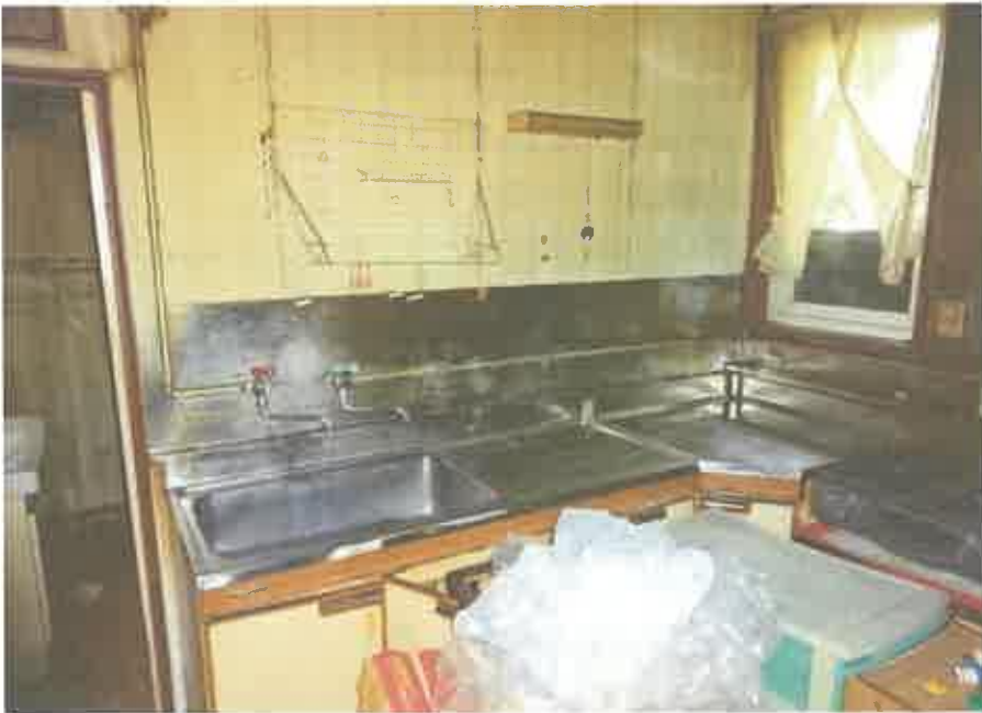
1階居宅部分の台所
