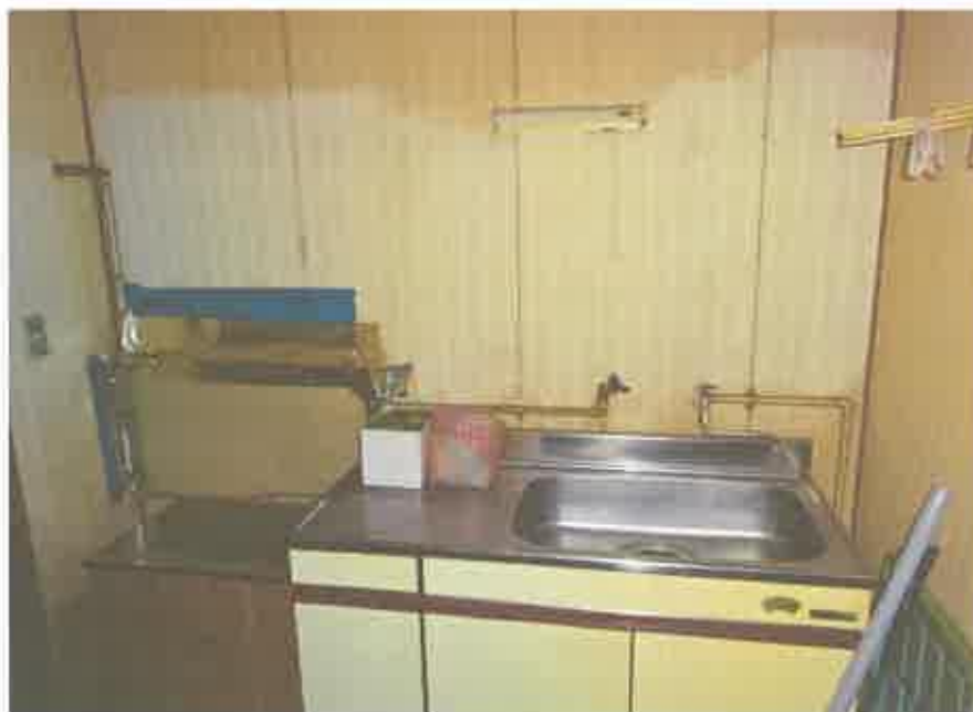
1階共同住宅部分の15号室の台所
