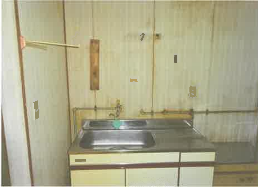
1階共同住宅部分の11号室の台所
