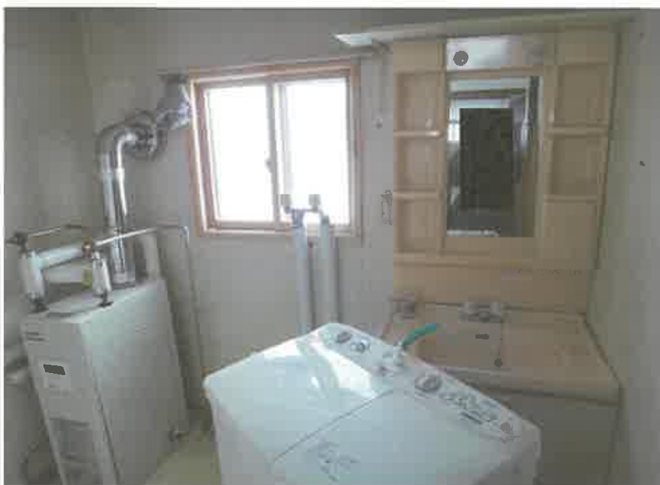
2階洗面、脱衣室
