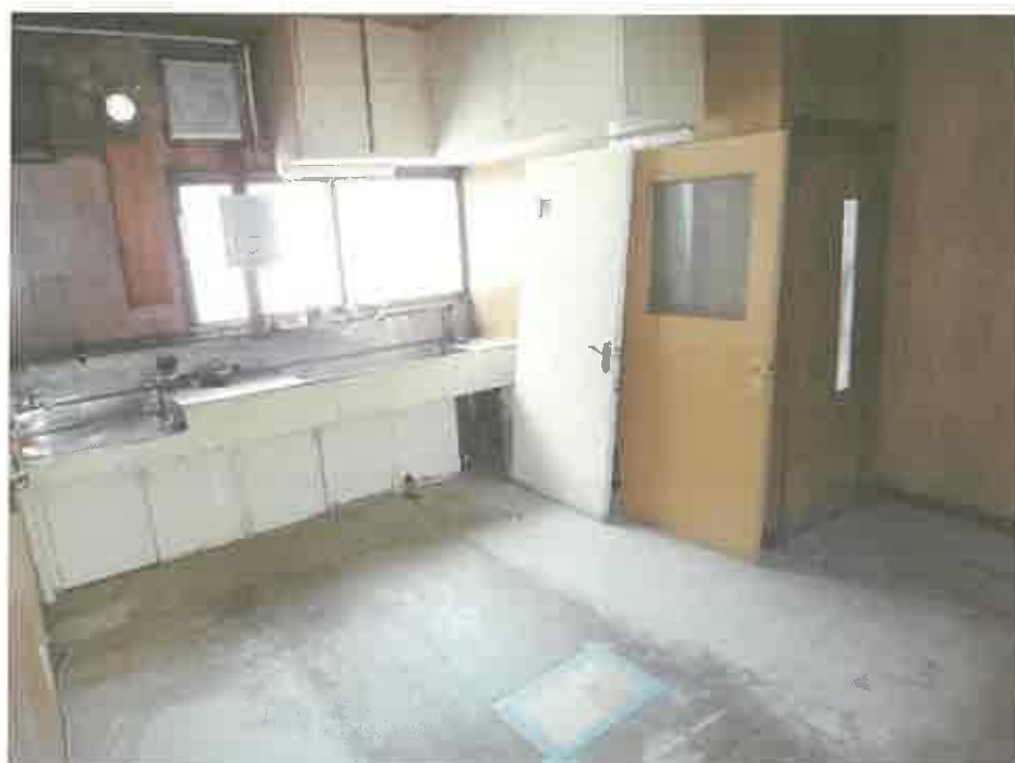
1階居間及び台所
