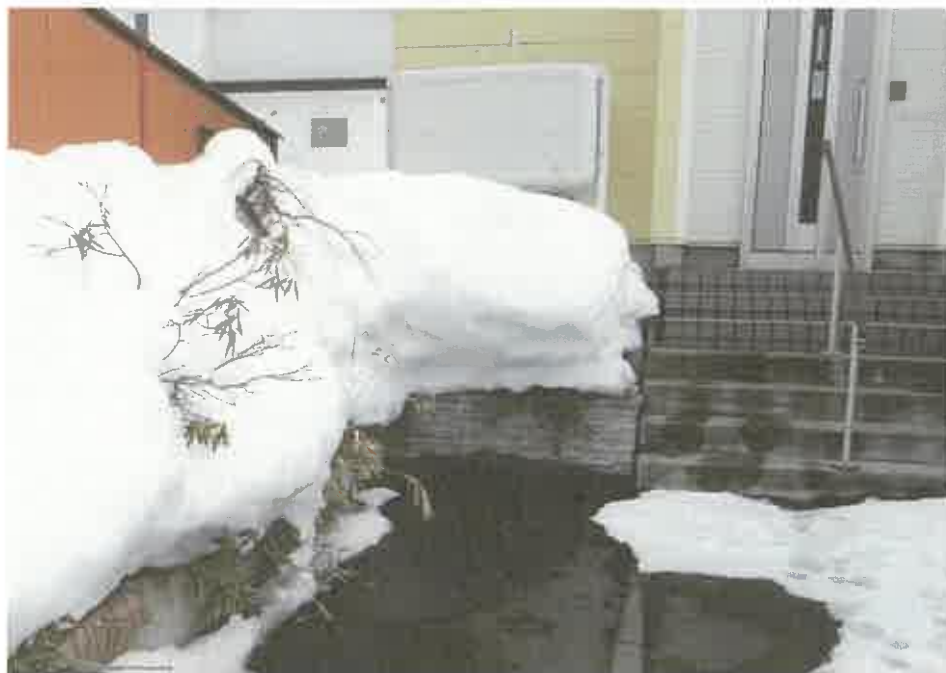
ブロック土止め
