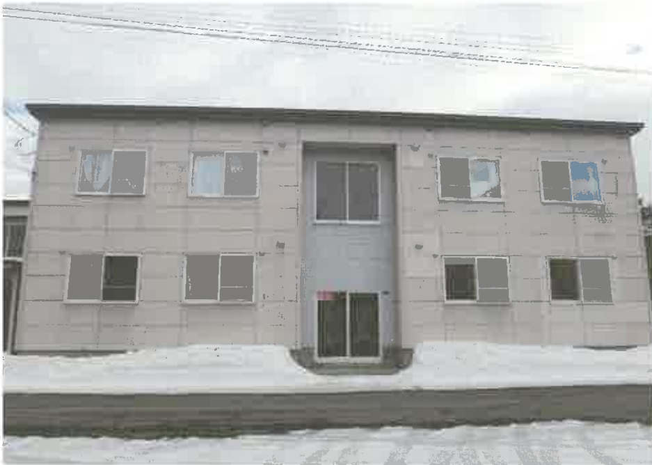
物件 7 の建物の外観、物件 5 の土地の形状
