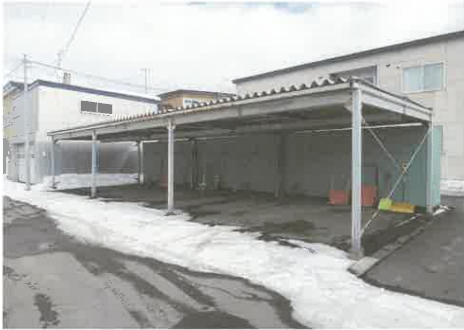
鉄骨造仮設カーポート 1
