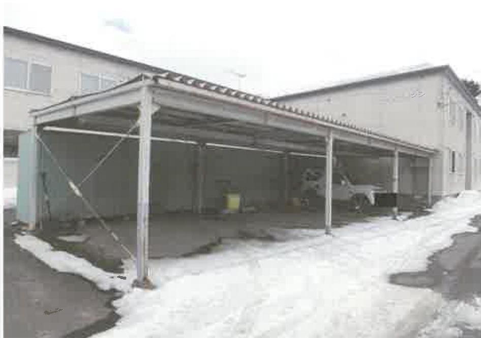
鉄骨造仮設カーポート 2
