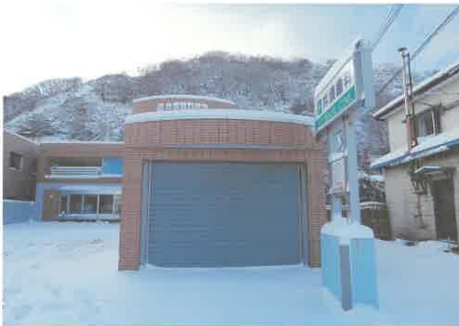
附属建物（車庫）
