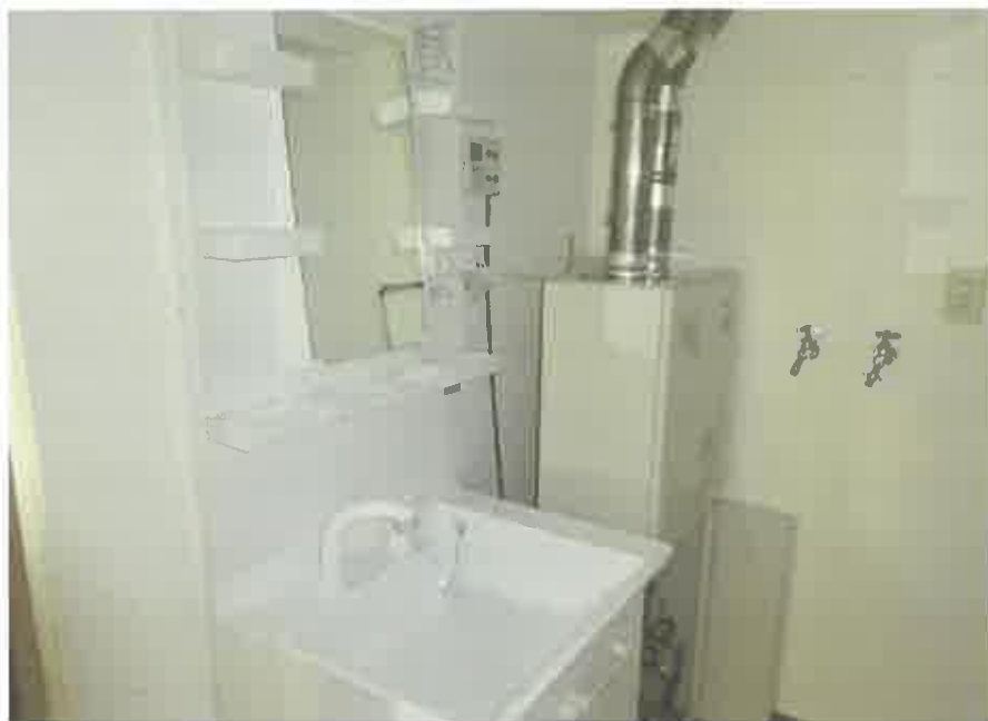
208号室の洗面所
