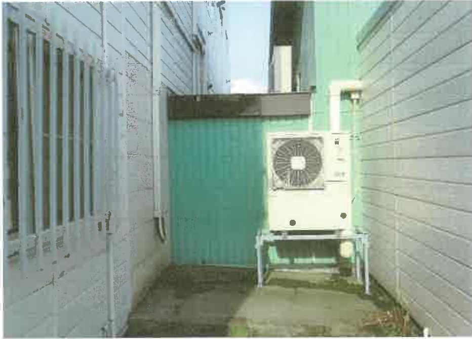
本件建物（左側）と附属建物符号2の工場（右側）を繋ぐ通路の増築部分
