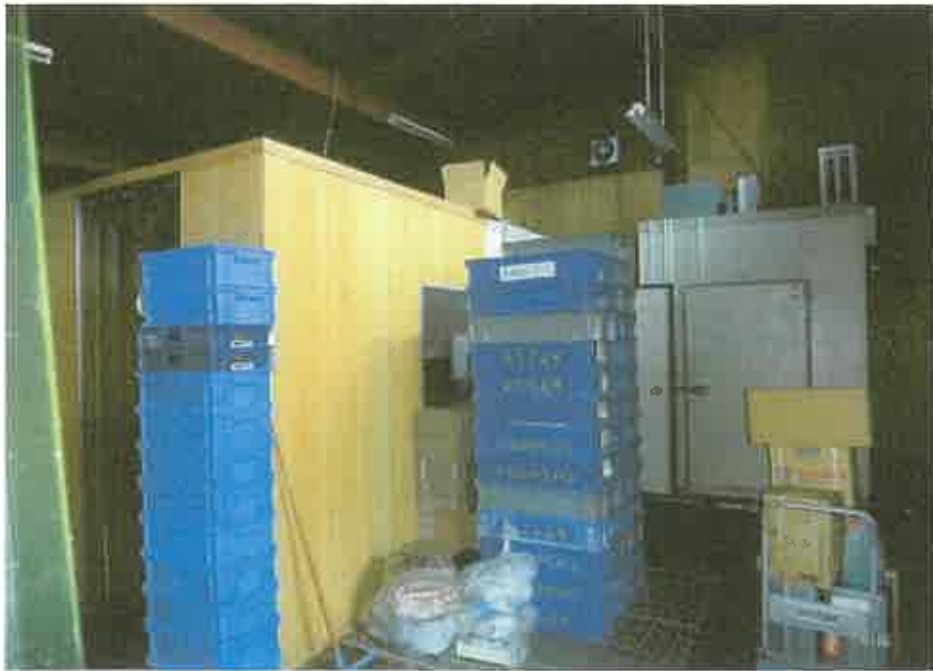
附属建物符号 1 の倉庫（写真左側に箱詰室、その奥に冷凍庫、右奥に冷蔵庫）
