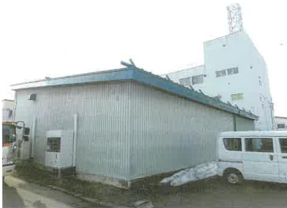
附属建物符号1の倉庫（手前側）及び同2の工場（奥側）の外観、本件土地の形状
