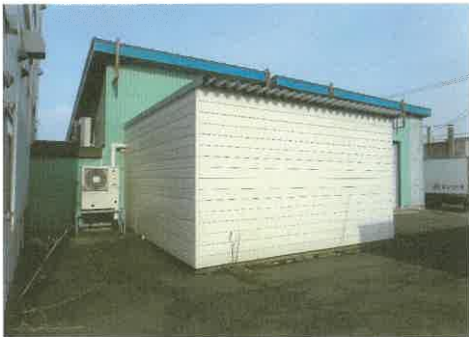
附属建物符号2の工場の増築部分
