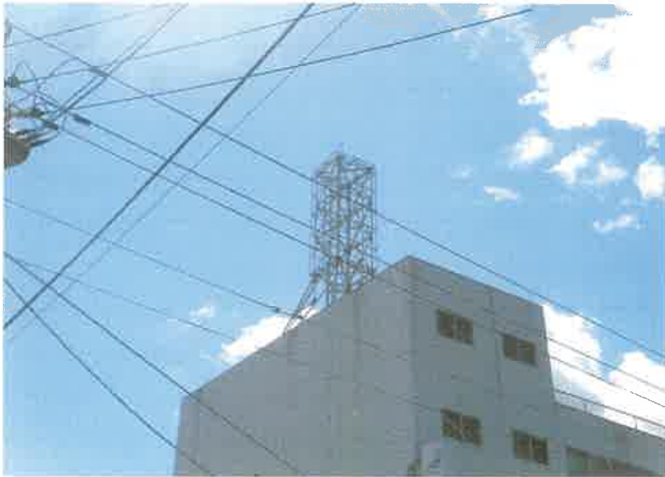
4 階屋上に設置されている看板用鉄塔（鉄骨の枠のみ）
