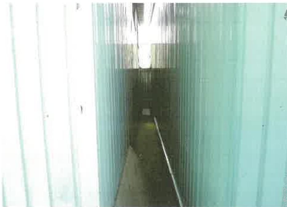
附属建物符号1の倉庫（左側）と同2の工場（右側）を繋ぐ通路の増築部分
