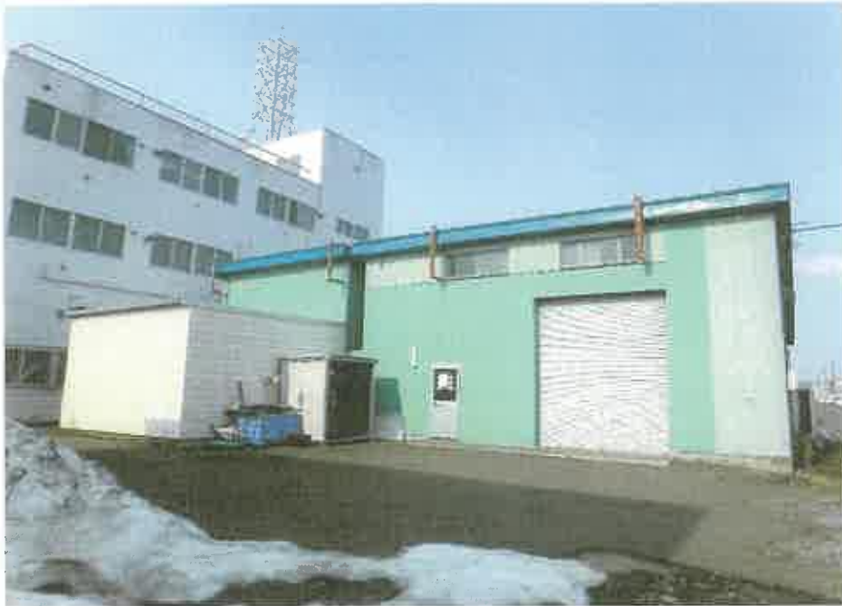
附属建物符号1の倉庫（右側）及び同2の工場（左側）の外観、本件土地の形状
