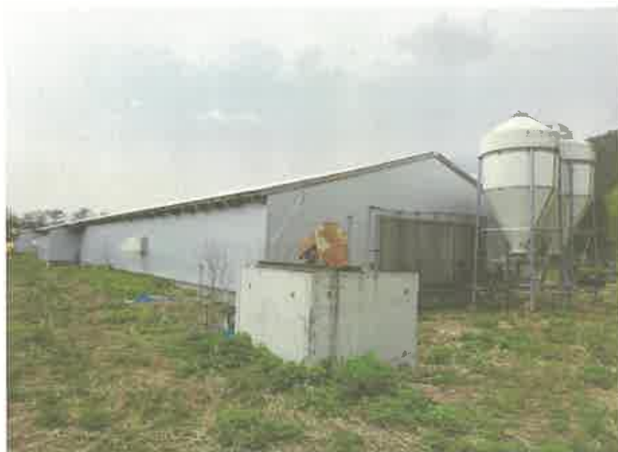
物件 1 1 建物（畜舎）
