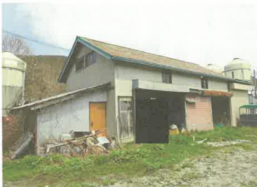
物件1 2 建物の未登記附属建物②の外観
