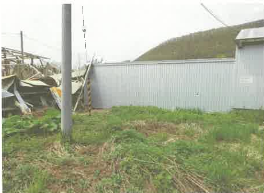
物件 1 1 建物（畜舎）と物件 1 2 建物の附属建物（符号 1 ・ 畜舎）の間の通路 部分（増築）
