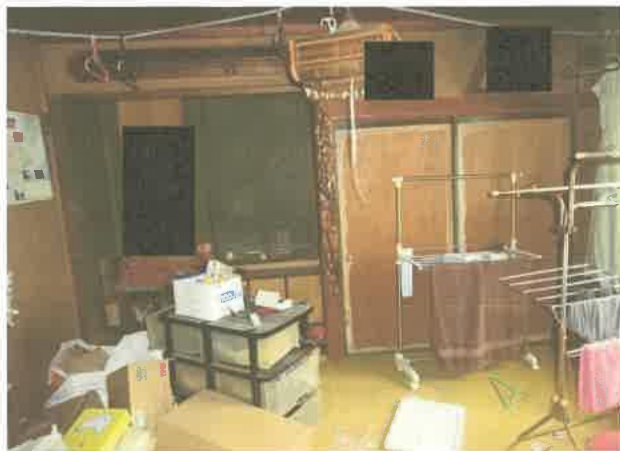
物件1 2 建物のうち、居宅部分の和室2
