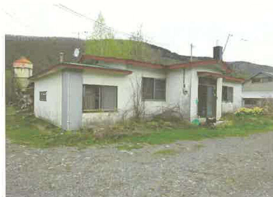
物件 1 2 建物の居宅部分の外観
