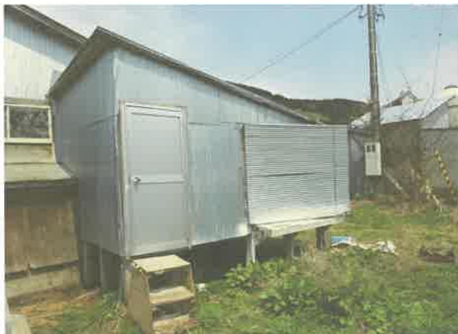
木製仮設物置
