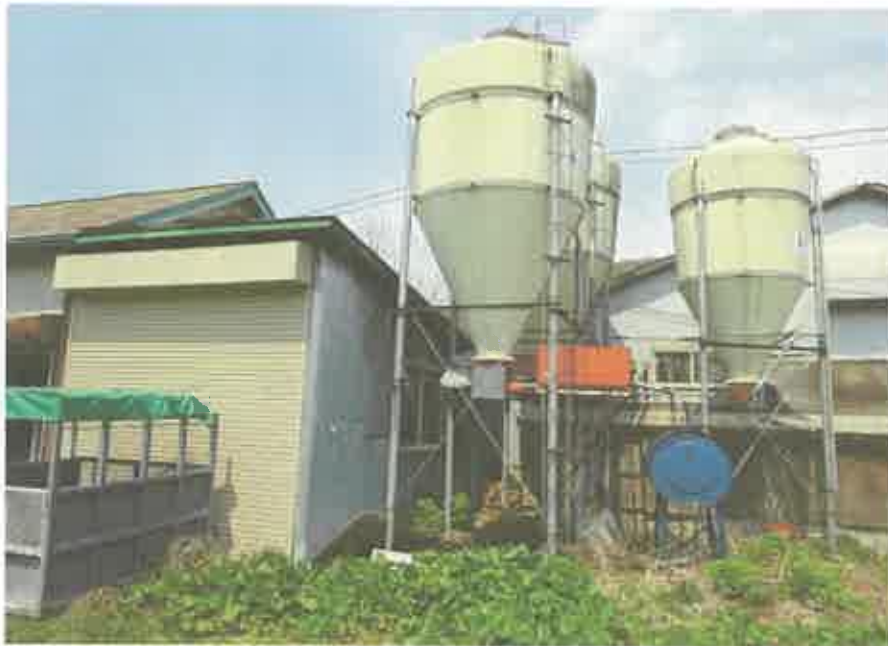
物件1 2 建物のうち、畜舎の残存部分
