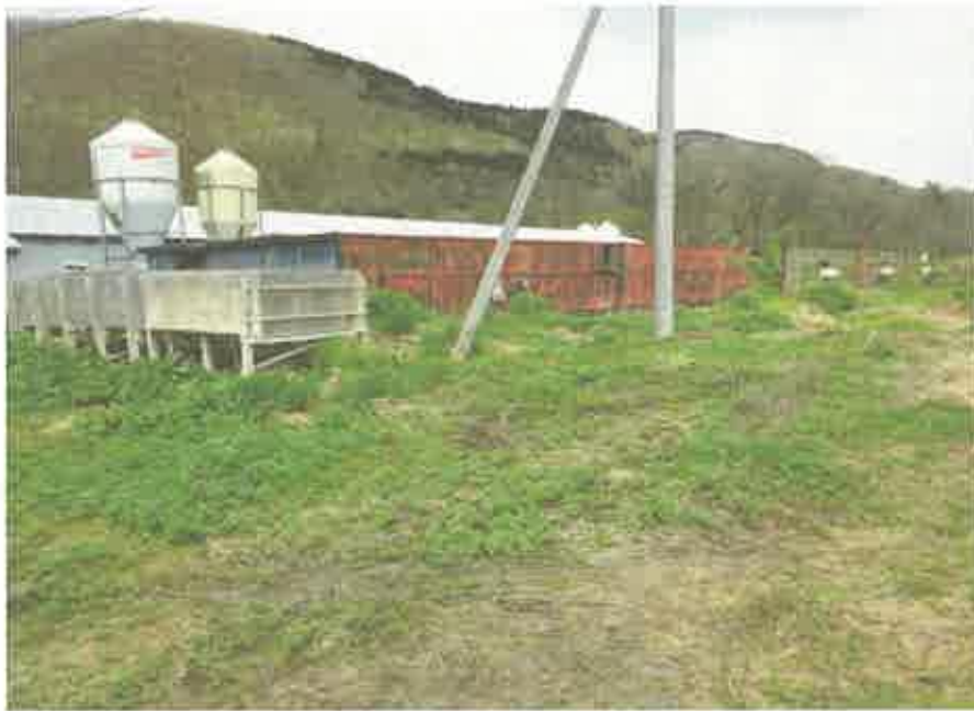
木・鉄骨製仮設畜舎
