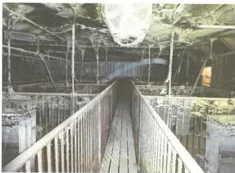
物件1 1建物（畜舎）内部の状況
