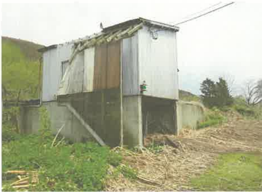
物件13建物（機械室）の外観
