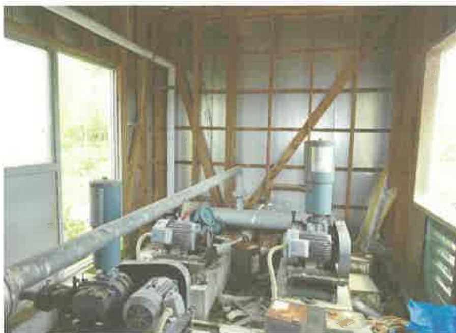
物件 1 3 建物（機械室）内部の状況
