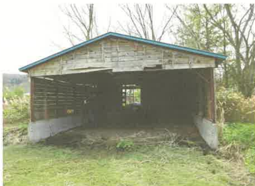
物件1 2 建物の未登記附属建物④（倉庫）の内部の状況
