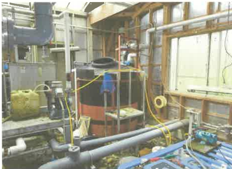
物件13建物（機械室）内部の状況
