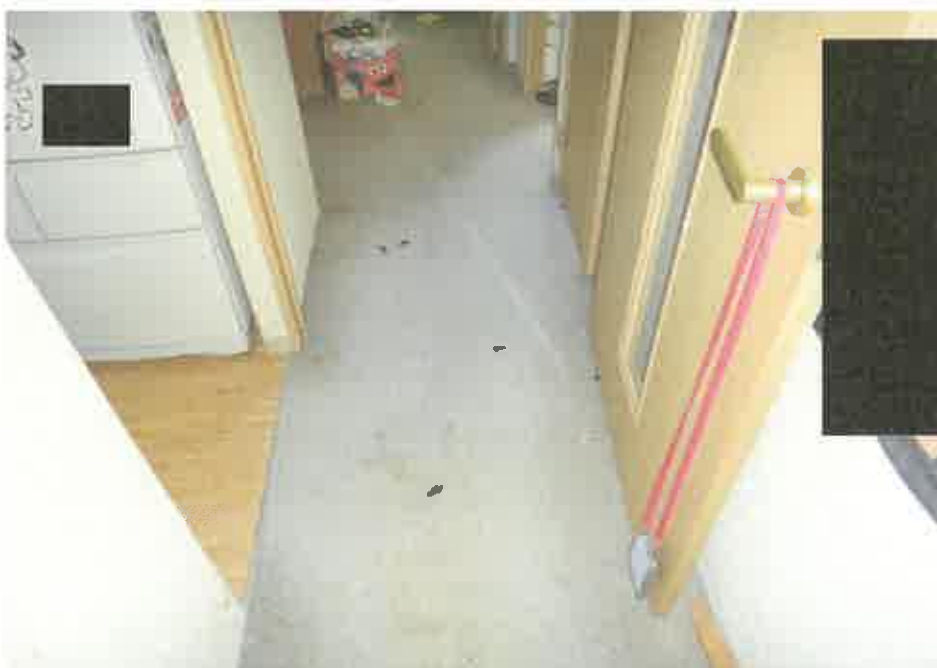
居間からホールに至る通路の汚損
